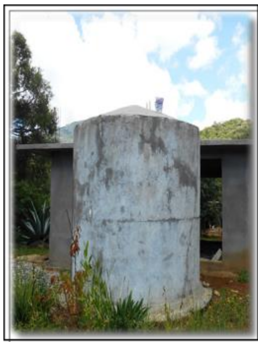
Figura1. Cisterna de ferrocemento
