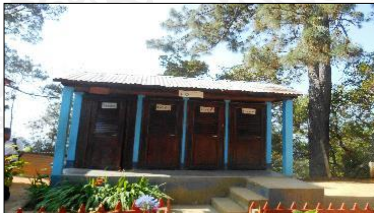
Figura30. Construcción de baños
