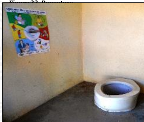
Figura34. Baño seco
