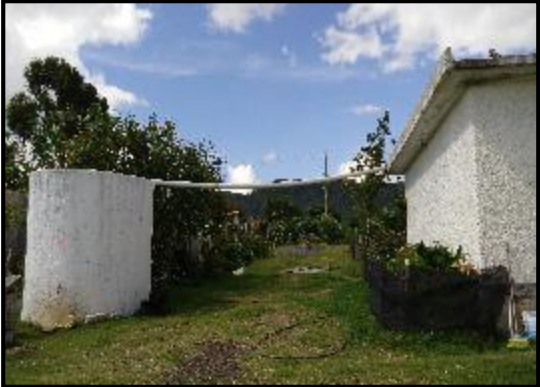
Figura8. Cisterna con biofiltro
