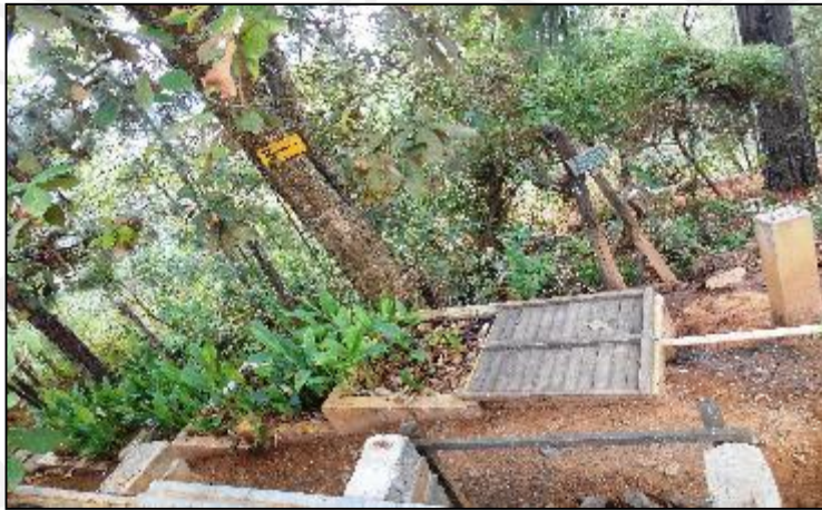
Figura29. Construcción de biofiltro
