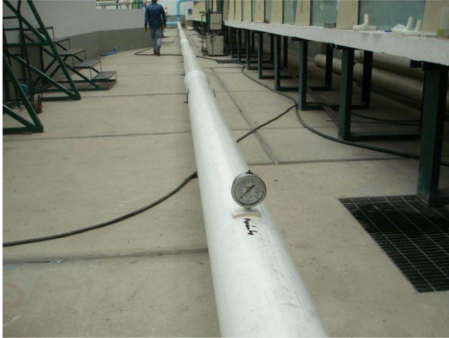
Foto 49. Manómetro tipo Bourdon instalado
