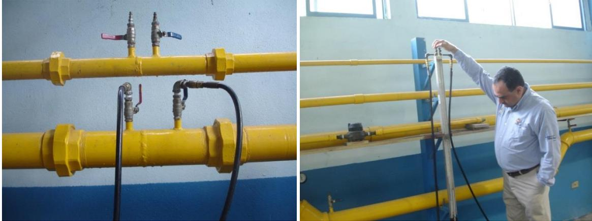
Fotos 13 y 14. Conexiones del tubo al manómetro
