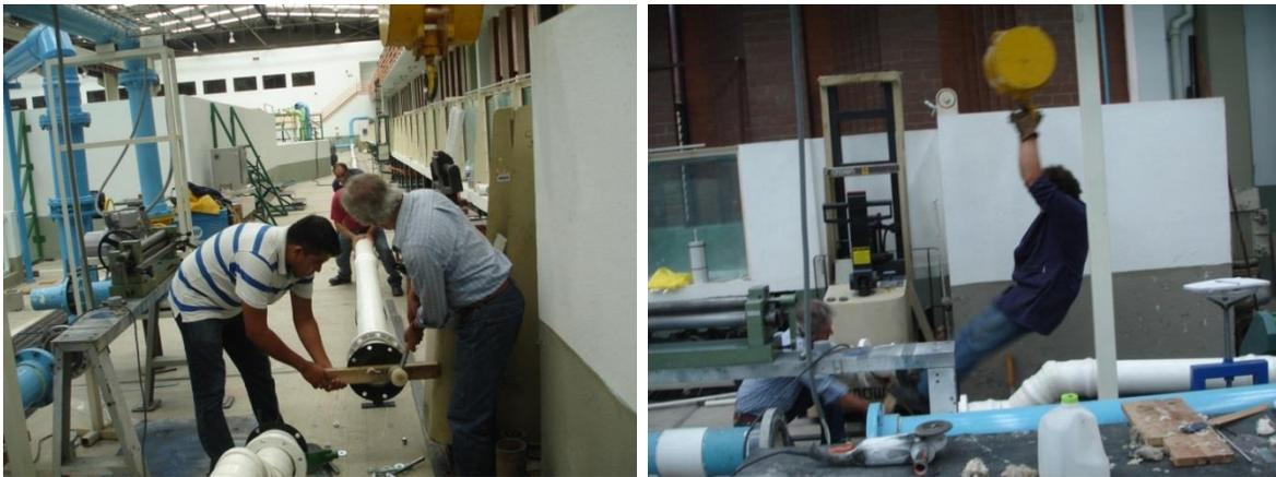
Fotos 32 y 33. Trabajos de instalación de tubo de 6 pulg. de diámetro
