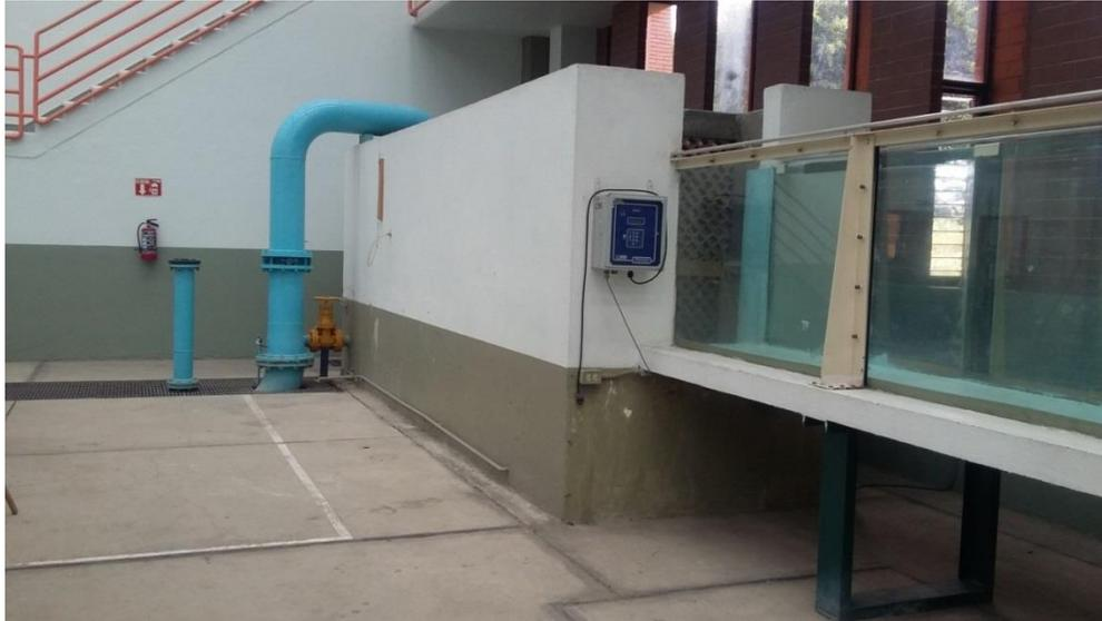
Foto 16. Detalle de tubería de alimentación de canal largo de pendiente nula.
