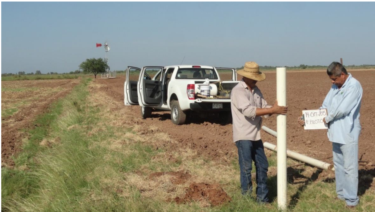
Ilustración 7. Instalación de pozos de observación para la monitorización del nivel freático.
