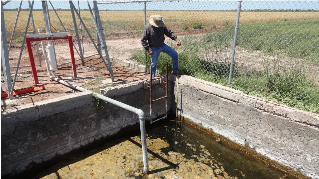
Ilustración 6. Monitoreo mensual del nivel freático en el cárcamo de bombeo.
