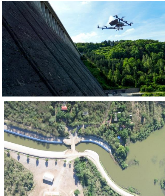
Figura 8.5 Supervisión de infraestructura hidroagrícola con el uso de VANT.
