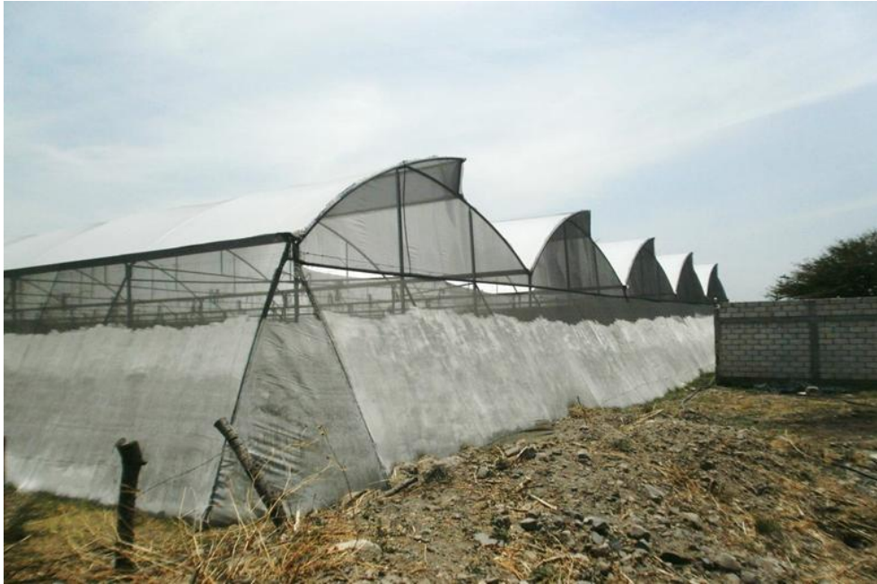
Figura 19 Vista del exterior de un invernadero con cal en la parte frontal y lateral de la malla antifidos como regulador de temperatura, en Amayuca, Mor.
