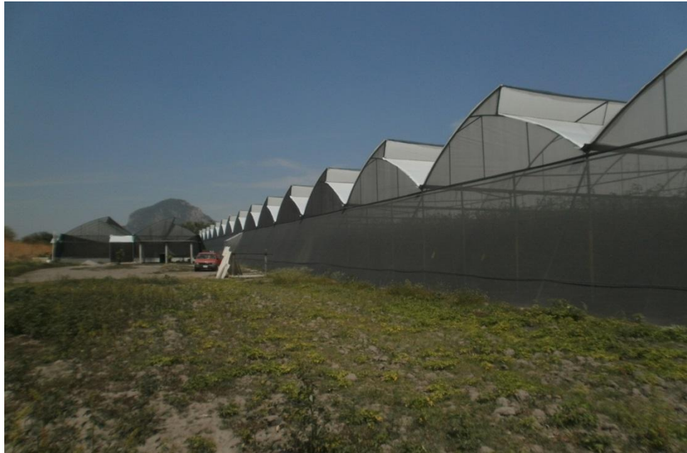
Figura 15. Estructura de una Multinave, Invernadero tipo cenital, en el municipio de Jantetelco, Morelos.
