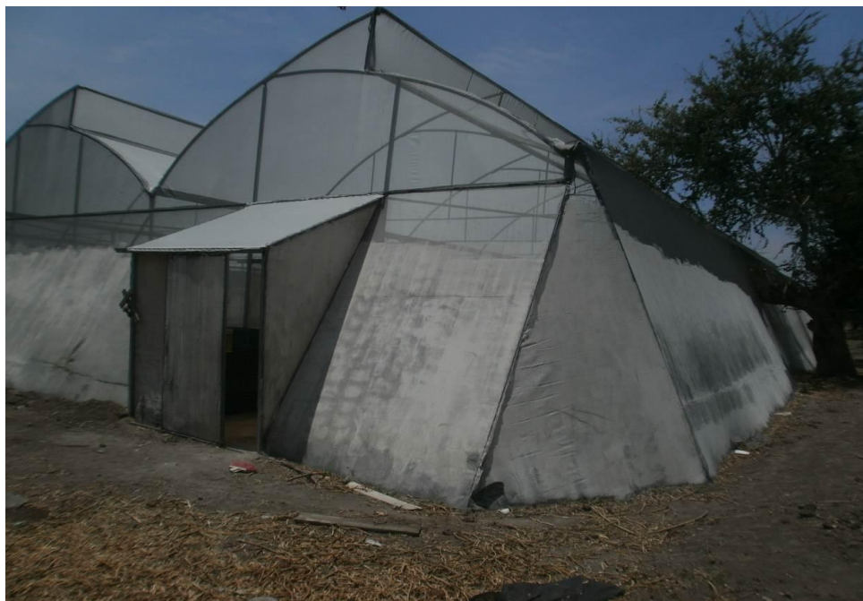
Figura 21. Vista exterior de un Invernadero con aplicación de cal sobre la malla antiáfido, en el municipio de Jantetelco, Mor.
