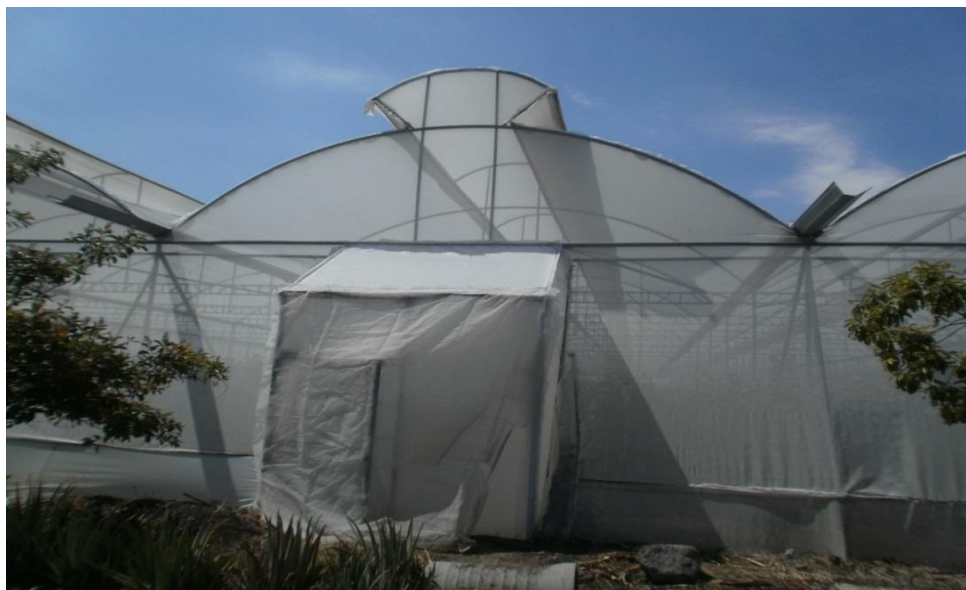
Figura 16. Invernadero tipo mariposa, domo o doble ventila, en la localidad de Ixtlilco el Grande municipio de Tepalcingo, Morelos.
