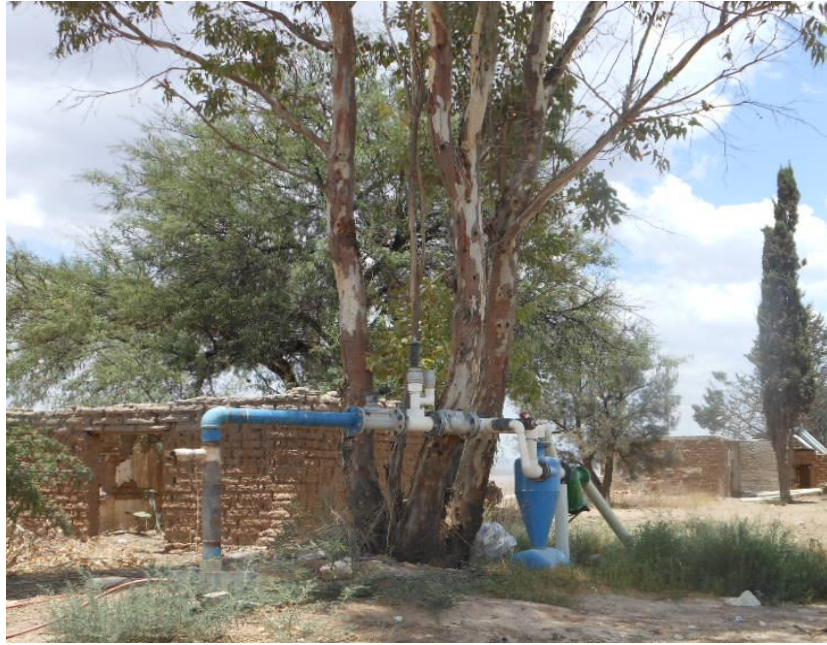
Figura 4.5. Vista del tren de descarga del Predio el Cedro
