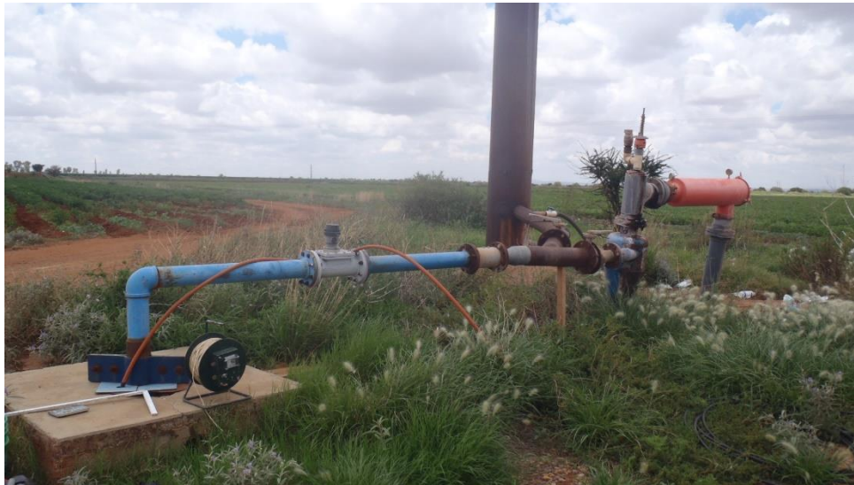
Figura 4.7. Vista del tren de descarga del Predio el Mirador
