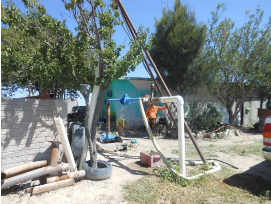
Figura 4.3. Tren de descarga del Predio Rancho Angélica
