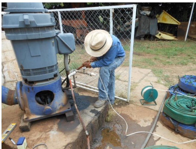
Figura 3.4 Medición de los niveles de bombeo con sonda eléctrica
