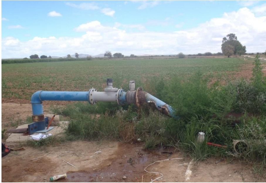
Figura 4.1. Tren de descarga U. de R. Toribio No. 38
