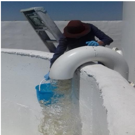
Figura 5.3-14. Retrolavado filtros (Alamito)
