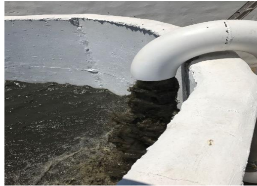
Figura 5.3-14. Retrolavado filtros (Alamito)
