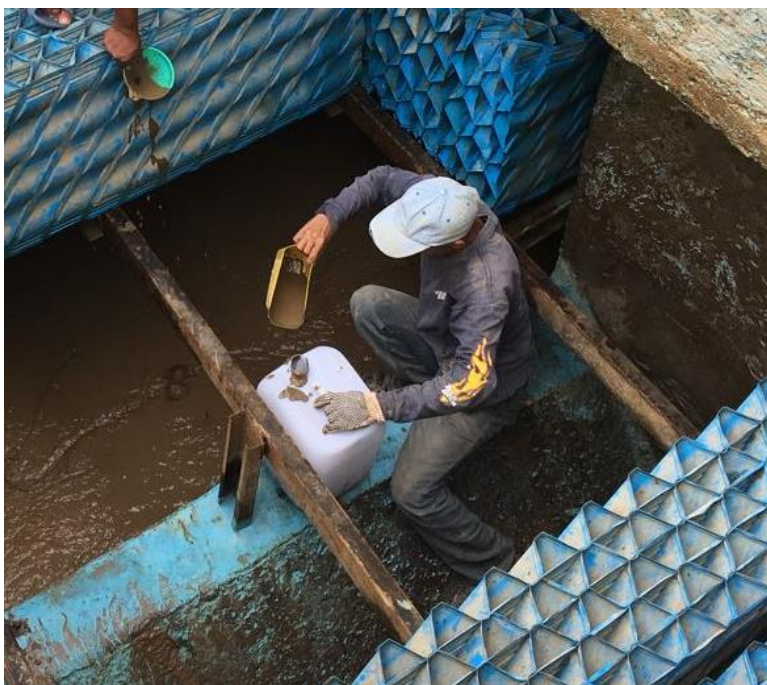
Figura 5.3-10. Toma de muestra de lodos (Villahermosa)
