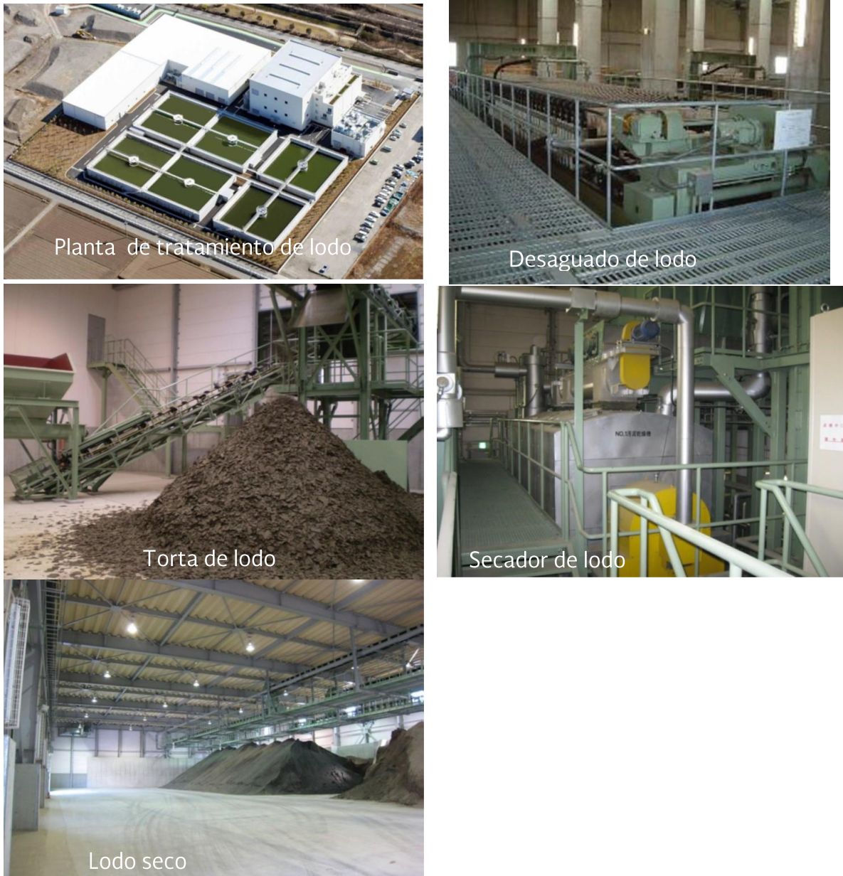
Figura 3.3-2. Tratamiento de lodo, planta Okubo, Japón. Fuente: Fujiwara, (2011)
