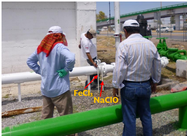
Figura 5.3-17. Adición de reactivos (Pozo 7)
