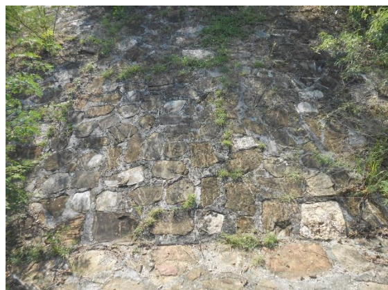
Fotografía II.46 Aspecto de la chapa de mampostería del lado derecho del vertedor.
