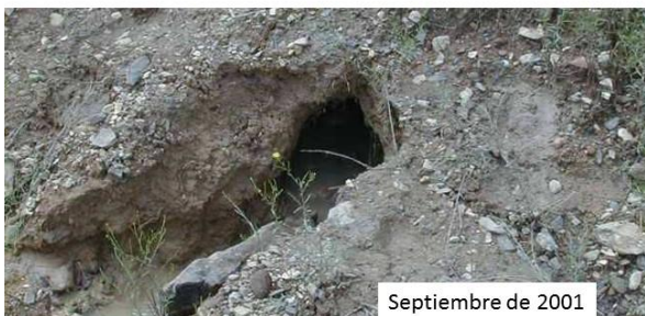
Fotografía VI.8. Filtración y orificio observados en octubre de 2001.
