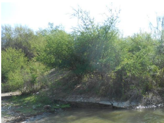
Fotografía II.45 Panorámica de la chapa de mampostería del lado derecho del vertedor.
