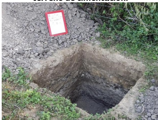
Fotografía III.26 Excavación del PCA-6 en el terreno de cimentación.
