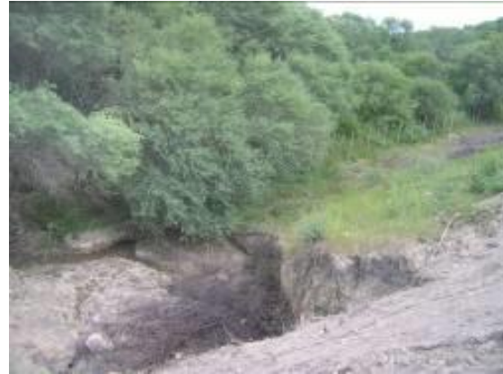
Fotografía II.33 Falla sobre el talud aguas abajo tomada desde la corona (foto del 2010).
