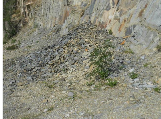
Fotografía VII.7 Material intemperizado de la ladera izquierda.
