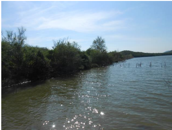
Fotografía II.18 Panorámica del talud aguas arriba desde margen izquierda.
