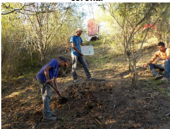
Fotografía III.20 Excavación del PCA-3 en el talud aguas abajo.
