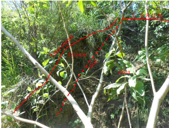
Fotografía II.36 Aspecto del contacto entre el talud original y la zona reparada.
