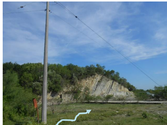
Fotografía VII.5 Poste de energía eléctrica en el canal de llamada del vertedor.
