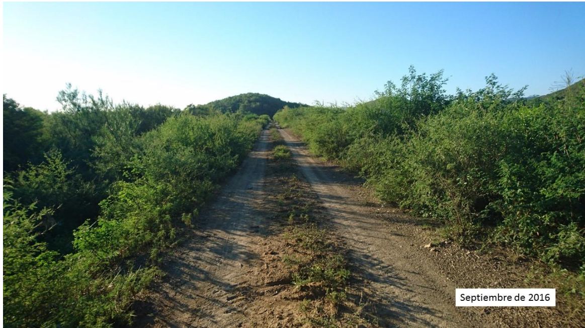
Fotografía VI.5 La cortina con su corona de 4.0 m de ancho y circulación de vehículos.
