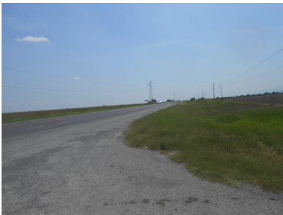
Fotografía VII.12 Desviación sobre la carretera federal No. 85.
