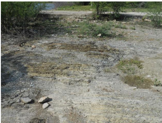
Fotografía VII.4 Detalle del terreno de cimentación en la zona de la descarga.
