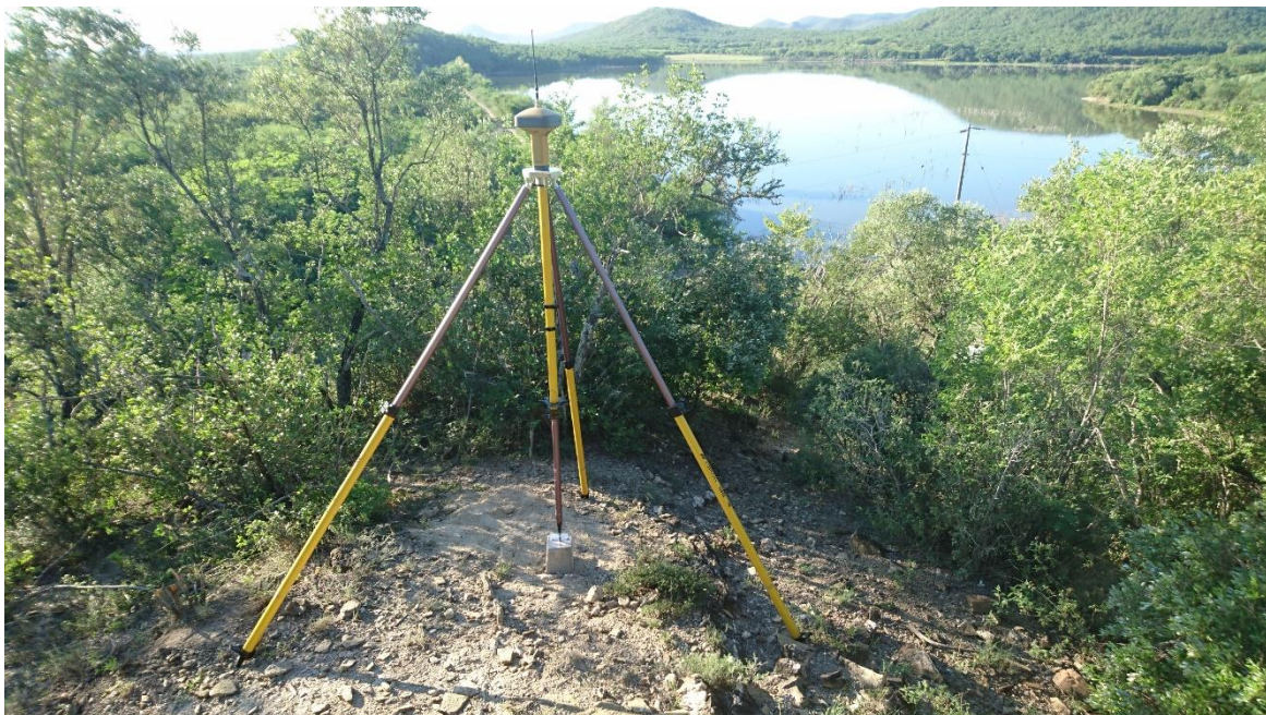
Fotografía III.1 Equipo utilizado para el levantamiento topográfico de la presa.
