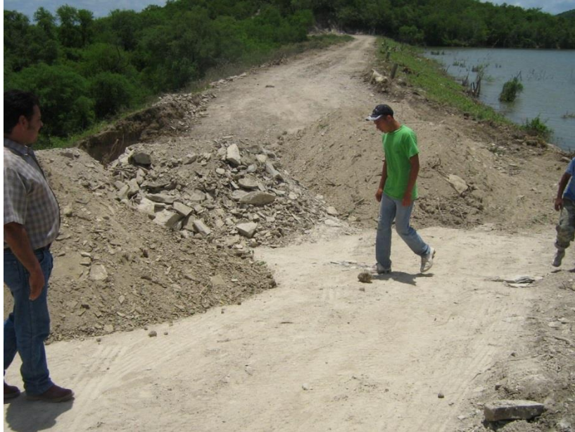
Fotografía VI.12 Materiales empleados para rellenar la cárcava, en estado suelo.
