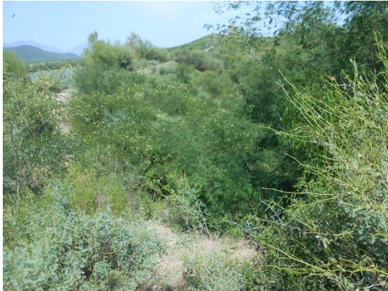
Fotografía II.22 Panorámica del talud aguas abajo, desde el extremo derecho de la cortina.
