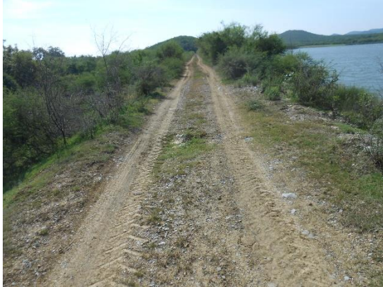
Fotografía II.6 Panorámica de la corona desde margen izquierda.
