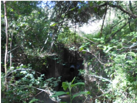
Fotografía II.53 Estructura de salida de la obra de toma, vista frontal.
