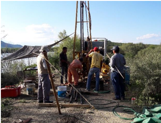
Fotografía III.28 Perforación del SPT-01 en la zona de la falla.
