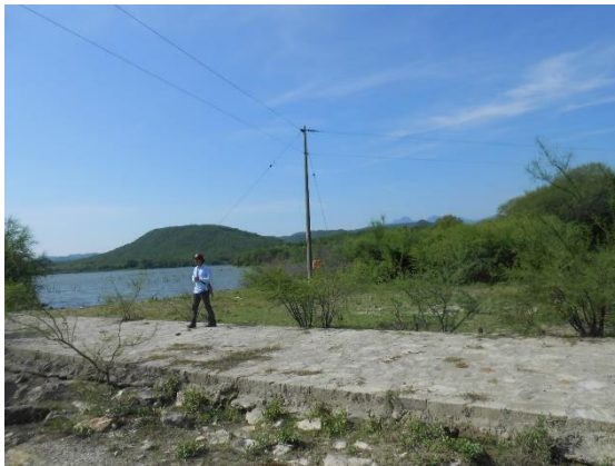
Fotografía II.51 Poste de energía eléctrica dentro del embalse.
