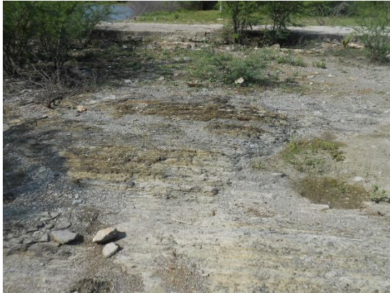
Fotografía II.43 Aspecto de las lutitas y calizas intercaladas sobre las que se contruyó el vertedor.
