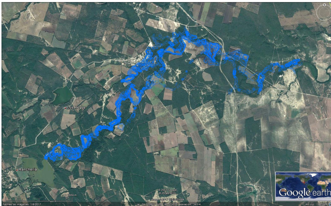
Figura VIII.4 Delimitación de la zona federal, cauce aguas abajo de la presa Rancherías.
