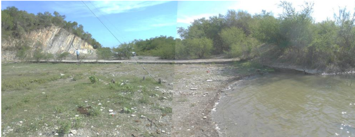
Fotografía II.40 Panorámica del vertedor tipo lavadero en el extremo izquierdo de la cortina.
