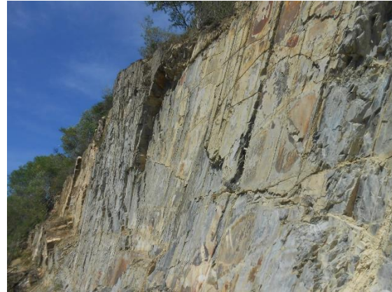
Fotografía II.44 Corte sobre la ladera para alojar el vertedor, donde se aprecia más claramente la litología existente.
