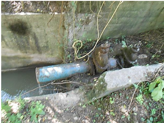
Fotografía II.55 Aspecto de las varillas del muro frontal demolido.
