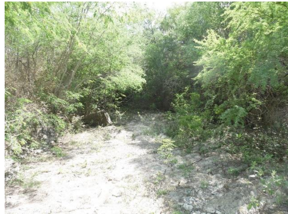
Fotografía III.9 Aspecto del cauce aguas abajo de la obra de excedencias (0+130).
