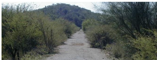
Fotografía VI.5 La cortina con su corona de 4.0 m de ancho y circulación de vehículos.
