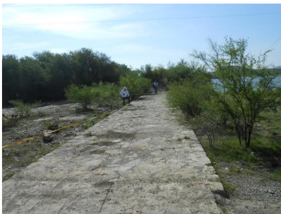
Fotografía II.41 Espigón de mampostería en la sección de control del vertedor.
