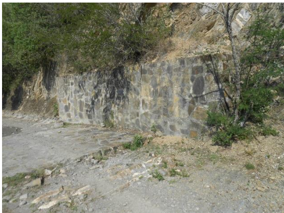
Fotografía II.49 Panorámica del muro izquierdo del vertedor.
