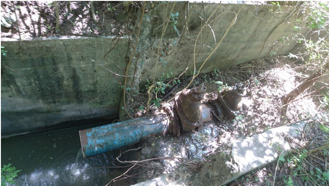
Fotografía VIII.3 Obra de toma en octubre de 2016.
