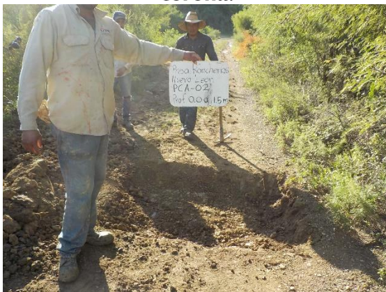
Fotografía III.18 Excavación del PCA-2 en la corona.
