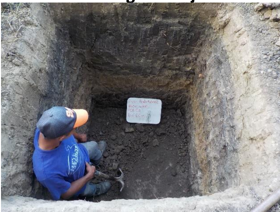
Fotografía III.24 Excavación del PCA-5 en el terreno de cimentación.
