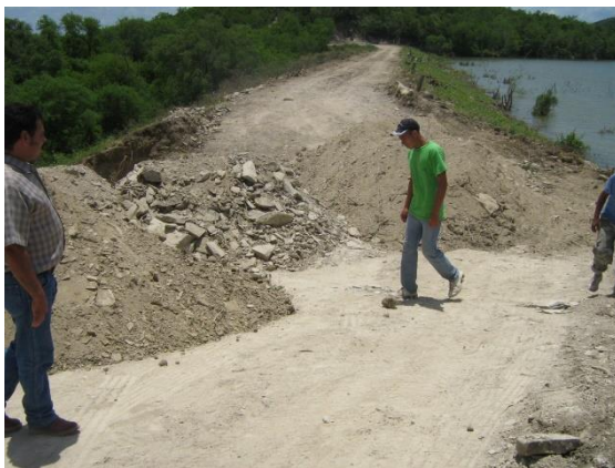
Fotografía II.34 Materiales para la reparación de la falla sobre el talud aguas abajo (foto del 2010).
