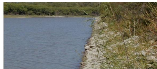
Fotografía VI.5 La cortina con su corona de 4.0 m de ancho y circulación de vehículos.
