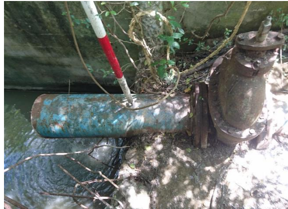
Fotografía III.5 Levantamiento topográfico de la obra de toma.
