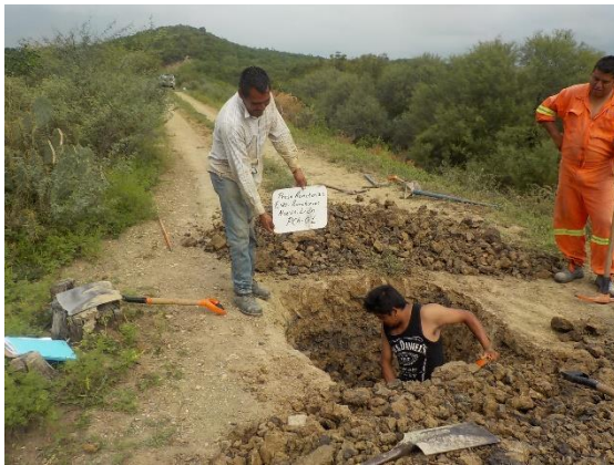
Fotografía III.16 Excavación del PCA-1 en la corona.
