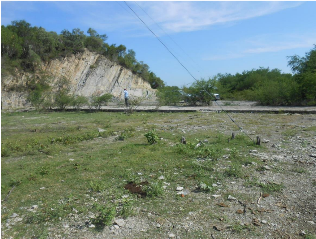
Fotografía VII.1 Panorámica del vertedor tipo lavadero.
