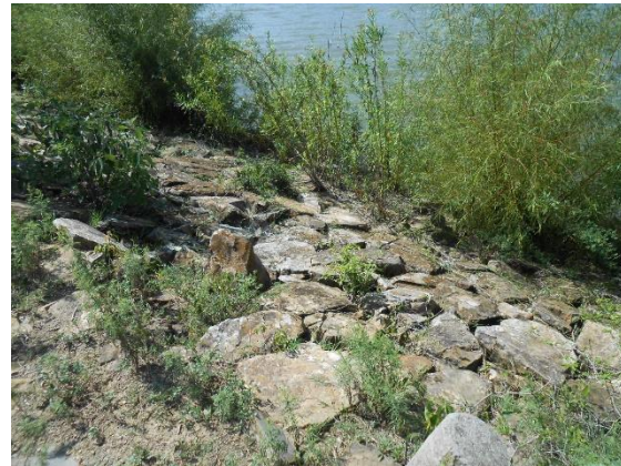
Fotografía II.19 Aspecto del enrocamiento de protección.
