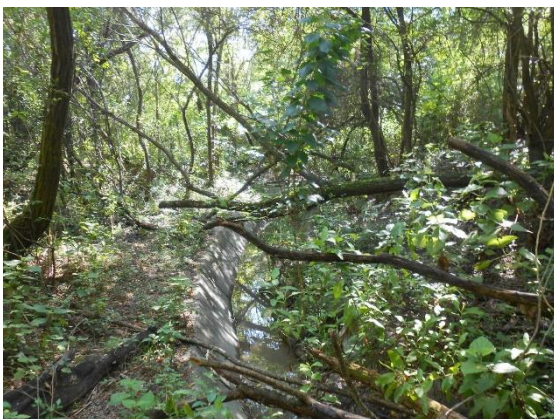
Fotografía VII.10 Aspecto del canal de distribución, al fondo la obra de toma.
