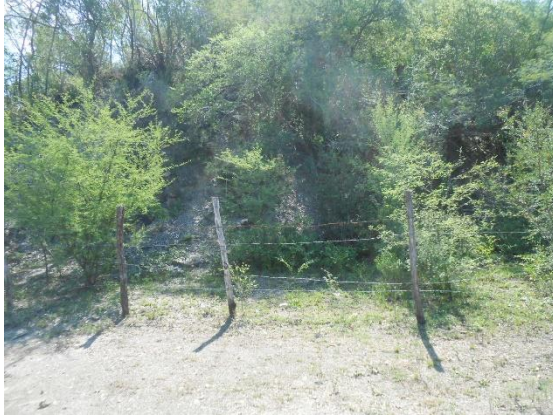
Fotografía II.30 Empotramiento derecho de la cortina con la ladera.
