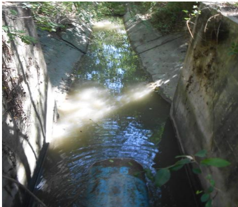
Fotografía II.61 Canal de distribución de la obra de toma.
