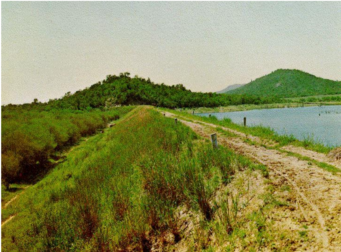
Fotografía VI.1 La cortina de la presa Rancherías en 1970.
