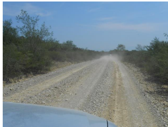
Fotografía VII.13 Carretera de acceso a la presa Rancherías, tomada desde la presa.
