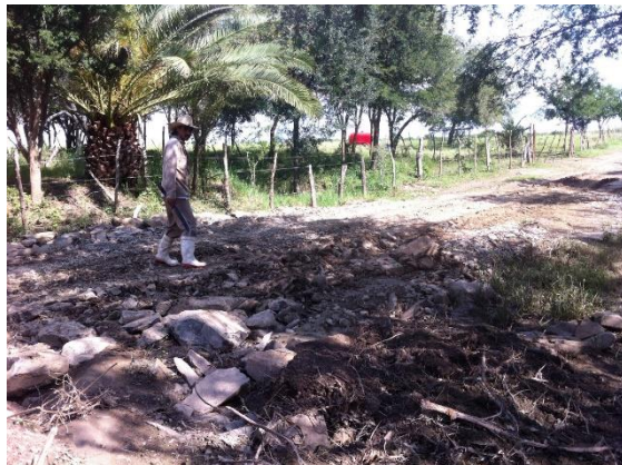
Fotografía III.14 Cruce de tierra y enrocamientos sobre el cauce en el cadenamiento 4+618.
