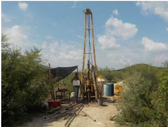
Fotografía III.30 Perforación del SPT-2 en el lado izquierdo de la cortina.
