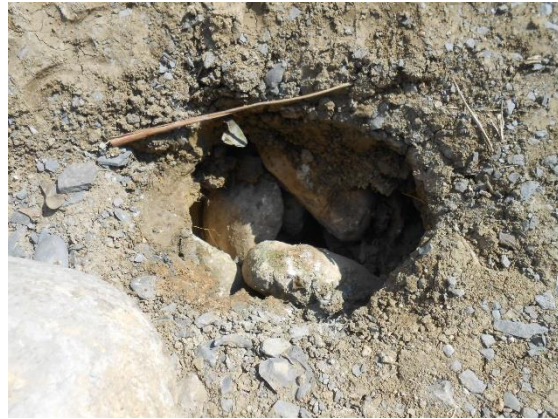
Fotografía II.11 Relleno de las oquedades sobre la corona con boleos.
