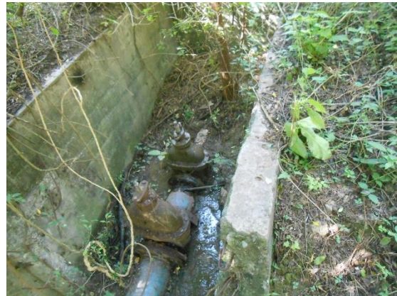
Fotografía II.54 Estructura de salida de la obra de toma, vista superior.
