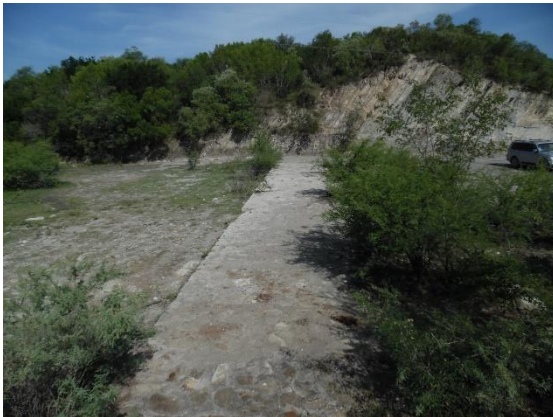
Fotografía III.8 Cadenamiento inicial (0+000) sobre la obra de excedencias.
