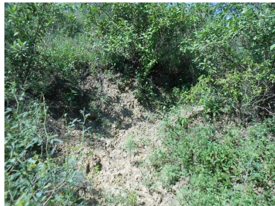
Fotografía II.39 Restos del material al pie del talud en la zona reparada.
