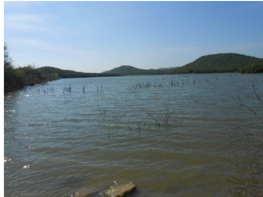
Fotografía II.3 Embalse desde margen izquierda.
