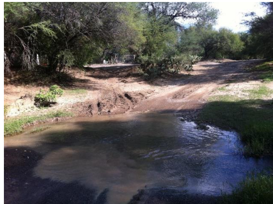
Fotografía III.15 Vado rústico sobre el cauce en el cadenamiento 6+089.
