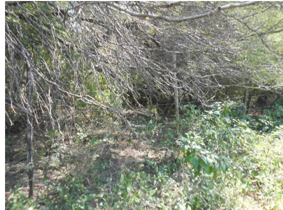
Fotografía II.25 Cerca de postes de madera y alambre de púas al pie del talud aguas abajo.
