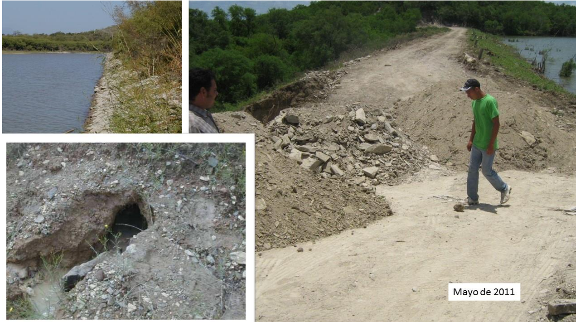
Fotografía VI.9 Los usuarios colocaron tierra y rocas en ambas taludes en el sitio donde hubo deslizamiento y cárcava en 2010 y donde había una filtración en 2001, pero no se concluyó el relleno del lado de aguas abajo.
