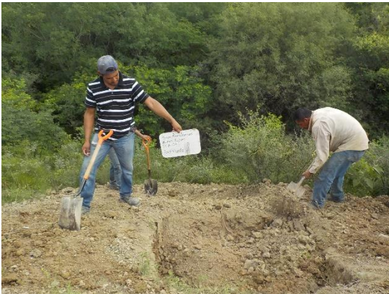
Fotografía III.22 Excavación del PCA-4 en el talud aguas abajo.
