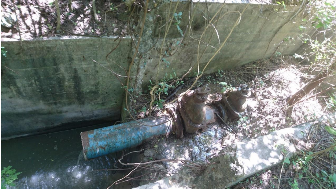
Fotografía 1.3 Obra de toma en octubre de 2016.
