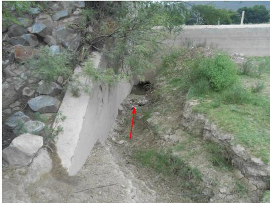
**Fotografía II.63** Entrada hacia la válvula de desfogue en el vertedor.
