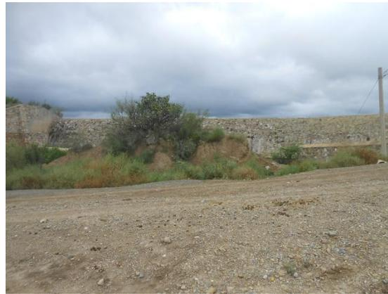
**Fotografía VI.3 Obstrucciones en el canal de descarga del vertedor.**
