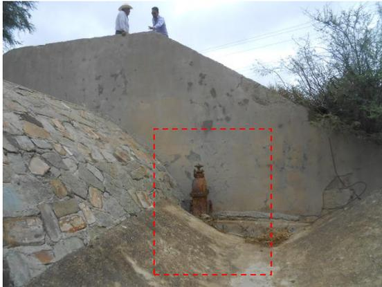
**Fotografía II.61 Válvula de desfogue al pie del cimacio del vertedor.**
