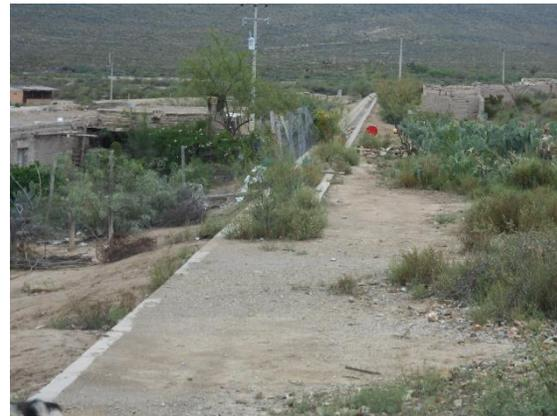
**Fotografía VI.15 Ramal derecho del canal de distribución azolvado y fuera de operación.**
