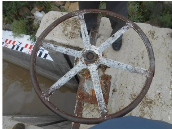
**Fotografía II.76 Estado del mecanismo para el izaje de la compuerta.**
