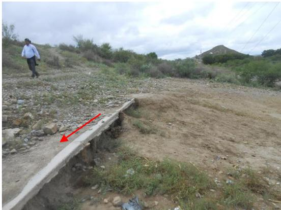
**Fotografía II.81 Canal hacia las parcelas en el lado derecho de la presa, totalmente azolvado.**
