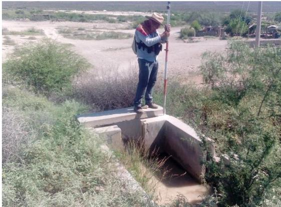
**Fotografía III.6 Levantamiento del canal de la obra de toma de la presa.**
