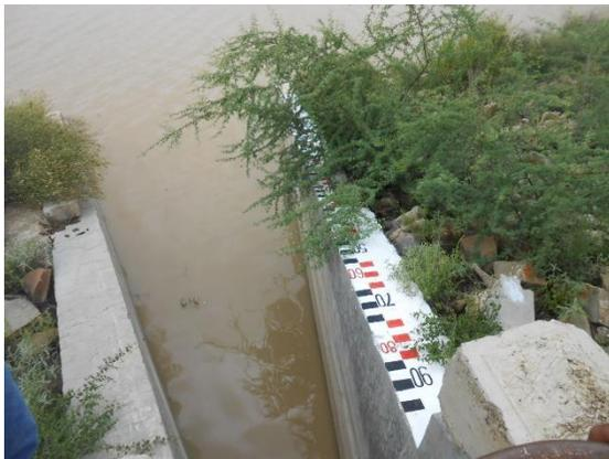
**Fotografía II.71 Estructura de entrada de la obra de toma.**
