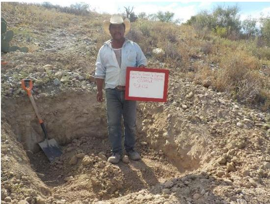
**Fotografía III.16** Excavación del PCA-2 sobre el talud aguas abajo de la presa.
