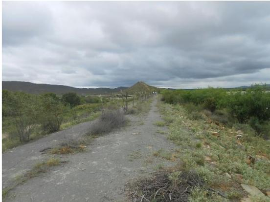
**Fotografía II.16 Arbustos sobre la corona del lado derecho del vertedor.**
