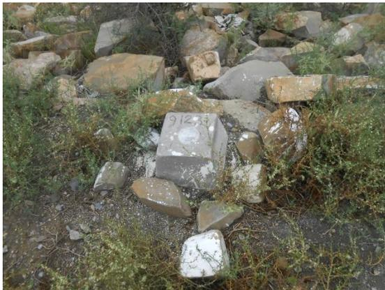
**Fotografía II.18 Testigo topográfico sobre el hombro aguas arriba.**
