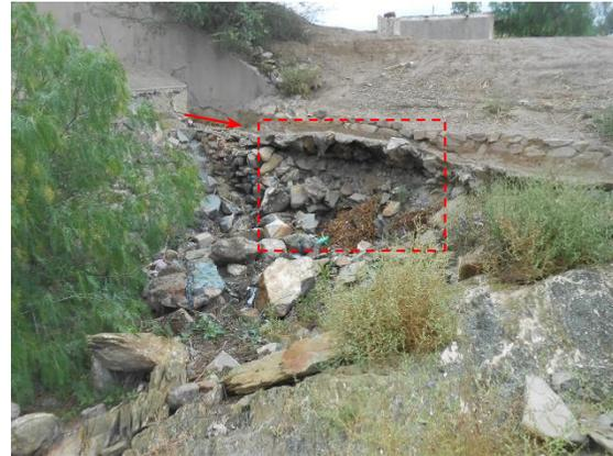
**Fotografía II.64** Erosión bajo el canal de la válvula de desfogue en el vertedor.
