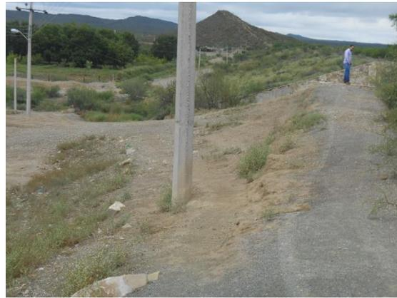
**Fotografía II.29 Cortes y erosiones sobre el talud aguas abajo en el tramo de cortina a la izquierda del vertedor.**
