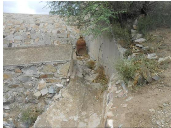
**Fotografía VI.5 Válvula para desfogue bajo, pegado al muro izquierdo del vertedor .**
