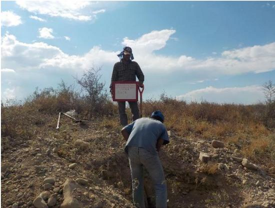
**Fotografía III.14** Excavación del PCA-1 sobre el talud aguas abajo de la presa.
