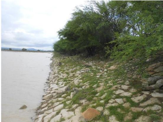
**Fotografía II.24 Aspecto del enrocamiento de protección en la zona del empotramiento derecho.**
