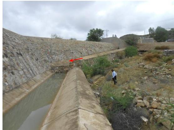
**Fotografía II.60 Deflector al pie del cimacio del segmento de la derecha del vertedor.**
