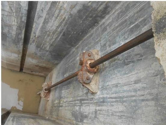
**Fotografía VI.10 Mecanismo de izaje de la compuerta.**
