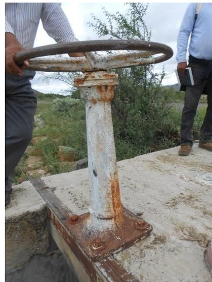
**Fotografía VI.7 Mecanismo de operación de la compuerta.**
