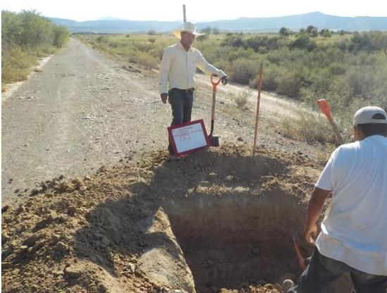
**Fotografía III.24** Excavación del PCA-6 en la corona del dique
