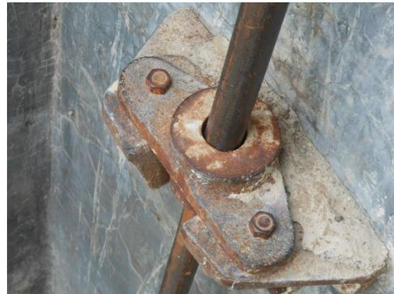
**Fotografía VI.11 Vástago y guía con oxidación y falta de lubricación.**
