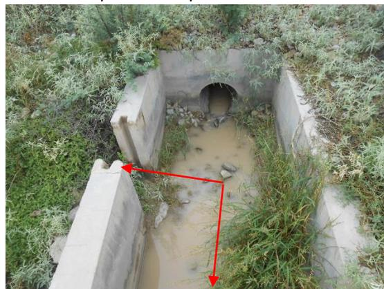
**Fotografía II.78 Detalle de la estructura de salida de la obra de toma.**
