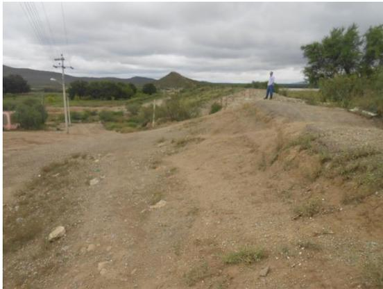
**Fotografía II.14** Desgastes y erosiones de la cortina al extremo izquierdo del vertedor.
