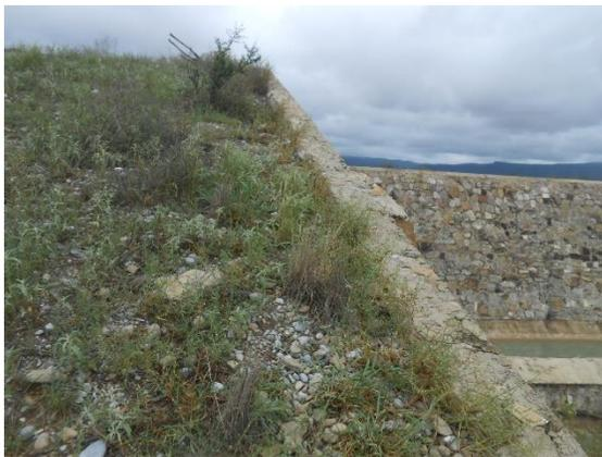
**Fotografía II.69 Contacto entre la cortina y el muro derecho del vertedor.**
