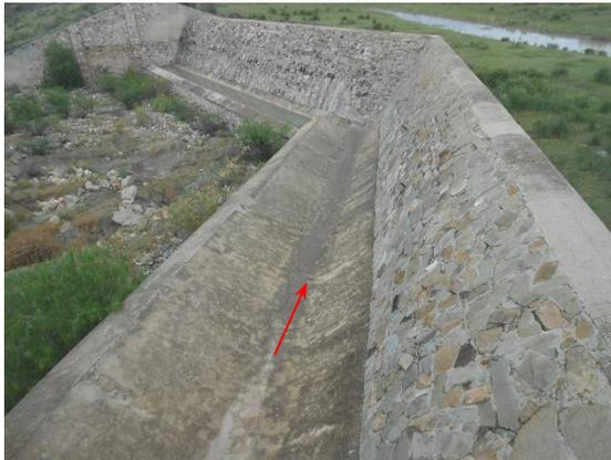
**Fotografía II.59 Deflector al pie del cimacio del segmento de la izquierda del vertedor.**
