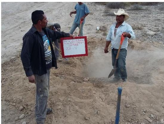
**Fotografía III.18** Excavación del PCA-3 el terreno de cimentación, al pie de la presa.
