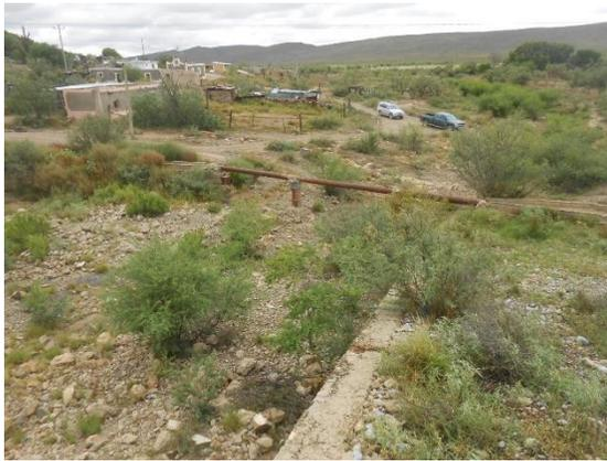
**Fotografía VI.4 Ducto de acero y camino de terracería atravezando el cauce.**
