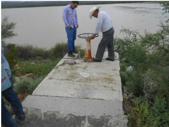
**Fotografía II.75 Mecanismo para el izaje de la compuerta, sobre la corona.**
