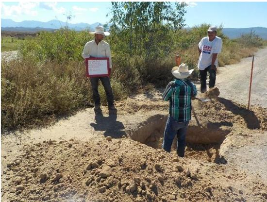
**Fotografía III.22** Excavación del PCA-5 en la corona del dique.
