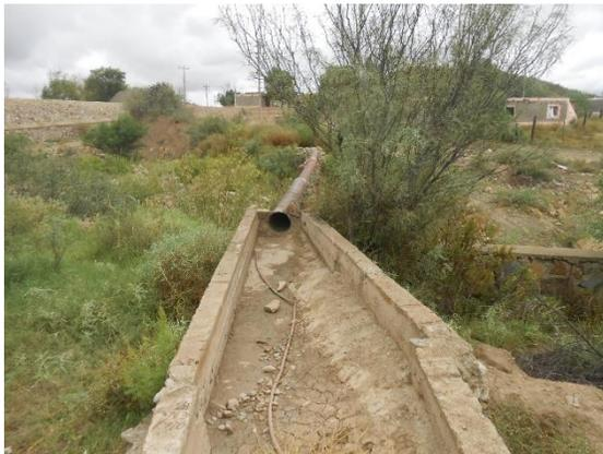
**Fotografía VI.14 Ramal izquierdo del canal de distribución que cruza la zona de descarga del vertedor.**
