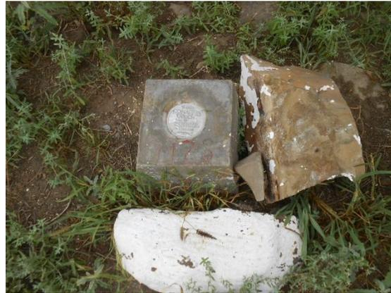
**Fotografía II.47 Testigos topográficos sobre la corona del dique.**
