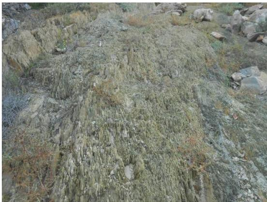
**Fotografía VI.2 Erosiones de la arenisca en la zona de descarga del vertedor.**
