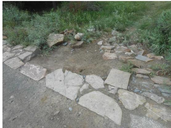
**Fotografía II.49 Restos de la chapa de enrocamiento sobre el talud aguas arriba.**
