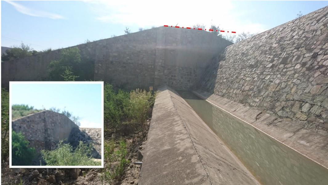
**Figura VI.2 Ubicación del eje del vertedor respecto al eje de la cortina en la presa San Antonio de La Pegajosa.**
