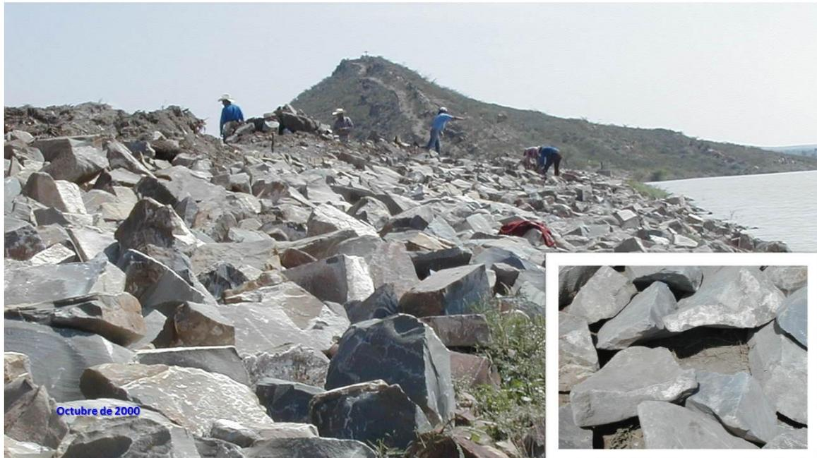
**Fotografía VII.4 Rehabilitación del enrocamiento en talud mojado.**
