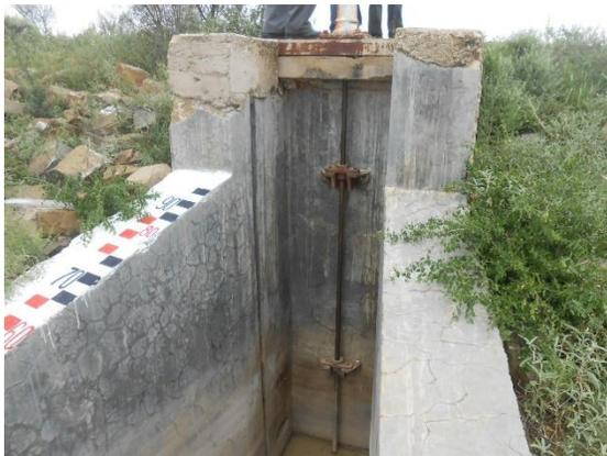
**Fotografía II.73 Mecanismo para el izaje de la compuerta.**
