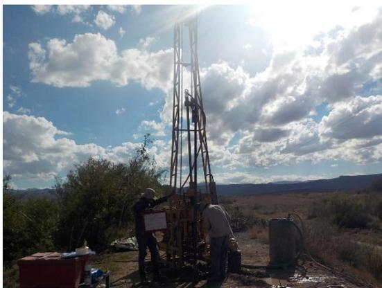
**Fotografía III.30 Perforación del SPT-3 en el dique.**
