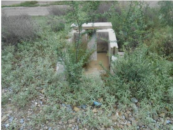
**Fotografía VI.12 Estructura de salida de la obra de toma.**
