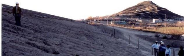
**Fotografía VII.12 Cárcavas de erosión en la cortina en el año 1998, lo que coincide con los resultados que dan que los limos arcillosos que forman la cortina son susceptibles de erosión interna por ser dispesivos.**
