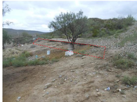
**Fotografía II.82 Socavación bajo el canal hacia las parcelas en el lado derecho de la presa.**
