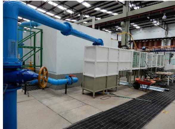
**Fotografía. 6. Válvula de control de y conducto de alimentación del flujo**
