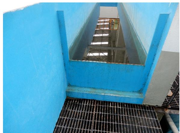
**Fotografía. 8. Canal y vertedor de aforo tipo contracción lateral de 80cm de longitud vertedor.**
