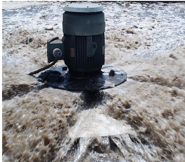
Fig. 5.17 Aerador mecánico de eje vertical y baja velocidad.
