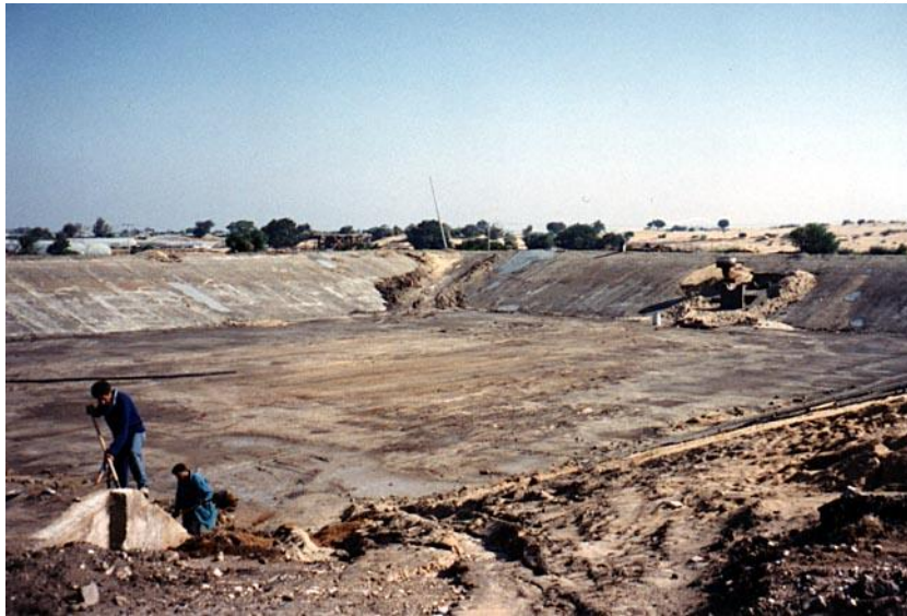
Fig. 4.1 Construcción de una laguna de estabilización.
