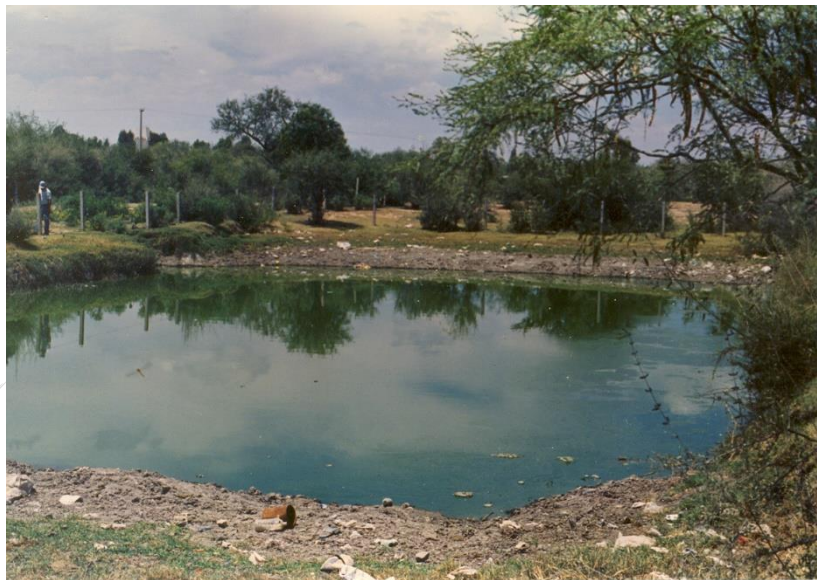
Fig. 4.2 Laguna de Estabilización.
