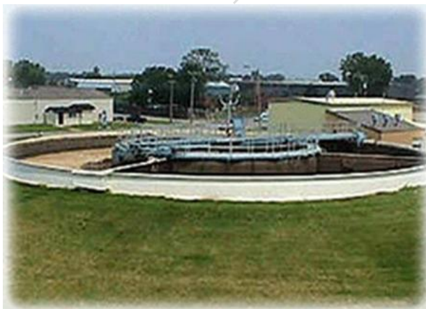
Fig. 5.73 Digester aerobio convencional.
