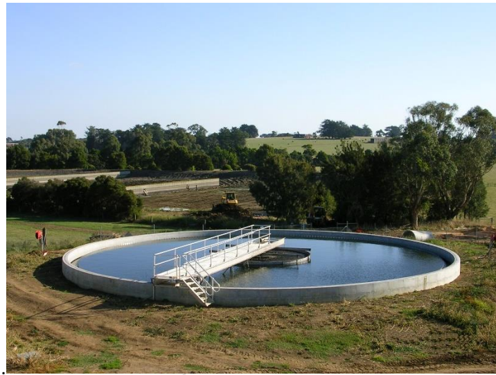
Fig.3.5 Sedimentadores circulares
