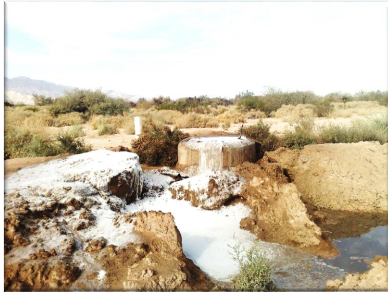
Figura 8. Pozo 21 de la descarga del efluente.
