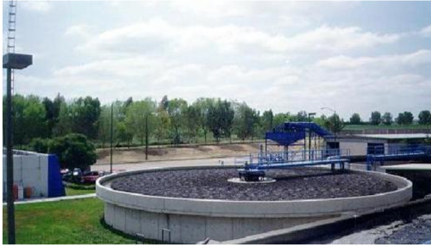
Fig. 5.60 Espesador por gravedad.
