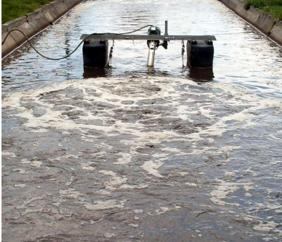
Fig. 5.27 Mecanismo aspirante de propela (tipo cañón).
