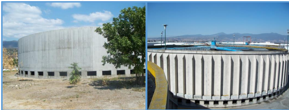
Figura 10. Ventilación en filtros percoladores de Chiapas y Sinaloa.
