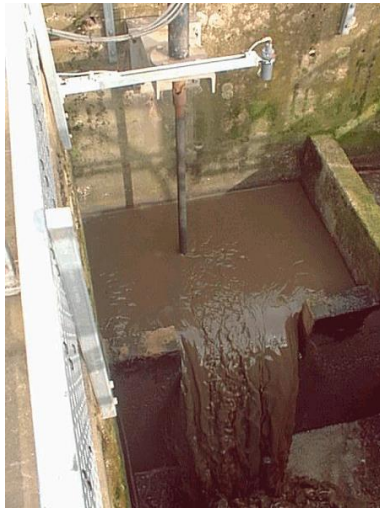
Fig. 2.9 y 2.10 Medidores de flujo ultrasónicos aplicables a tuberías y canales abiertos.
