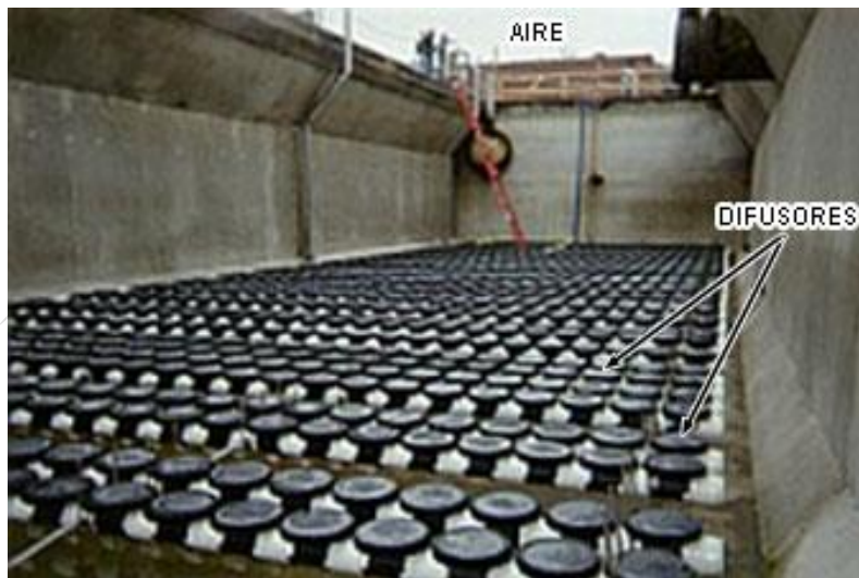
Fig. 5.31 Arreglo típico de difusores.
