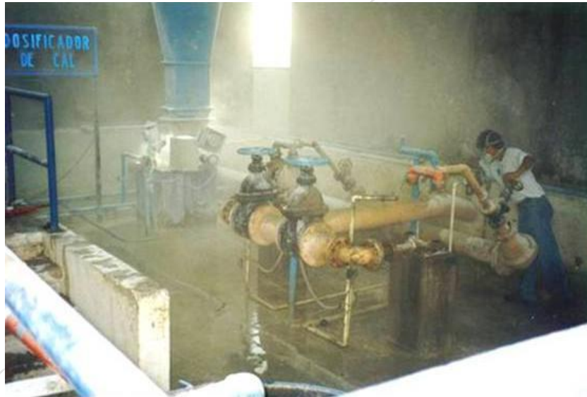
Fig. 5.76 Dosificación de cal para espesar el lodo.
