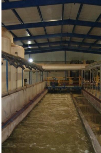
Fig. 2.12 Desarenador aerado.
