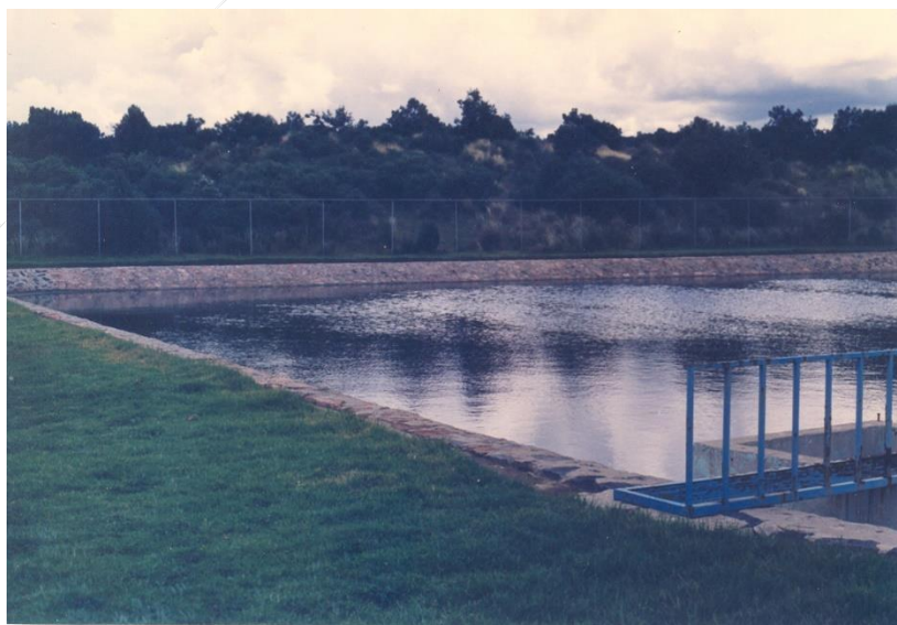
Fig. 4.4 Laguna de maduración.
