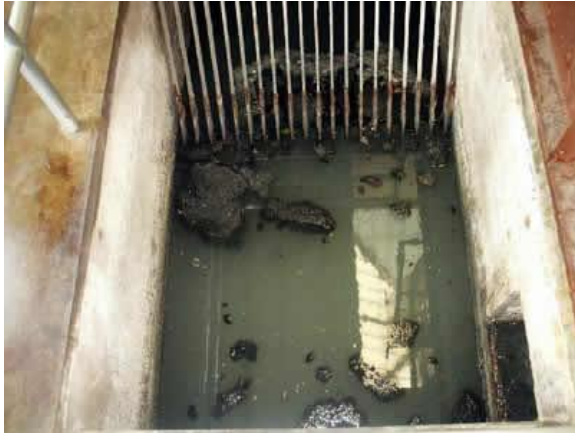
Fig. 2.2 Rejillas para limpieza manual.
