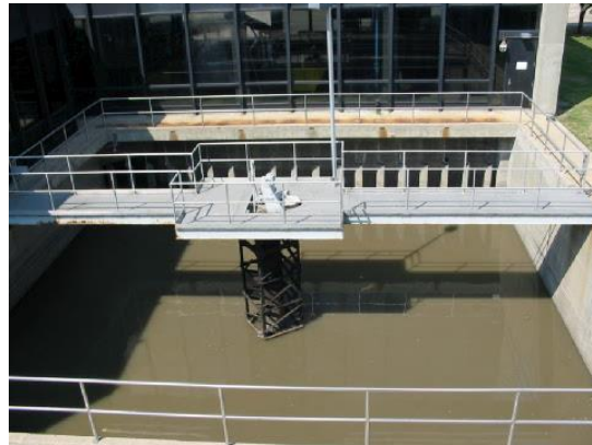
Fig. 2.13 Tanque desarenador cuadrado.
