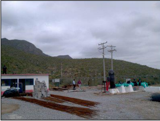
Ilustración 6-7 Pozo dinamita en operación
