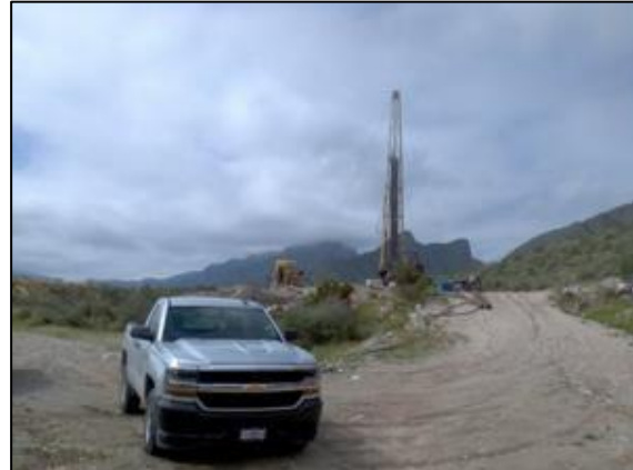
Ilustración 6-8 Perforación del pozo #2 se han perforado 240 metros
