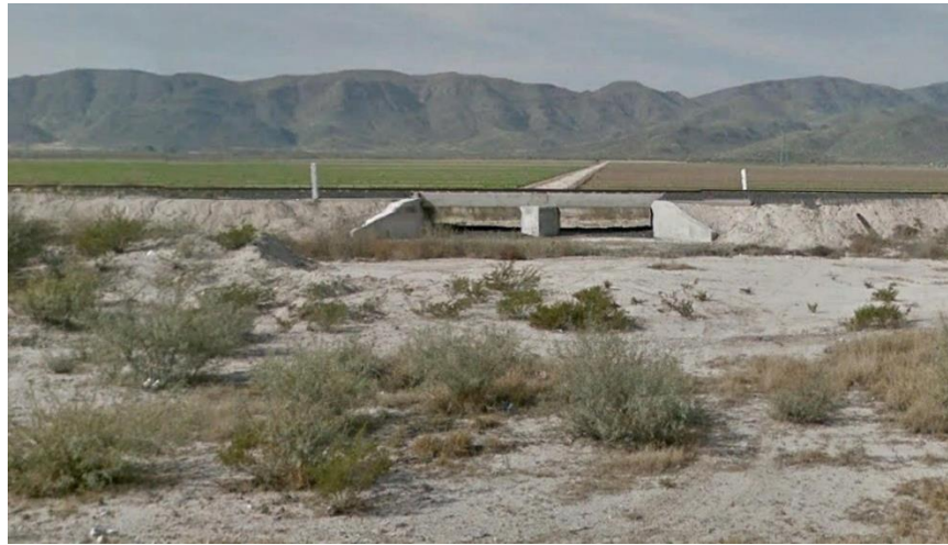
Ilustración 3-127 Estructuras 1, paso de vado de ferrocarril.
