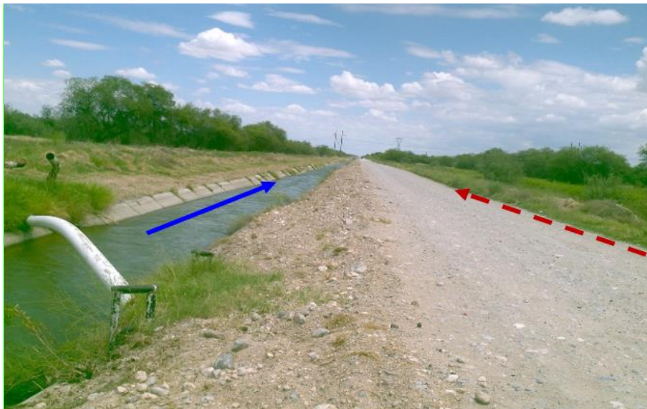
Ilustración 3-61 Trazo de la línea de conducción por la lateral derecha del canal con respecto al flujo Fuente: Elaboración propia
