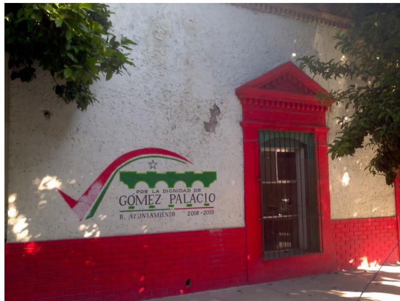
Ilustración 3-67 Ubicación de las instalaciones del SIDEAPAAR (Rural) de Gómez Palacio, Dgo.
