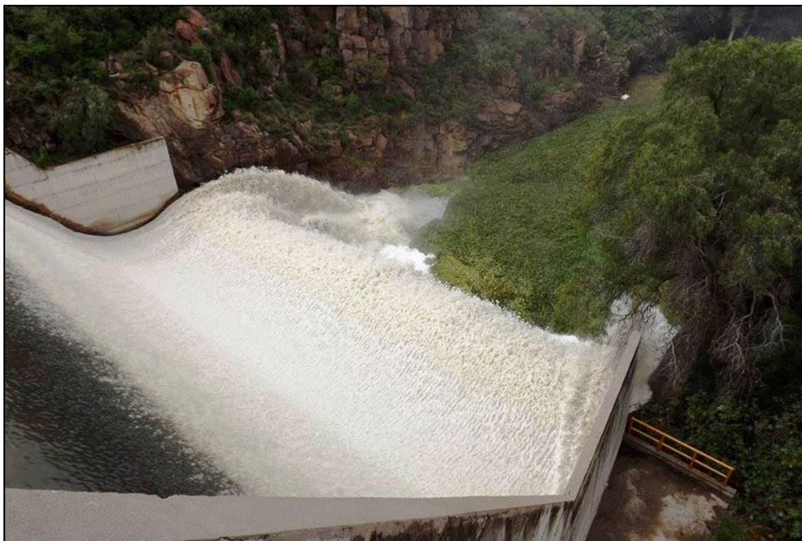
Figura 2.12. Presa El Niágara
