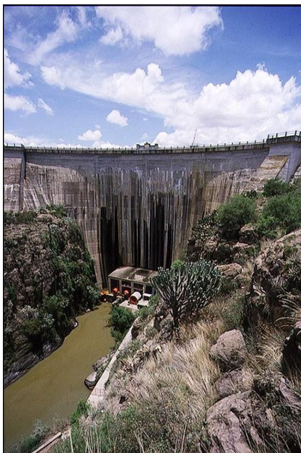
Figura 2.9. Presa Plutarco Elías Calles
