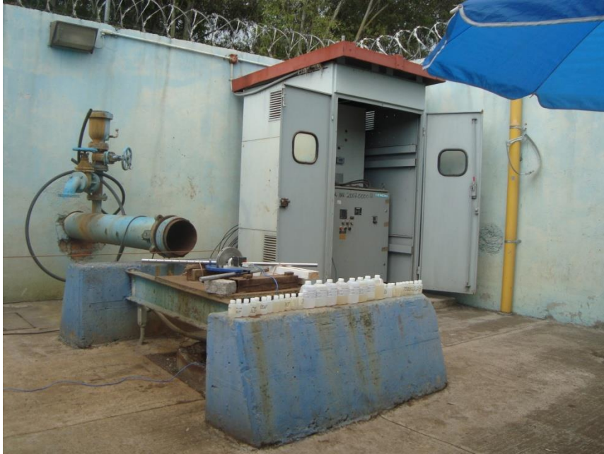
Figura 1.2.2 Toma de muestras de agua en el pozo Mixquic 1
