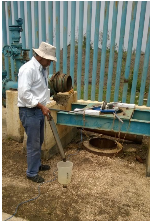
Figura 1.2.3 Toma de muestras de agua en el pozo Mixquic 5
