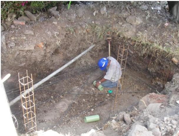
Foto 4.4. Excavación de zanja para tanque
