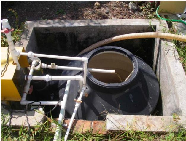
Foto 4.11. Tanque de captación del agua drenada
