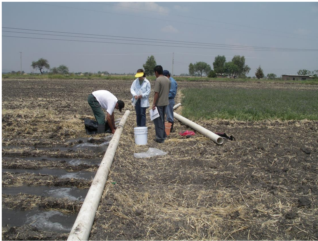
Foto 4.2.2. Aforo volumétrico de la tubería con compuertas.
