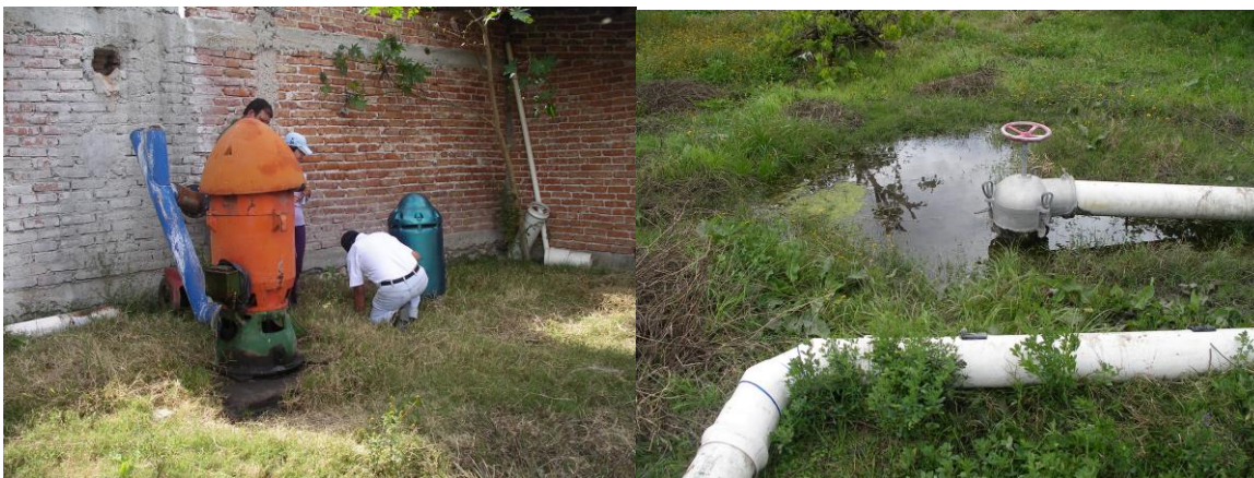
Fotos 4.4.10 y 4.4.11 Ubicación del pozo, y fugas de agua en la red de distribución e hidrantes, respectivamente.
