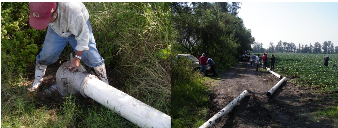
Fotos. 4.4.15 y 4.4.16 Preparando la tubería con compuertas para la aplicación del riego. Vemos al lado izquierdo al regador conectando la tubería con el codo de arranque.
