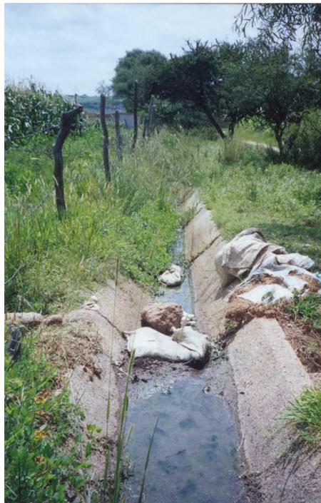
Foto 1.3 Represa de costales con tierra en canal lateral.
