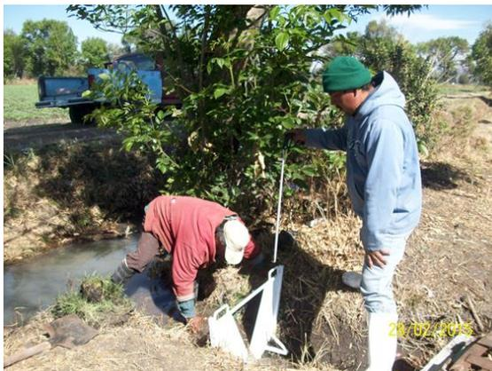
Ilustración 1.7.28. Instalación de vertedor triangular para medición del agua.
