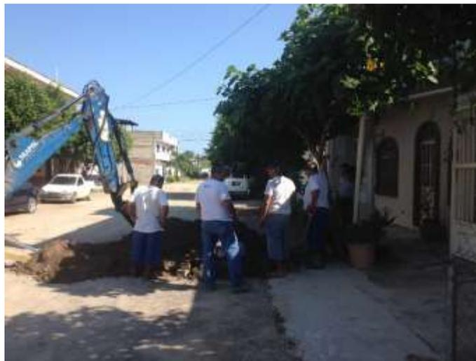
**Figura 15. Localización de la tubería en donde se conectará la toma domiciliaria**
