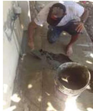
**Figura 23. Relleno y compactación de zanjas en donde se realizaron los trabajos**
