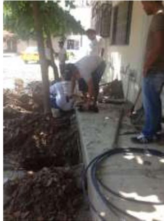
**Figura 19. Elaboración de la zanja donde se instalará la toma domiciliaria**
