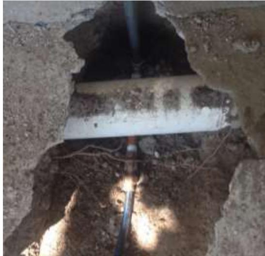
**Figura 21. Colocación de la válvula de banquetta**
