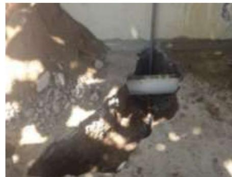
**Figura 20. Instalación de la manguera desde la tubería principal hasta la válvula de banquetta**
