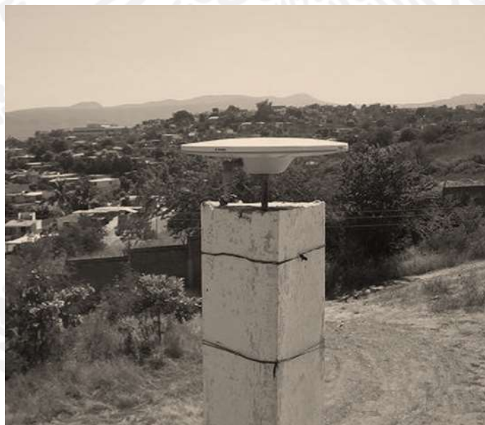
Figura 36. Mojonera con adaptador para antena o estación total.
