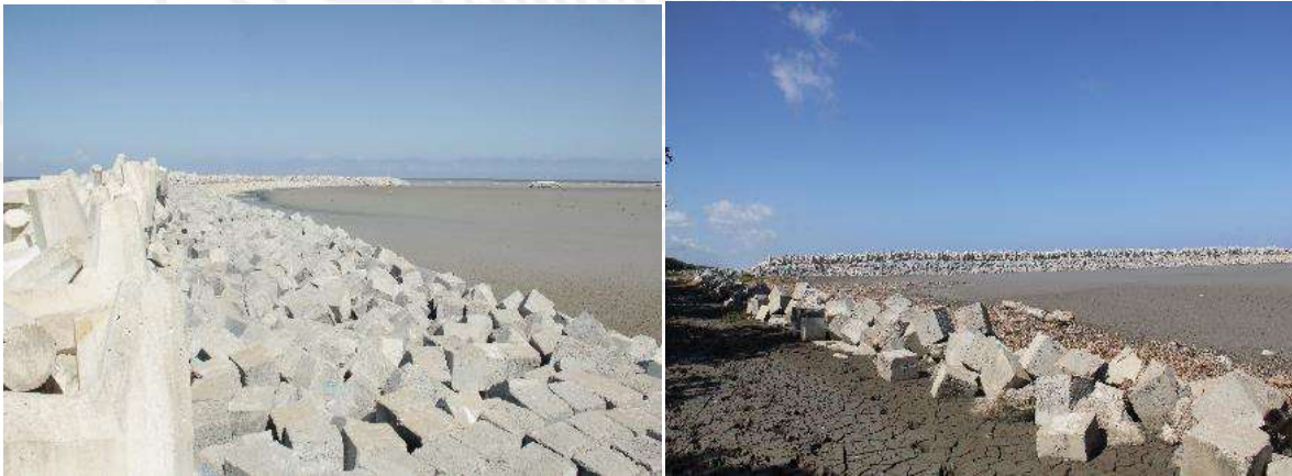
Figura 20. Playa CPTG (Atasta), Obras de protección formadas por escolleras de bloques de concreto y matatenas. Fotografía de 2017.
