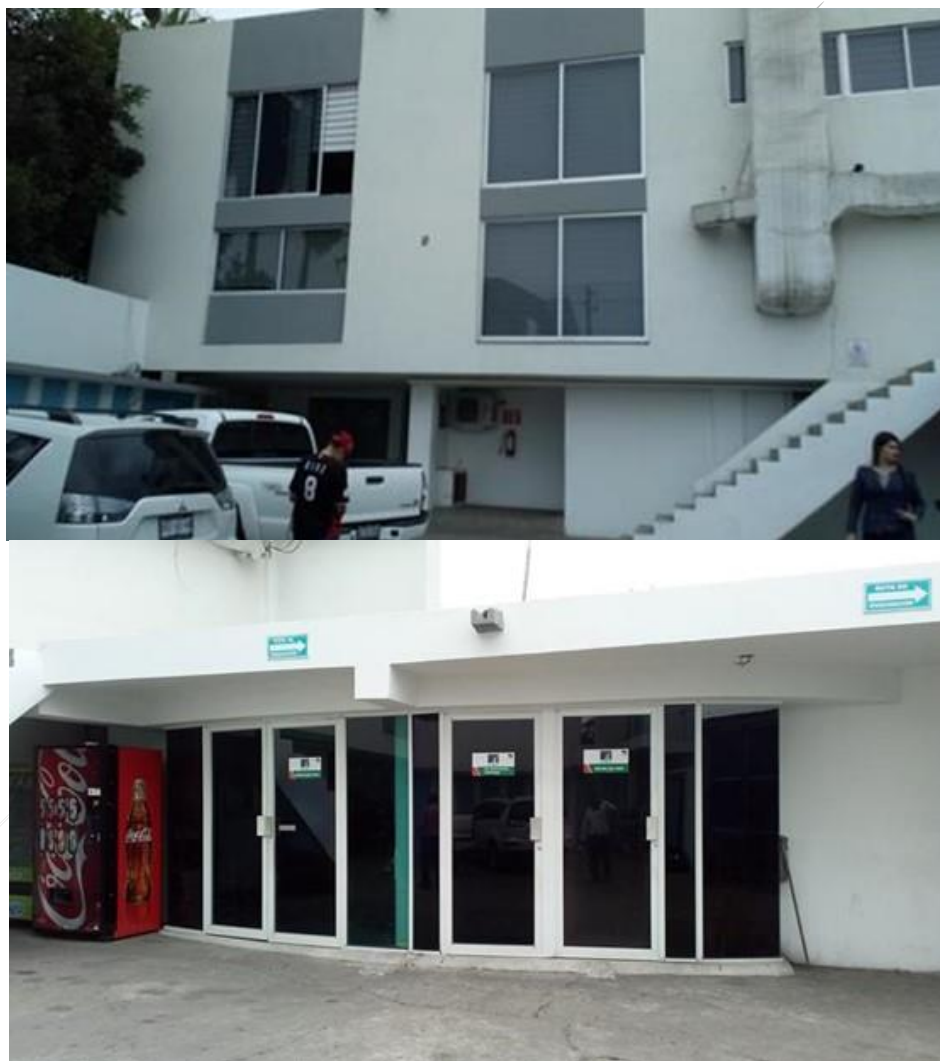
Figura 20. Vista exterior de las oficinas en el primer nivel
