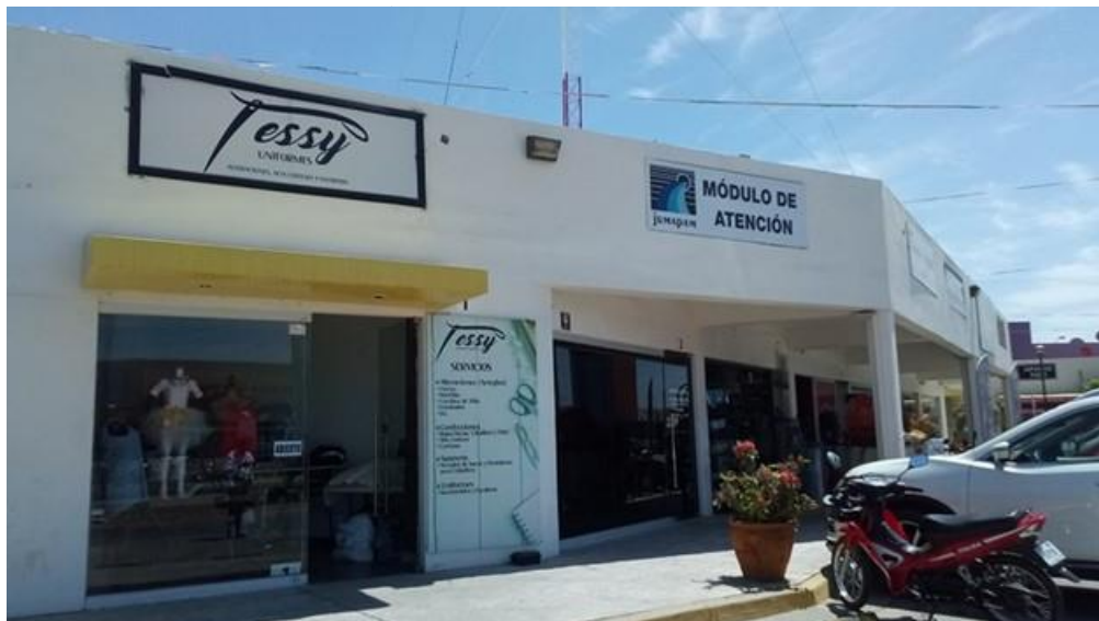
Figura 30. Vista exterior del módulo Real Pacífico
