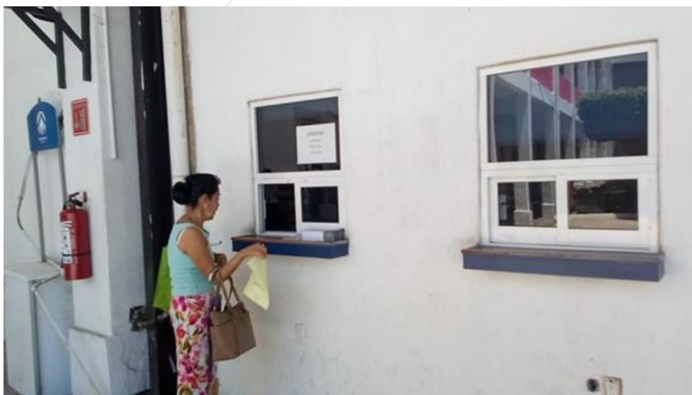
Figura 38. Vista exterior del módulo Ayuntamiento
