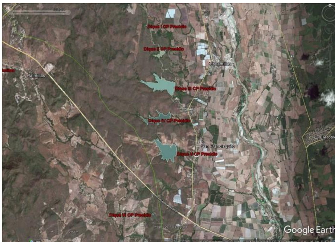
Figura 5. Diques localizados sobre el Río Presidio
