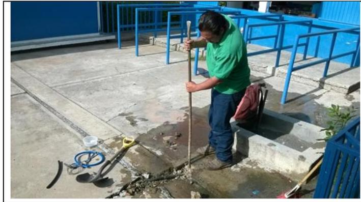
Ilustración 4 Reparación de fuga en una toma domiciliaria
