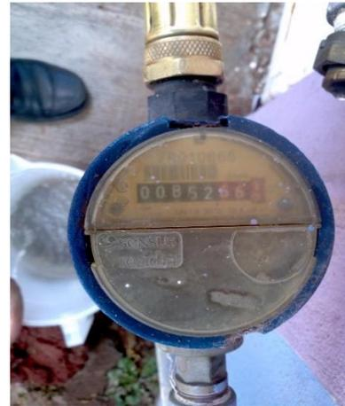
Ilustración 32 Medidores desgastados por la intemperie. Fuente: Elaborado por el IMTA.
