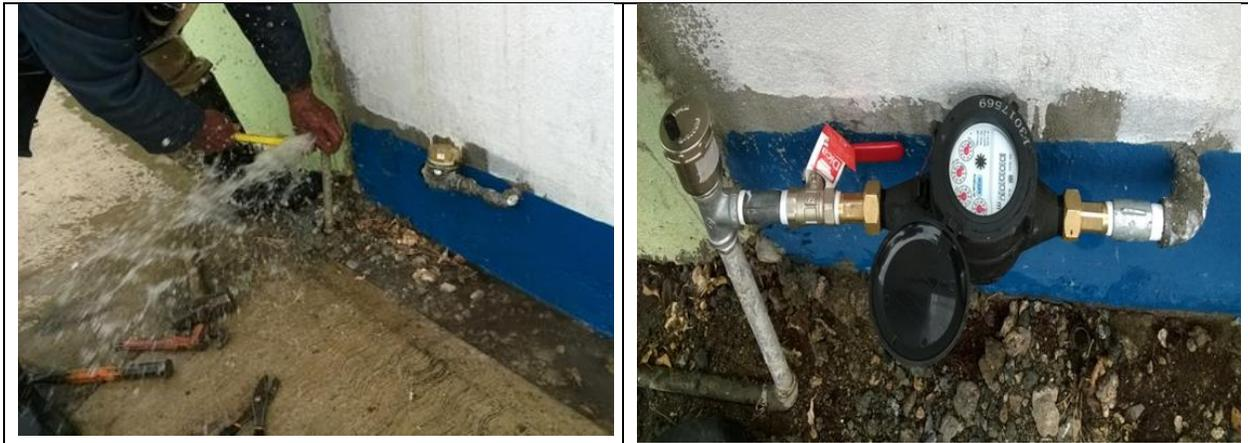
Ilustración 27 Trabajos de mantenimiento y sustitución de micromedidor: Fuente de SMAPA
