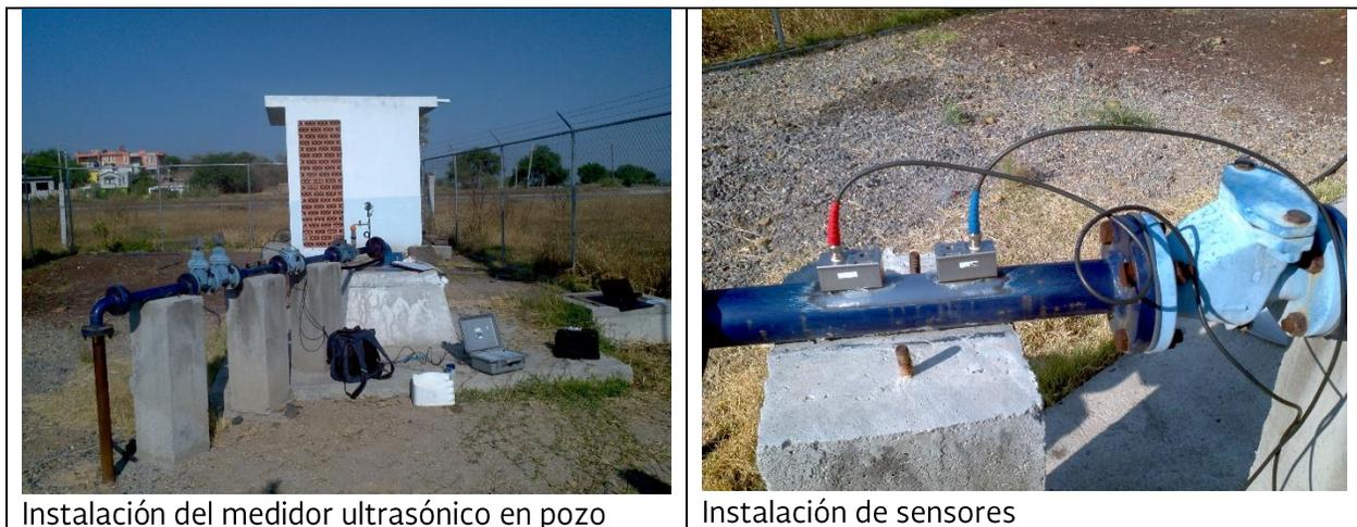
Ilustración 35 Instalación del equipo ultrasónico en el pozo
