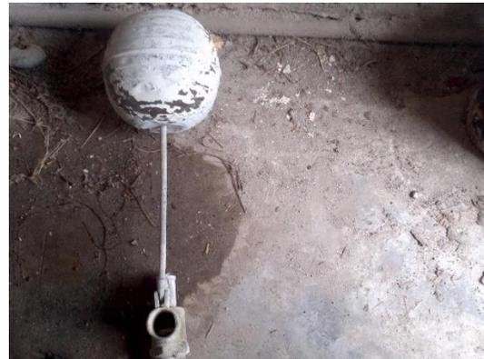
Ilustración 7 Agua de la cisterna muy cristalina, cambio de flotador metálico por uno de unisel por la calidad del agua.
