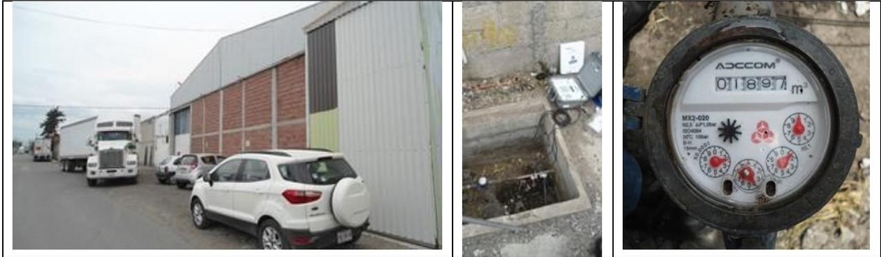
**Figura 34.** Auditoría en medidor del usuario 11552. Serie 1602000249, DN 19 mm, clase B. Medición 1 h.
