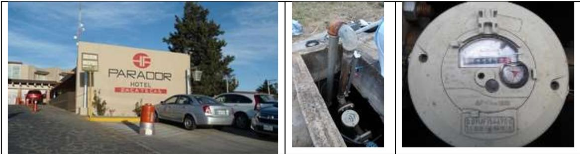
Figura 77. Auditoría en el medidor del usuario 88565. Serie D09UF154690C, DN 50 mm, clase C. Medición 24 h.
