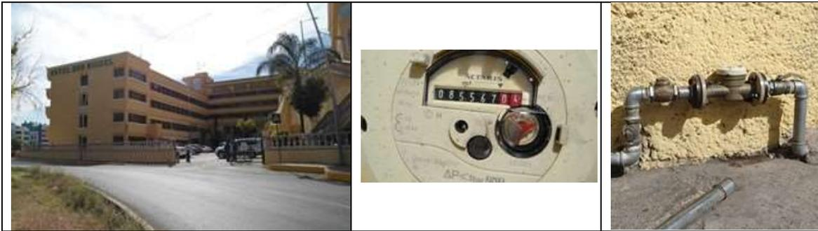
Figura 79. Auditoría en el medidor del usuario 88450. Serie D09UF154846E, DN 50 mm, clase C. Medición 2.5 h.
