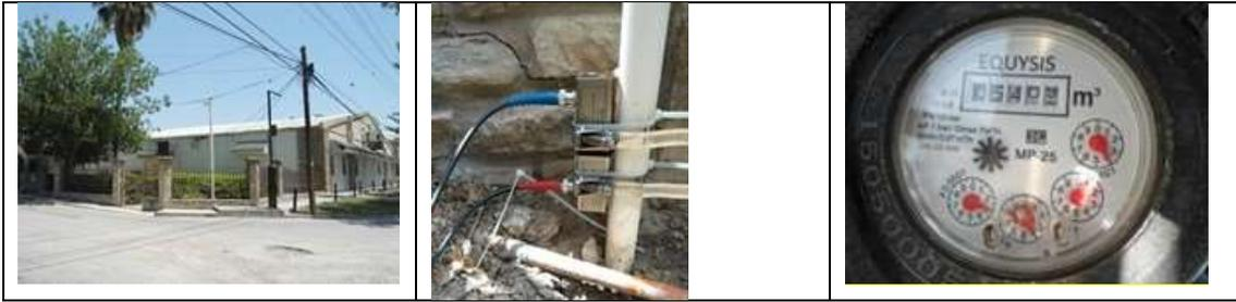
Figura 69. Auditoría en el medidor del usuario 6433 Serie 150500056, DN 25 mm, clase B. Medición 1 h.
