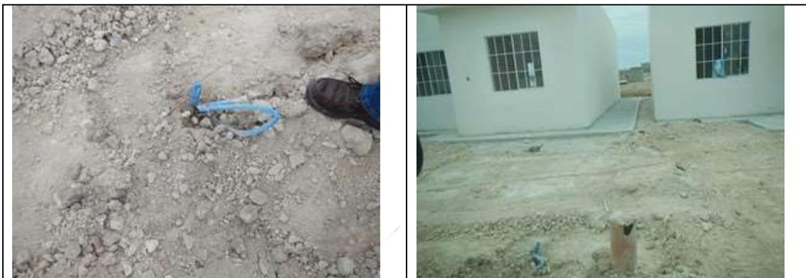
**Figura 66.** Detalles de preparación de toma domiciliaria y material utilizado.
