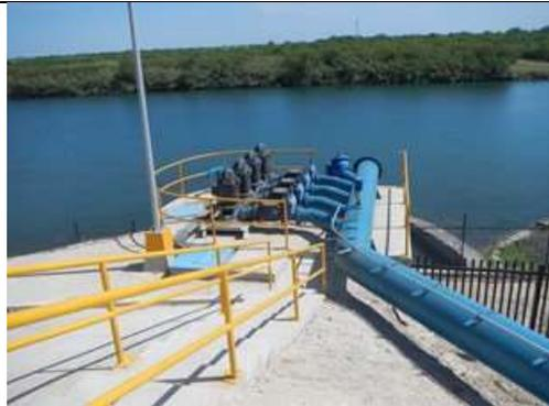
**Figura 14.** Captación en el Río Bravo de la Planta Potabilizadora 1, renovada.
