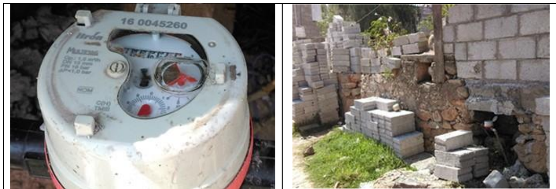
Figura 27. Medidor Itrón, Multimag 160045260, clase C, sin VAF. Detalles de medidor con número de serie. Comunidad Urecho, municipio de Colón. Lectura del medidor: 0.390 m 3 . No se encontraba el usuario o la casa está deshabitada.
