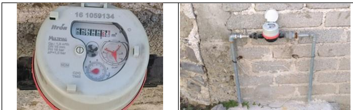
Figura 21. Medidor Itron, Multimag 161059134, clase C, con VAF1. Detalles de medidor con número de serie. Comunidad San Antonio de la Cal, municipio de Colón. Lectura del medidor: 200.614 m3.
