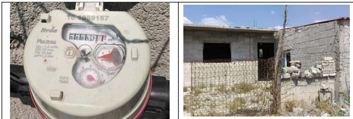
Figura 20. Medidor Itron, Multimag 161059157, clase C, con VAF1. Detalles de medidor con número de serie. Comunidad Piedras Negras, municipio de Colón. Lectura del medidor: 52.798 m3. El predio está en construcción.
