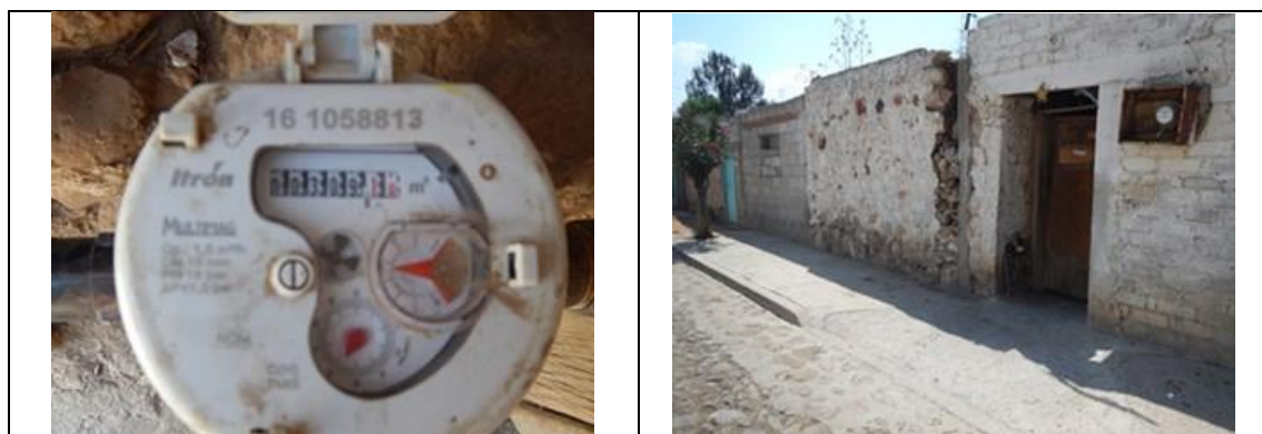
Figura 18. Medidor Itrón, Multimag 161058813, clase C, sin VAF. Detalles de medidor con número de serie. Comunidad La Peñuela, municipio de Colón. Lectura del medidor: 309.18 m 3 .
