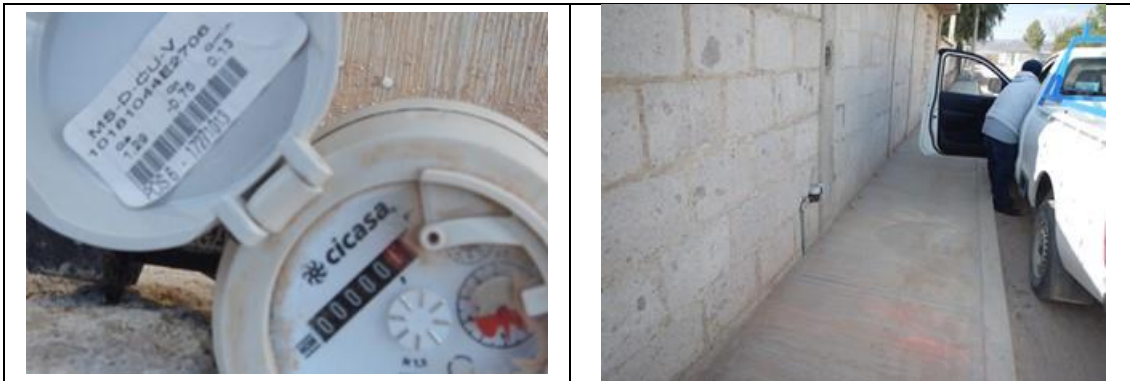
Figura 28. Medidor CICASA, MS Delaunet 17271013, clase B, con VAF1. Detalles de medidor con número de serie. Comunidad Viborillas, municipio de Colón. Lectura del medidor: 0.10 m3.
