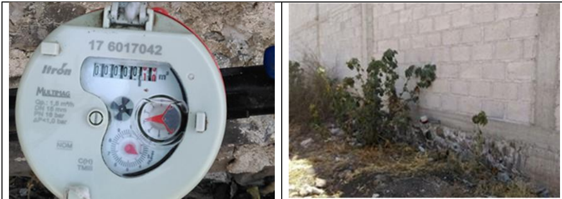
Figura 25. Medidor Itrón, Multimag 176017042, clase C, sin VAF. Detalles de medidor con número de serie. Comunidad Santa Rosa de Lima, municipio de Colón. Lectura del medidor: 0.107 m 3 . No está el usuario o la casa está deshabitada.
