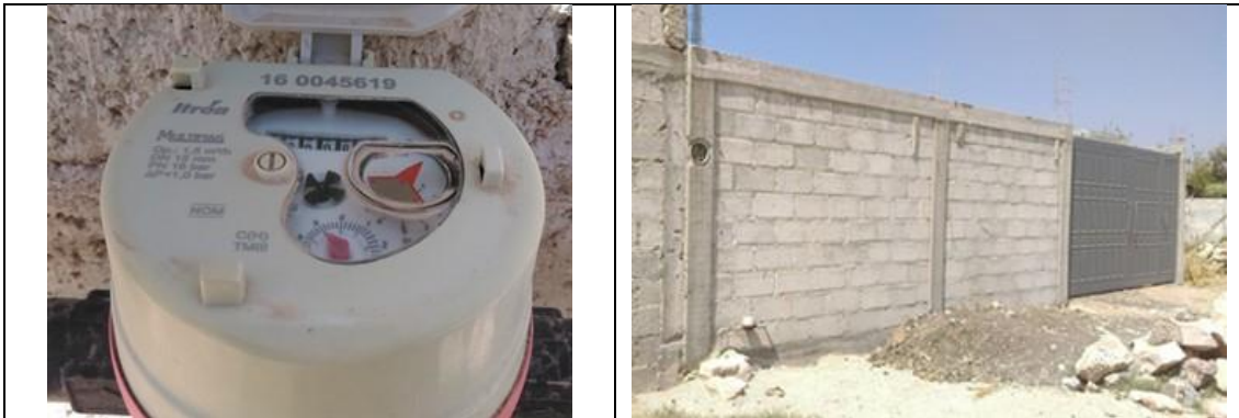
Figura 13. Medidor Itrón, Multimag 160045619, clase C, sin VAF. Detalles de medidor con número de serie. Comunidad Galeras, municipio de Colón. Lectura del medidor: 9.751 m 3 . Predio en Construcción.
