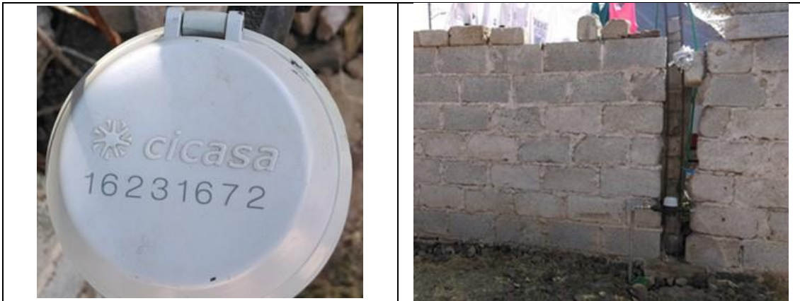
Figura 7. Medidor CICASA, MS Delaunet 16231672, clase B, con VAF1. Detalles de medidor con número de serie. Comunidad El Gallo, municipio de Colón. Lectura del medidor: 48.747 m3. El usuario manifestó que continuamente tiene que apretar el niple con la VAF porque hay fuga.
