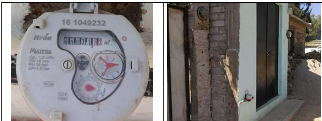
Figura 6. Medidor Itron, Multimag 161049232, clase C, sin VAF. Detalles de medidor con número de serie. Comunidad El Gallo, municipio de Colón. Lectura del medidor: 31.732 m 3 .
