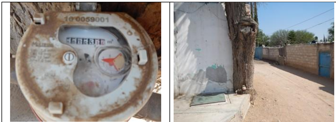
Figura 17. Medidor Itrón, Multimag 160059001, clase C, con VAF2. Detalles de medidor con número de serie. Comunidad La Peñuela, municipio de Colón. Lectura del medidor: 365.14 m 3 .
