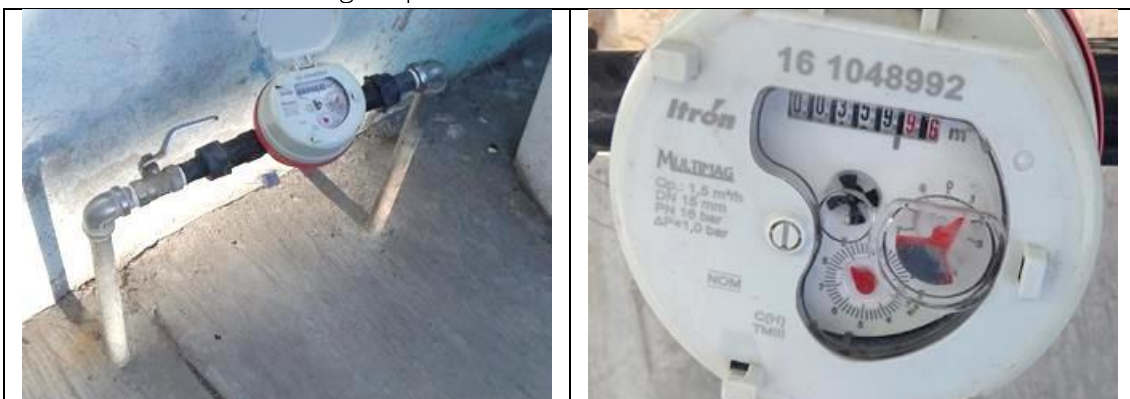
Figura 26. Medidor Itrón, Multimag 161048992, clase C, sin VAF. Cuadro de toma y detalle de medidor con número de serie. Comunidad Santa Cruz Forrajes, municipio de El Marqués. Lectura del medidor: 359.96 m 3 . No se encontró a ninguna persona en el domicilio.
