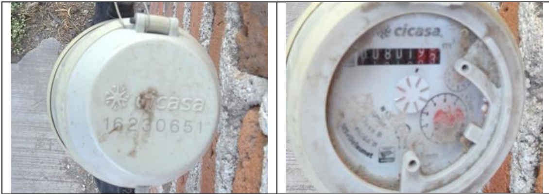
Figura 24. Medidor CICASA, MS Delaunet 16230651, clase B, sin VAF. Detalles de medidor con número de serie. Comunidad Santa Cruz Forrajes, municipio de El Marqués. Lectura del medidor: 801.92 m 3 . Se encontró que debe corregirse el modelo (es MS-Delaunet, no Aquarius ½), en el padrón de usuarios. No se encontró a ninguna persona en el domicilio.
