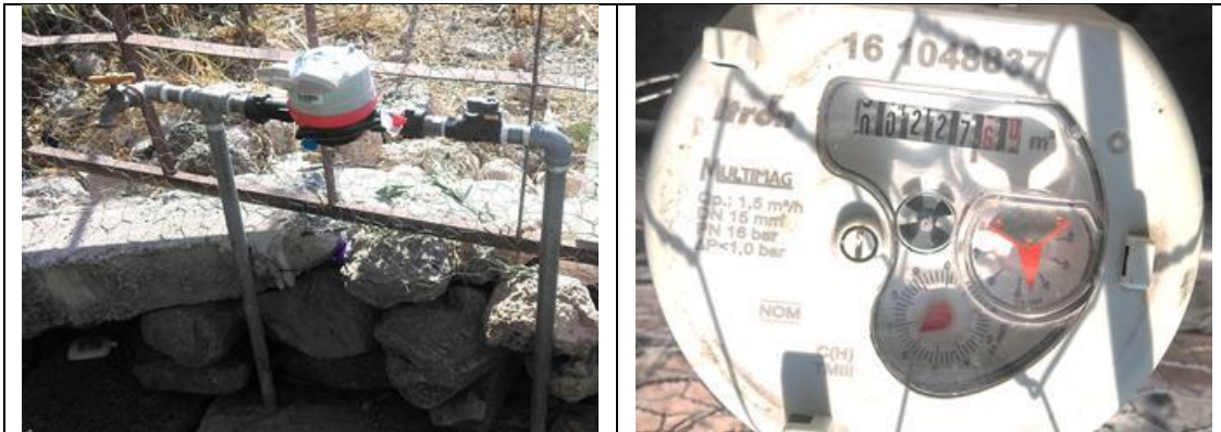
Figura 1. Medidor Itrón, Multimag 161048837, clase C, con VAF2. Cuadro de toma y detalle de medidor con número de serie. Comunidad Agua Azul, municipio de El Marqués. Lectura del medidor: 227.60 m 3 . Atendió sobrina del usuario titular, quien ya falleció.
