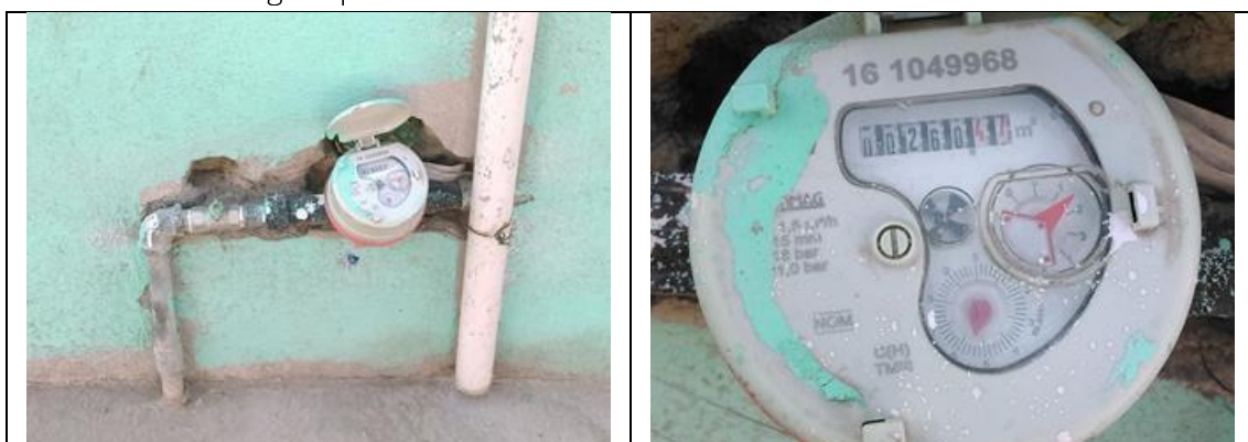
Figura 15. Medidor Itrón, Multimag 161049968, clase C, sin VAF. Cuadro de toma y detalle de medidor con número de serie. Colonia San Isidro Miranda, municipio de El Marqués. Lectura del medidor: 260.47 m 3 . Se encontró que el predio tiene datos de identificación, es M 11 L 7, por lo que debe registrarse en el padrón de usuarios. No se encontró a ninguna persona en el domicilio.
