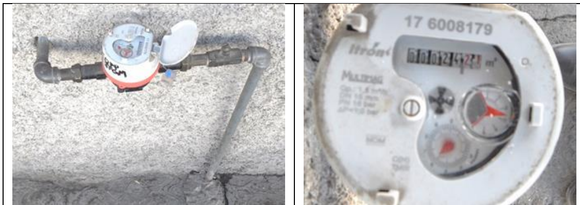
Figura 2. Medidor Itrón, Multimag 176008179, clase C, sin VAF. Cuadro de toma y detalle de medidor con número de serie. Comunidad Chichimequillas, municipio de El Marqués. Lectura del medidor: 24.21 m 3 . Atendió hijo de la usuaria titular.
