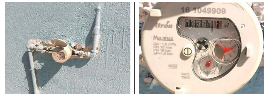
Figura 18. Medidor Itron, Multimag 161049909, clase C, sin VAF. Cuadro de toma y detalle de medidor con número de serie. Colonia San Isidro Miranda, municipio de El Marqués. Lectura del medidor: 239.09 m 3 . Debe registrarse el número de predio (es 40) en el padrón de usuarios. Atendió usuario titular.
