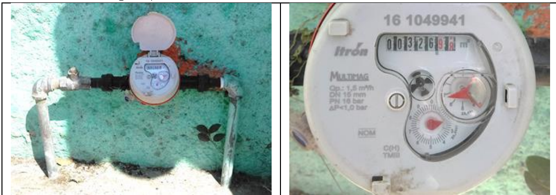
Figura 17. Medidor Itron, Multimag 161049941, clase C, sin VAF. Cuadro de toma y detalle de medidor con número de serie. Colonia San Isidro Miranda, municipio de El Marqués. Lectura del medidor: 326.97 m 3 . Atendió esposa del usuario titular.
