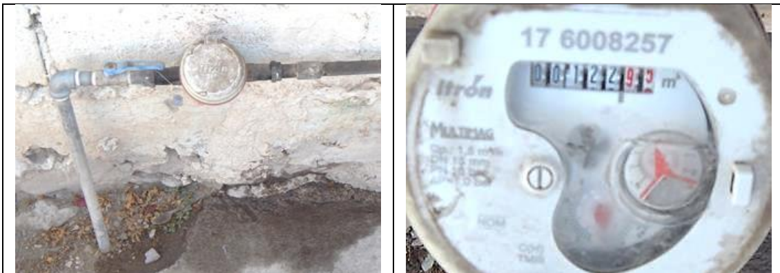
Figura 6. Medidor Itrón, Multimag 176008257, clase C, sin VAF. Cuadro de toma y detalle de medidor con número de serie. Comunidad Chichimequillas, municipio de El Marqués. Lectura del medidor: 122.95 m 3 . Se encontró que el medidor está roto. Atendió usuario titular.
