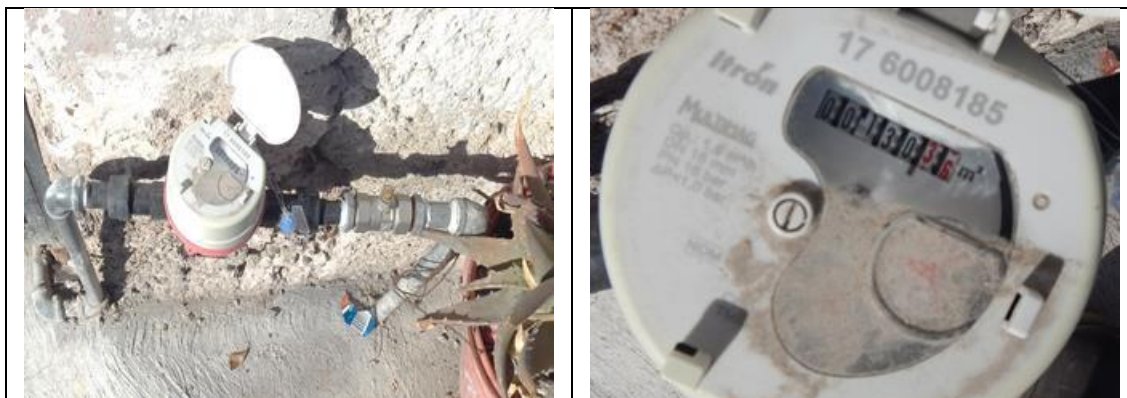
Figura 3. Medidor Itrón, Multimag 176008185, clase C, sin VAF. Cuadro de toma y detalle de medidor con número de serie. Comunidad Chichimequillas, municipio de El Marqués. Lectura del medidor: 130.35 m 3 . Atendió familiar del usuario titular.
