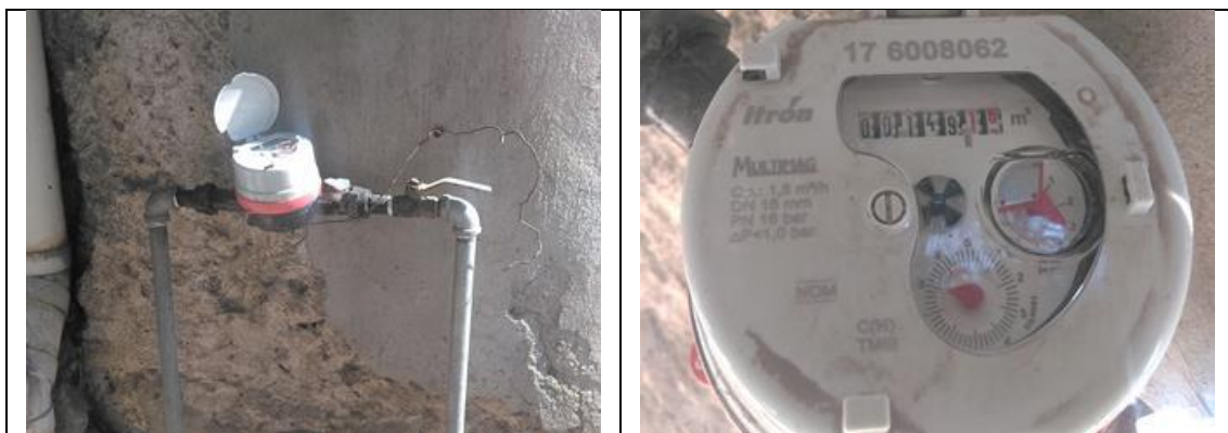
Figura 9. Medidor Itrón, Multimag 176008062, clase C, sin VAF. Cuadro de toma y detalle de medidor con número de serie. Comunidad El Colorado, municipio de El Marqués. Lectura del medidor: 149.16 m 3 . No se encontró a ninguna persona en el domicilio.
