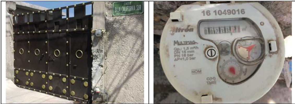
Figura 19. Itron, Multimag Medidor 161049016, clase C, sin VAF. Frente del predio y detalle de medidor con número de serie. Colonia San Isidro Miranda, municipio de El Marqués. Lectura del medidor: 233.11 m 3 . No se encontró a ninguna persona en el domicilio.
