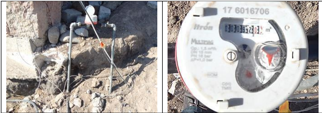
Figura 27. Medidor Itrón, Multimag 176016706, clase C, sin VAF. Cuadro de toma y detalle de medidor con número de serie. Comunidad Santa María de los Baños, municipio de El Marqués. Lectura del medidor: 92.04 m 3 . No se encontró a ninguna persona en el domicilio.
