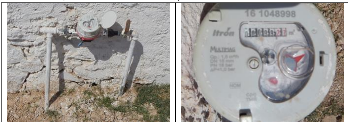
Figura 21. Medidor Itron, Multimag 161048998, clase C, sin VAF. Cuadro de toma y detalle de medidor con número de serie. Comunidad San José Navajas, municipio de El Marqués. Lectura del medidor: 99.27 m 3 . Atendió usuario titular.
