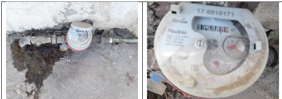
Figura 23. Medidor Itrón, Multimag 176018171, clase C, sin VAF. Cuadro de toma y detalle de medidor con número de serie. Comunidad Santa Cruz Forrajes, municipio de El Marqués. Lectura del medidor: 201.88 m 3 . Se encontró una pequeña fuga en una de las conexiones del cuadro de instalación. No se encontró a ninguna persona en el domicilio.
