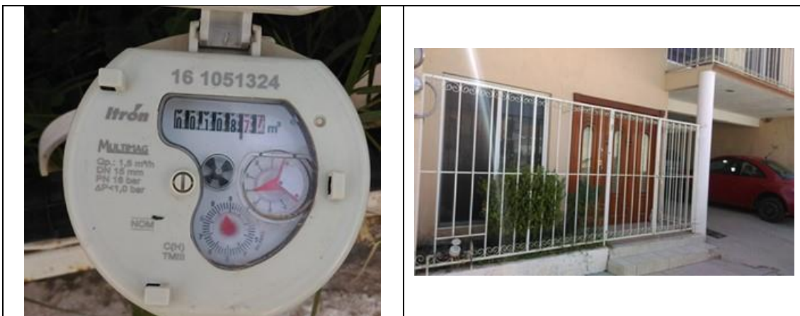
Figura 17. Medidor Itrón, Multimag 161051324, clase C, sin VAF. Detalles de medidor con número de serie. Colonia Centro, municipio de Ezequiel Montes. Lectura del medidor: 108.777 m 3 .
