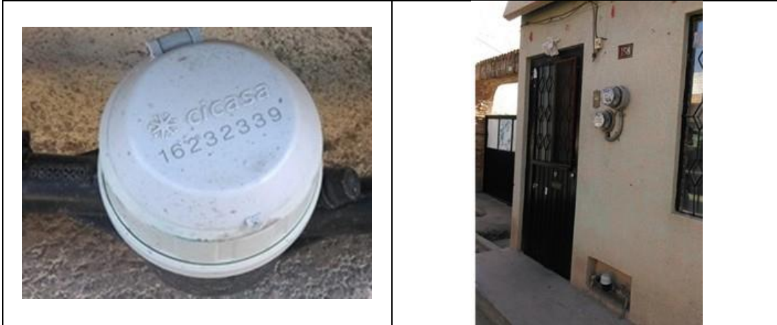
Figura 16. Medidor CICASA, MS Delaunet 16232339, clase B, con VAF1 . Detalles de medidor con número de serie. Colonia Centro, municipio de Ezequiel Montes. Lectura del medidor: 24.740 m 3 .
