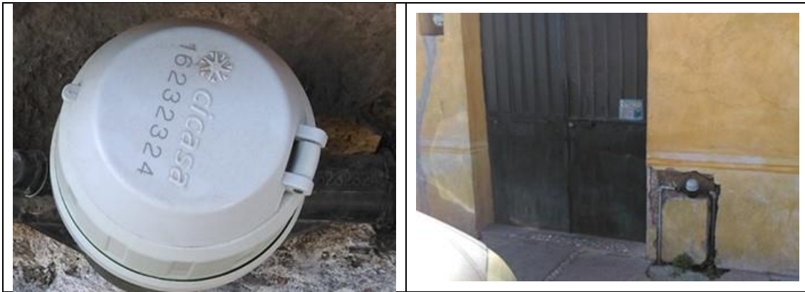
Figura 18. Medidor CICASA, MS Delaunet 16232324, clase B, con VAF1 . Detalles de medidor con número de serie. Colonia Centro, municipio de Ezequiel Montes. Lectura del medidor: 3.025 m 3 . El usuario manifestó que el medidor funciona bien
