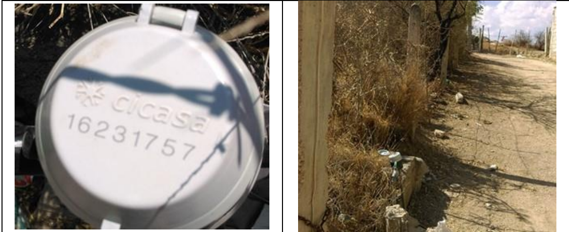
Figura 13. Medidor buscado Cicasa MS Delaunet 16232400, reemplazado por Cicasa MS Delaunet 16231757, clase B, sin VAF. Detalles de medidor con número de serie. Comunidad Horno de Cal, municipio de Ezequiel Montes. Lectura del medidor: 76.593 m 3 . El pago está domiciliado.
