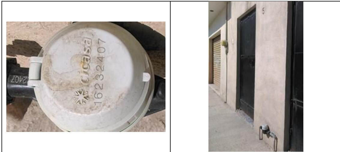
Figura 25. Medidor CICASA, MS Delaunet 16232407, clase B, sin VAF. Detalles de medidor con número de serie. Colonia La Bola, municipio de Ezequiel Montes. Lectura del medidor: 39.547 m 3 . La casa tiene el número 5 y en la base de datos no tiene número, por lo cual es recomendable actualizar dicha información en el padrón de usuarios.
