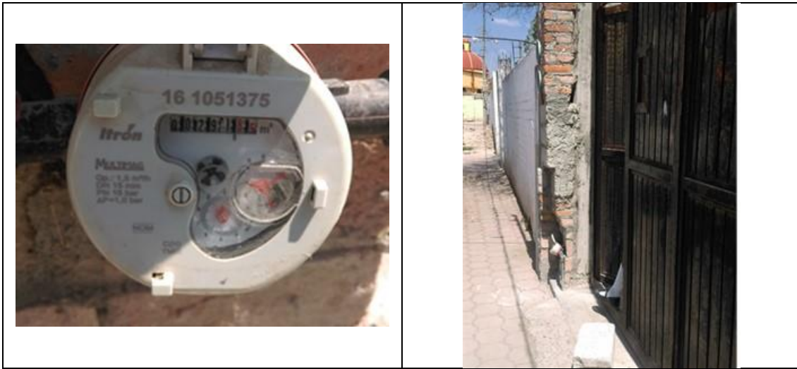
Figura 29. Medidor Itron, Multimag 161051375, clase C, sin VAF. Detalles de medidor con número de serie. Comunidad El Ciervo, municipio de Ezequiel Montes. Lectura del medidor: 291.848 m 3 .
