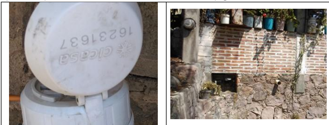
Figura 14. Medidor CICASA, MS Delaunet 160025422, clase C, sin VAF. Detalles de medidor con número de serie. Colonia Centro, municipio de Ezequiel Montes. Lectura del medidor: 279.363 m 3 .
