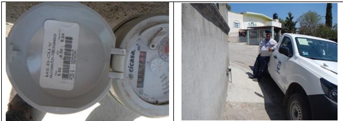
Figura 2. Medidor CICASA, MS Delaunet 16232247, clase B, sin VAF. Detalles de medidor con número de serie. Barrio San José Villa Progreso, municipio de Ezequiel Montes. Lectura del medidor: 107.02 m 3 .
