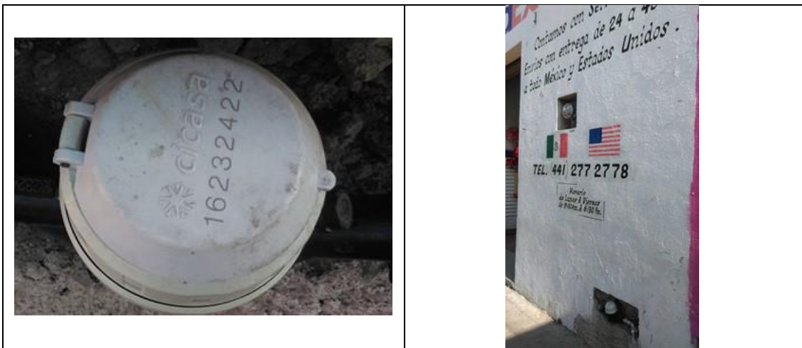
Figura 21. Medidor CICASA, MS Delaunet 16232422, clase B, sin VAF. Detalles de medidor con número de serie. Colonia Centro, municipio de Ezequiel Montes. Lectura del medidor: 5.478 m 3 . El medidor está localizado en una empresa de mensajería.
