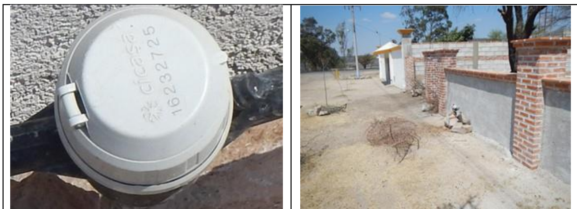
Figura 28. Medidor CICASA, MS Delaunet 16232725, clase B, con VAF2. Detalles de medidor con número de serie. Colonia San José Los Trejo, municipio de Ezequiel Montes. Lectura del medidor: 4.53 m 3 . El Predio está en construcción.
