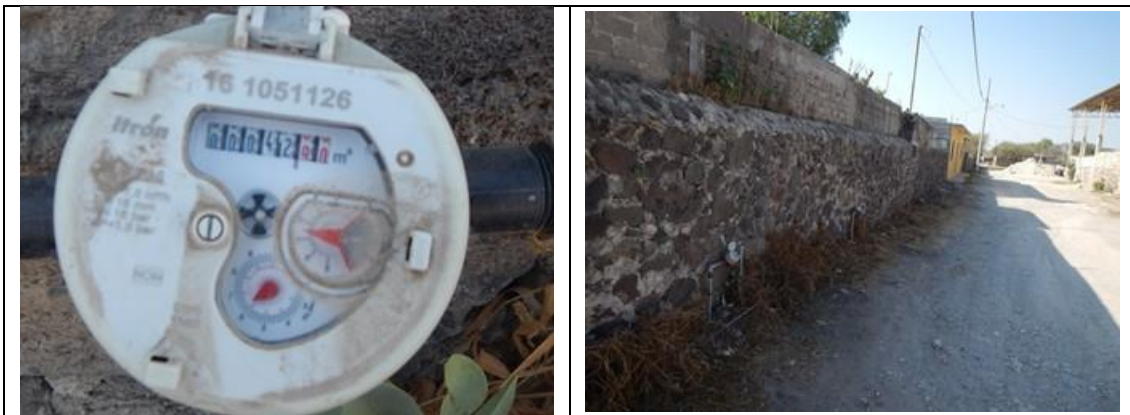
Figura 24. Medidor Itrón, Multimag 161051126, clase C, sin VAF. Detalles de medidor con número de serie. Colonia Jagüey Grande, municipio de Ezequiel Montes. Lectura del medidor: 42.90 m 3 .
