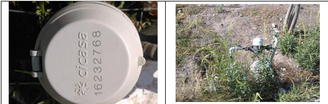
Figura 20. Medidor buscado Itrón Multimag 161051115, clase C, reemplazado por medidor CICASA, MS Delaunet 16232768, marca clase B, sin VAF. Localizado en la colonia Centro, municipio de Ezequiel Montes. Lectura del medidor: 2.385 m 3 . Este medidor reemplazó al medidor con serie 161051115 marca Itrón.
