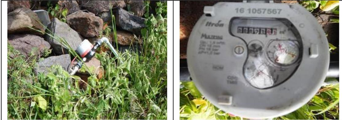
Figura 9. Medidor 161057567, clase C. Toma y detalle de medidor con número de serie. Sin VAF. Domicilio conocido S/N, localidad La Cuesta. Lectura del medidor: 23.90 m<sup>3</sup>.
