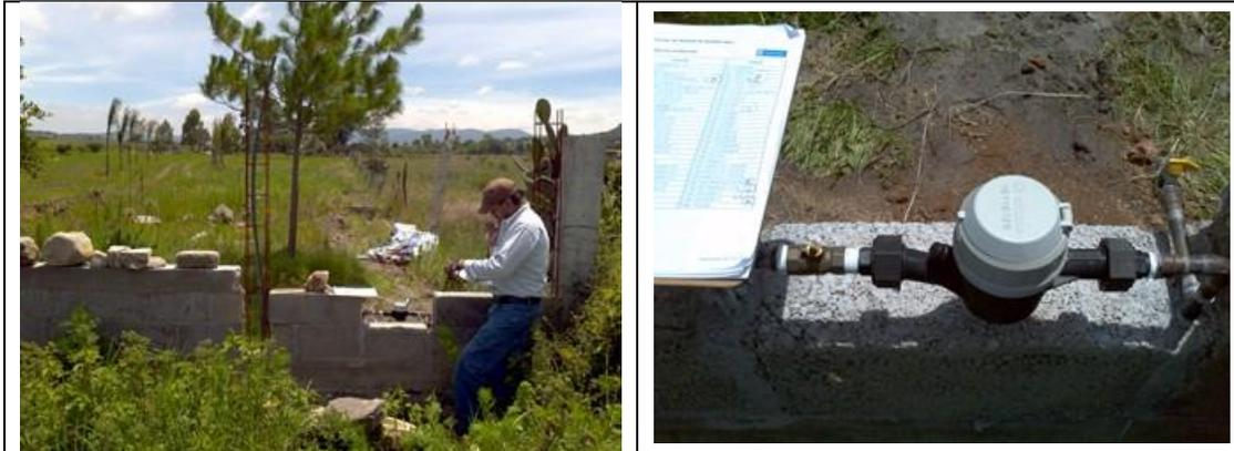
Figura 30. Medidor 16118126. Clase B. Predio con toma y detalle de medidor con número de serie. Sin VAF. Ubicación Comunidad Capula. En obra de barda. Toma lozalizada en segunda vuelta de recorrido. Lectura del medidor: 11.04 m<sup>3</sup>.
