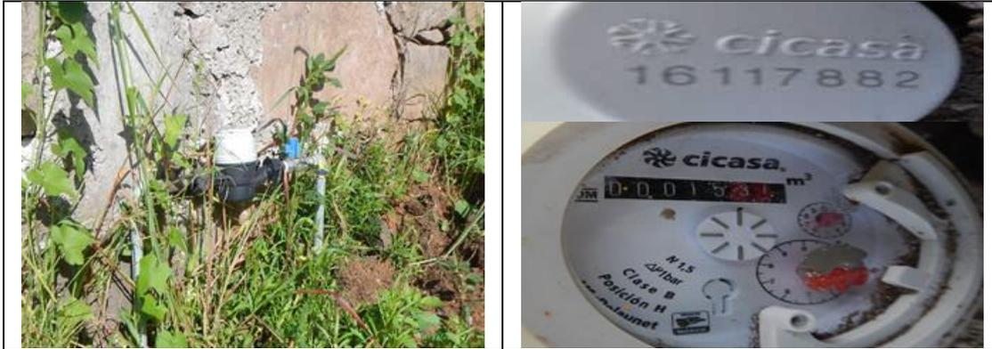
Figura 6. Medidor 16117882, clase B. Toma y detalle de medidor con número de serie. Con VAF. Carr. Estatal 400 km 81.8, localidad La Ceja. Lectura del medidor: 15.37 m<sup>3</sup>. Se encontró que el modelo del medidor no corresponde al registrado en el padrón de usuarios de la CEA.
