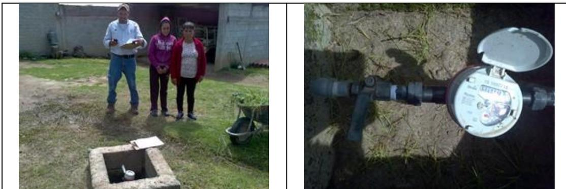
Figura 29. Medidor 161057715. Clase C. Predio con toma y detalle de medidor con número de serie. Sin VAF. La esposa del usuario titular manifestó que el anterior lo cambiaron por sobre medición, que pagaba más de mil pesos. Se nota muy alta presión, que se debe medir. Ubicación Comunidad San pedrito. Lectura del medidor: 27.49 m<sup>3</sup>.
