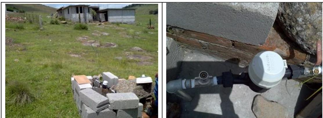
Figura 32. Medidor 16117970. Clase B. Predio con toma y detalle de medidor con número de serie. Toma nueva con VAF. Ubicación Comunidad La joya. Lectura del medidor: 65.7 m<sup>3</sup>.
