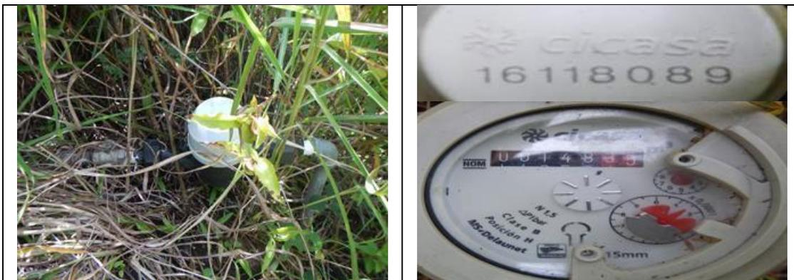
Figura 16. Medidor 16118089, clase B. Toma y detalle de medidor con número de serie. Sin VAF. Domicilio conocido S/N, localidad Paniagua. Lectura del medidor: 148.34 m<sup>3</sup>. Se encontró que el modelo del medidor no corresponde al registrado en el padrón de usuarios de la CEA. El medidor se encuentra lejos de la vivienda a la que abastece y se debe ingresar a campos de siembra de difícil acceso, por la espesura de la hierba.
