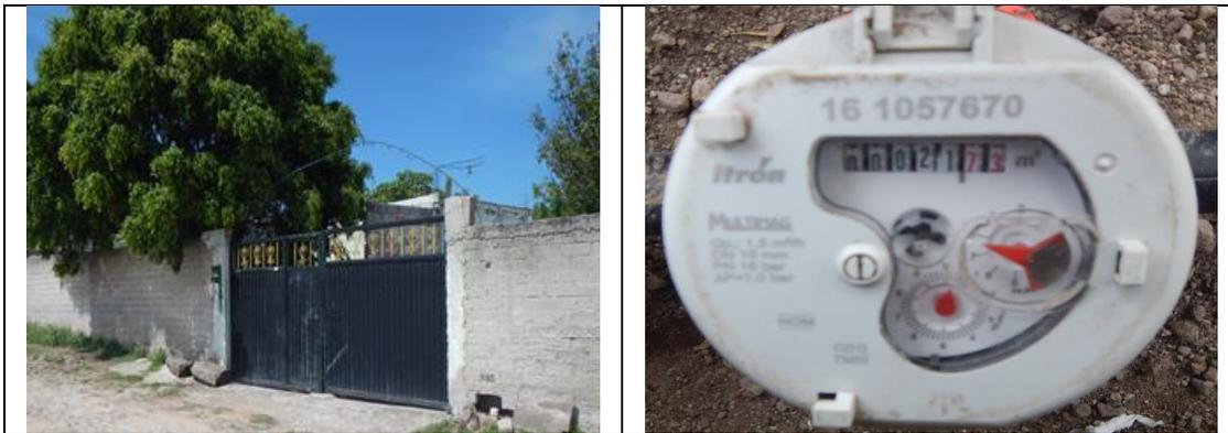
Figura 13. Medidor 161057670, clase C. Predio con toma y detalle de medidor con número de serie. Con VAF. Calle Los Pinos No. 7, localidad Puerta del Tepozán. Lectura del medidor: 21.72 m<sup>3</sup>. La calle tiene el nombre de Los Pinos y el predio es el número 7, lo que debiera cambiarse en el padrón de usuarios, ya que en este aparece como "Domicilio conocido S/N".
