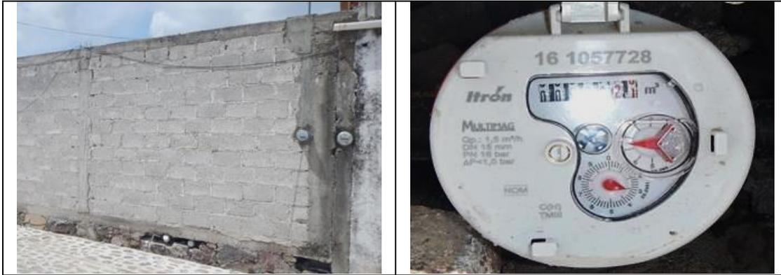
Figura 22. Medidor 161057728, clase C. Predio con toma y detalle de medidor con número de serie. Sin VAF. Calle Vicente Guerrero S/N, col. Lagunillas. Lectura del medidor: 8.20 m<sup>3</sup>. De acuerdo al recorrido, el predio está ubicado en la calle Vicente Guerrero de la localidad, mientras que en el padrón de usuarios dice Domicilio conocido, por lo que se recomienda cambiarlo en el padrón de usuarios para facilitar su ubicación.
