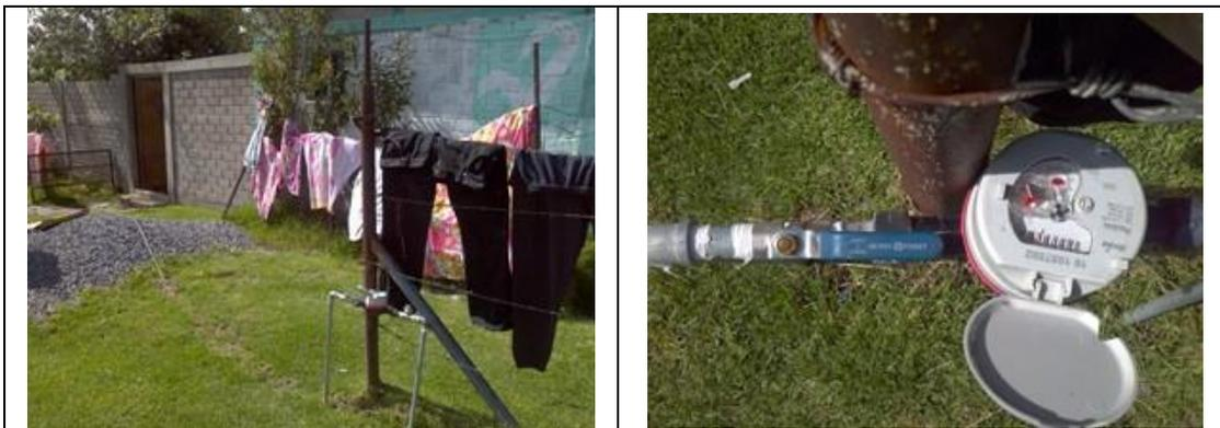
Figura 26. Medidor 161057592, clase C. Predio con toma y detalle de medidor con número de serie. Con VAF. Ubicación Comunidad San Ignacio. Toma y medidor nuevos. Recibo con comisionista. Lectura del medidor: 79.26 m<sup>3</sup>.
