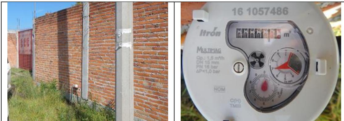
Figura 7. Medidor 161057486, clase C. Predio con toma y detalle de medidor con número de serie. Con VAF. Domicilio conocido S/N, localidad La Ceja. Lectura del medidor: 0.04 m<sup>3</sup>.
