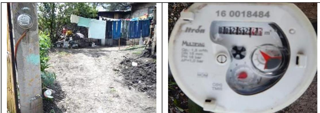
Figura 21. Medidor 160018484, clase C. Predio con toma y detalle de medidor con número de serie. Sin VAF. Calle Arroyo Seco S/N, localidad La Noria. Lectura del medidor: 252.40 m<sup>3</sup>. Se encontró que el modelo del medidor no corresponde al registrado en el
