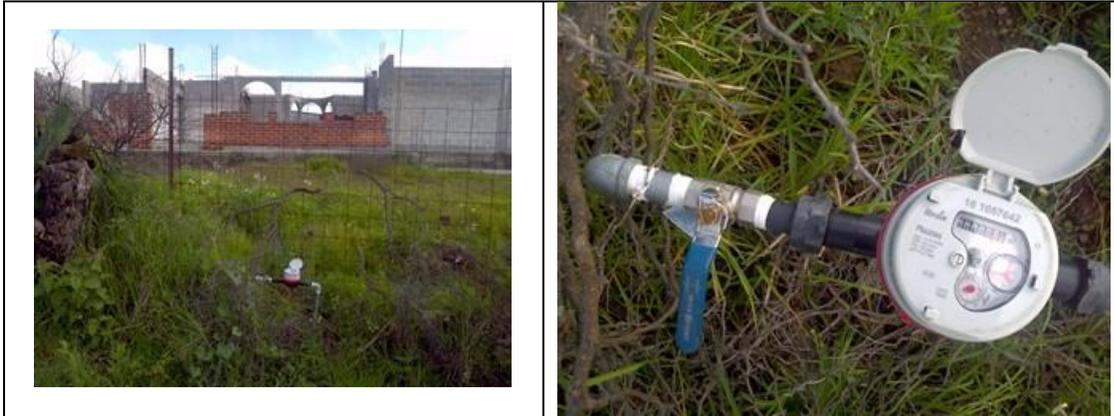
Figura 24. Medidor 161057642, clase C. Predio con toma y detalle de medidor con número de serie. Sin VAF. Toma nueva en casa en construcción. Ubicación en Comunidad de San Francisco Sur. Acuden a oficina a recoger recibo y a pagar. Lectura del medidor: 0.08 m<sup>3</sup>.
