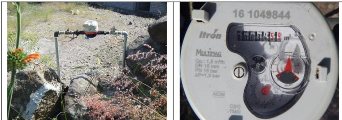
Figura 8. Medidor 161049844, clase C. Predio con toma y detalle de medidor con número de serie. Con VAF. Domicilio conocido S/N, localidad La Cuesta. Lectura del medidor: 34.59 m<sup>3</sup>. Obra en construcción.
