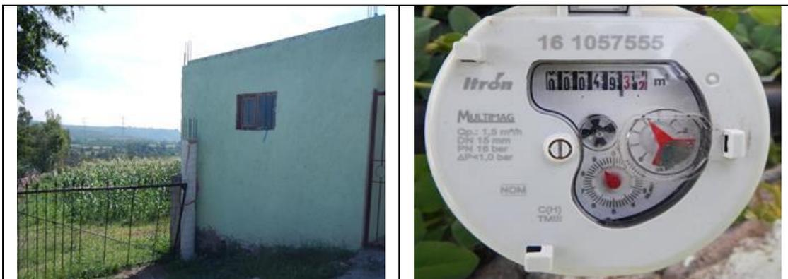
Figura 11. Medidor buscado 16117934, clase B; medidor encontrado 161057555, clase C. Predio con toma y detalle de medidor con número de serie. Sin VAF. Calle Eucalipto S/N, localidad Puerta del Tepozán. Lectura del medidor: 49.31 m<sup>3</sup>. Respecto a la
