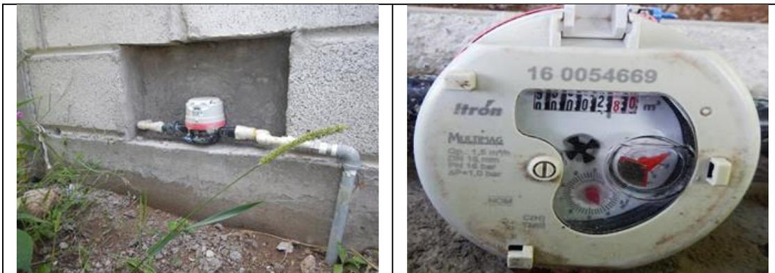
Figura 15. Medidor 160054669, clase C. Toma y detalle de medidor con número de serie. Sin VAF. Domicilio conocido S/N, localidad Carranza. Lectura del medidor: 2.80 m<sup>3</sup>. Se encontró que el modelo del medidor no corresponde al registrado en el padrón de usuarios de la CEA.
