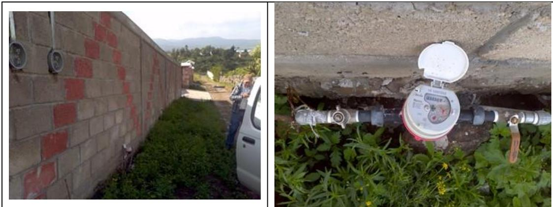
Figura 25. Medidor 161057532, clase C. Predio con toma y detalle de medidor con número de serie. Sin VAF. Ubicación en Comunidad de San Francisco Norte. Lectura del medidor: 45.78 m<sup>3</sup>.
