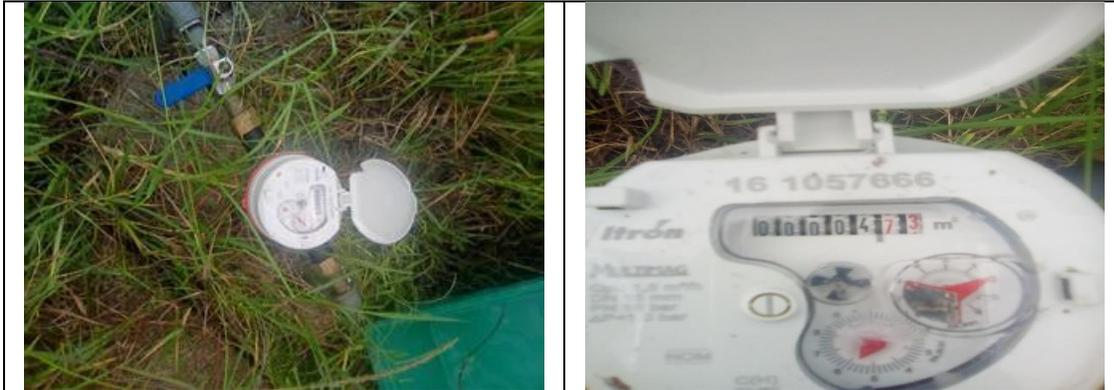
Figura 27. Medidor 161057666, clase C. Toma y detalle de medidor con número de serie. Sin VAF. Domicilio conocido, localidad La luz. Lectura del medidor: 4.73 m<sup>3</sup>. En los recorridos del IMTA no se había podido llegar debido al camino anegado. Fotos enviadas posteriormente por la CEA.
