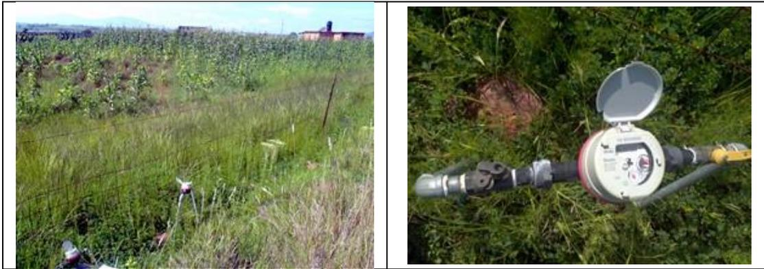
Figura 28. Medidor 160054694. Clase C. Predio con toma y detalle de medidor con número de serie. El medidor anterior no trabajaba (lecturista). Muy alejado de la vivienda. Con VAF existente, no nueva. Ubicación Comunidad El Sauz. Lectura del medidor: 264.98 m<sup>3</sup>.
