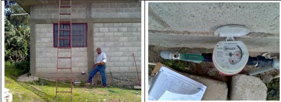
Figura 33. Medidor 160054674. Clase C. Predio con toma y detalle de medidor con número de serie. Sin VAF. Toma nueva con servicio continuo. Ubicación Comunidad Tepuzas. Lectura del medidor: 122 m<sup>3</sup>.
