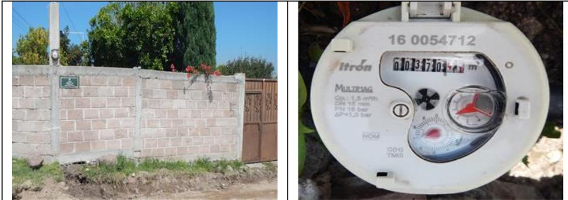
Figura 12. Medidor 160054712, clase C. Predio con toma y detalle de medidor con número de serie. Con VAF. Calle Los Pinos No. 5, localidad Puerta del Tepozán. Lectura del medidor: 370.40 m<sup>3</sup>. La calle tiene el nombre de Los Pinos y el predio es el número 5, lo que debiera cambiarse en el padrón de usuarios, ya que en este aparece como "Domicilio conocido S/N".
