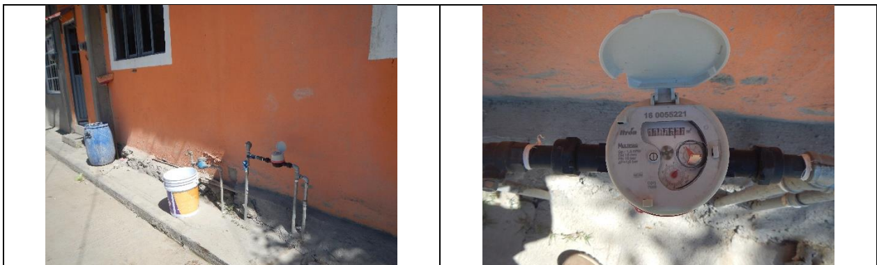
Figura 5. Medidor 160055221, clase C. Con VAF. Barrio el Puente, comunidad de Jalpan de Serra. Lectura del medidor: 113.07 m 3 . El modelo del medidor presenta diferencias con las características registradas por la CEA, en el padrón de usuarios.
