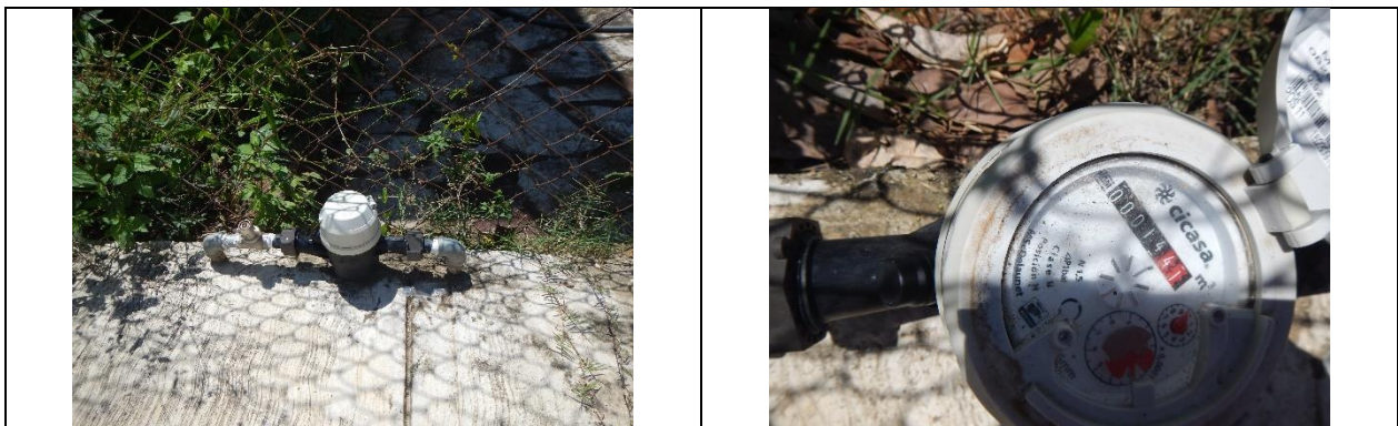
Figura 30. Medidor 16230916, Clase C. Predio con toma y detalle de medidor con número de serie. Con VAF. Localidad El Embocadero, municipio de Jalpan de Serra. Lectura del medidor: 14.41 m 3 . Se encontró que el modelo de medidor no corresponde al registrado en el padrón.
