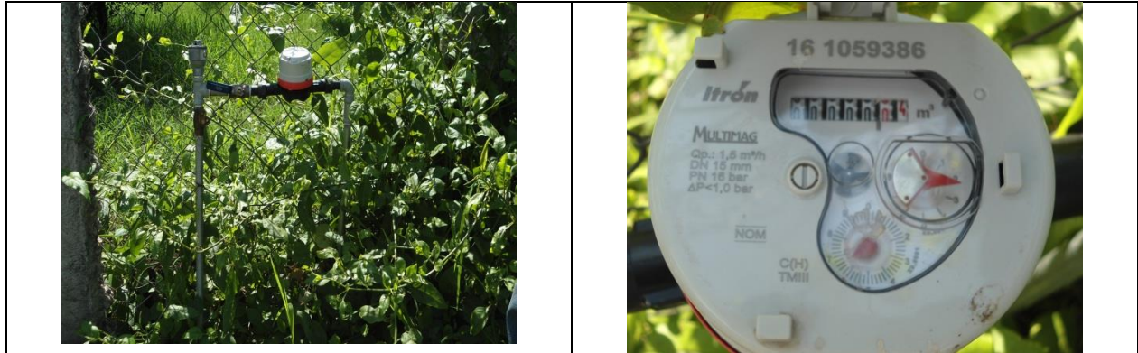
Figura 32. Medidor 161059386, Clase C. Predio con toma y detalle de medidor con número de serie. Con VAF. Localidad Tancoyol, municipio de Jalpan de Serra. Lectura del medidor: 0.04 m 3 . El número de medidor corresponde con el número proporcionado por la CEA, sin embargo se encontró que la marca y el modelo no corresponde al registrado en el padrón de usuarios.
