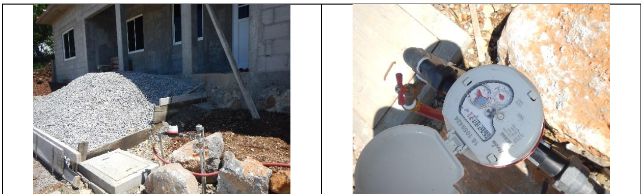
Figura 8. Medidor buscado 161059424, Clase C. Sin VAF. Colonia San José, comunidad de Jalpan de Serra. Lectura del medidor: 17.11 m 3 . El número de medidor corresponde con el número proporcionado por la CEA, sin embargo la marca, modelo y características (clase) del medidor no corresponden a las registradas en el padrón de usuarios.
