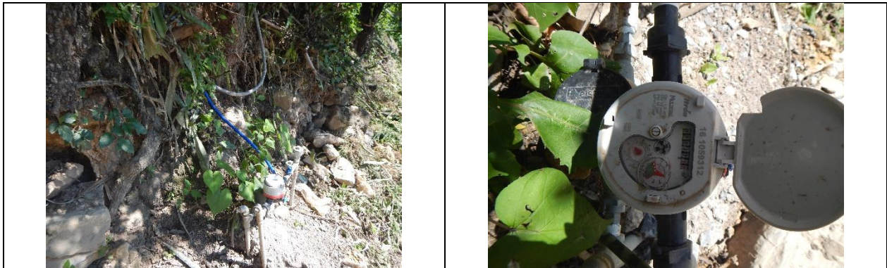
Figura 4. Medidor 161059312, Clase C. Con VAF. Barrio el Platanito. Lectura del medidor: 17.10 m 3 . El número de medidor corresponde con el número proporcionado por la CEA, sin embargo la marca, modelo y características (clase) del medidor no corresponden a las registradas en el padrón de usuarios.
