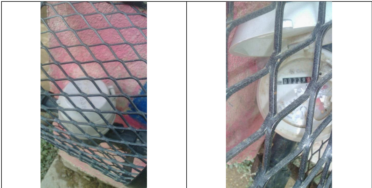
Figura 30. Medidor 16230916, Clase C. Predio con toma y detalle de medidor con número de serie. Con VAF. Localidad El Embocadero, municipio de Jalpan de Serra. Lectura del medidor: 14.41 m 3 . Se encontró que el modelo de medidor no corresponde al registrado en el padrón.
