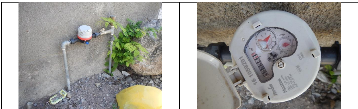
Figura 20. Medidor buscado 161059201, Clase C. Con VAF. Colonia Las Misiones, comunidad de Jalpan de Serra. Lectura del medidor: 84.43 m 3 . El número de medidor corresponde con el número proporcionado por la CEA, sin embargo la marca, modelo y características (clase) del medidor no corresponden a las registradas en el padrón de usuarios.
