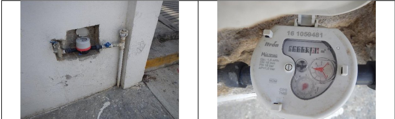
Figura 21. Medidor 161059481, Clase C. Con VAF. Colonia Las Misiones, comunidad de Jalpan de Serra. Lectura del medidor: 85.10 m 3 . El número de medidor corresponde con el número proporcionado por la CEA, sin embargo la marca, modelo y características (clase) del medidor no corresponden a las registradas en el padrón de usuarios.
