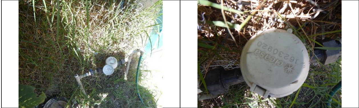
Figura 24. Medidor buscado 16230920, Clase B. Sin VAF. Localidad El Lindero, municipio de Jalpan de Serra. Lectura del medidor: 87.11 m 3 .
