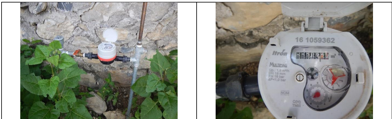
Figura 26. Medidor 161059362, Clase C. Predio con toma y detalle de medidor con número de serie. Sin VAF. Localidad La Saldiveña, municipio de Jalpan de Serra. Lectura del medidor: 14.87 m 3 . El número de
