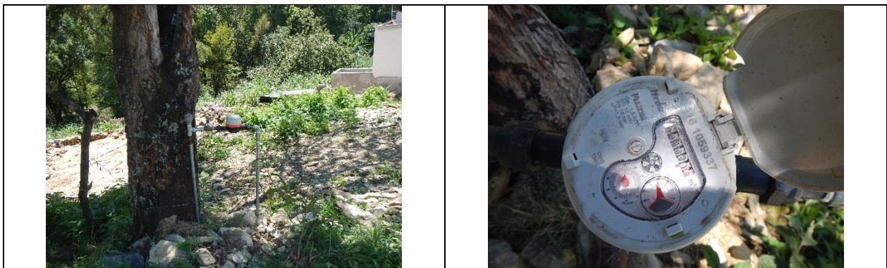
Figura 14. Medidor 161059337, Clase C. Sin VAF. Barrio Las Ortigas, comunidad de Jalpan de Serra. Lectura del medidor: 0.10 m 3 . Se encontró que la marca, modelo y demás características (clase) del medidor no corresponde al registrado en el padrón de usuarios de la CEA.
