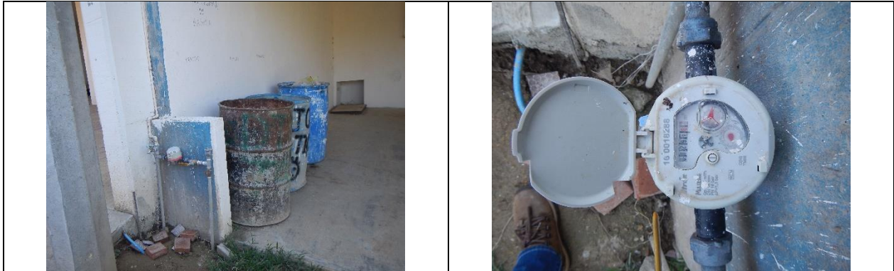
Figura 6. Medidor 160018288, clase C. Sin VAF. Colonia de Santa Cruz, Jalpan de Serra. Lectura del medidor: 293.03 m 3 . El modelo del medidor presenta diferencias con las características registradas por la CEA, en el padrón de usuarios.
