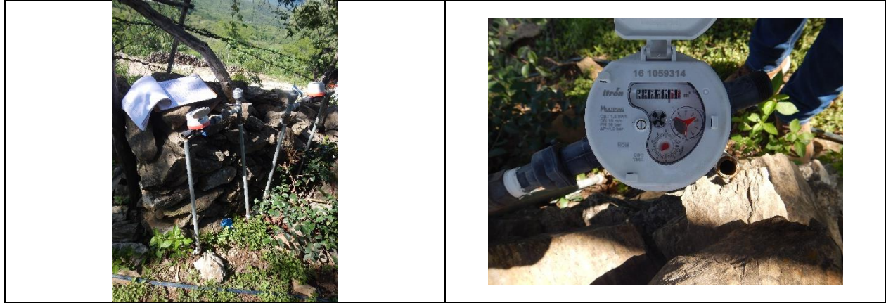
Figura 27. Medidor 161059314, Clase C. Predio con toma y detalle de medidor con número de serie. Sin VAF. Localidad Puerto de Animas, municipio de Jalpan de Serra. Lectura del medidor: 0.08 m 3 . El número de medidor corresponde con el número proporcionado por la CEA, sin embargo la marca, modelo y características (clase) del medidor no corresponden a las registradas en el padrón de usuarios. El medidor de encuentra desconectado por lo que aparentemente no ha tenido consumo.
