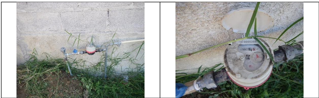
Figura 7. Medidor 160055265, Clase C. Predio con toma y detalle de medidor con número de serie. Con VAF. Colonia La Cruz, comunidad de Jalpan de Serra. Lectura del medidor: 29.25 m 3 .
