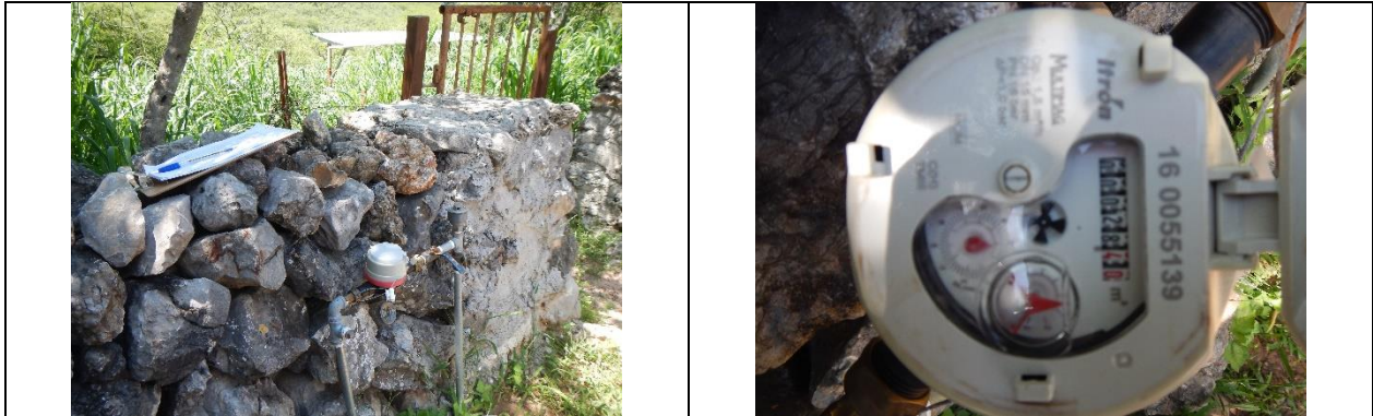
Figura 29. Medidor 16230815, Clase C. Sin VAF. Localidad El Saucillo, municipio Jalpan de Serra. Lectura del medidor: 28.40 m 3 .
