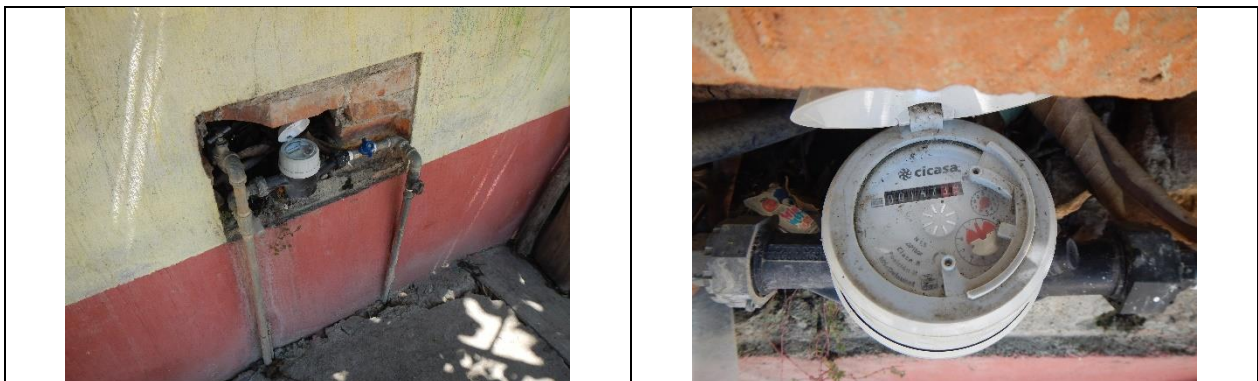
Figura 11. Medidor 16230827, Clase B. Predio con toma y detalle de medidor con número de serie. Con VAF. Colonia Vivah, comunidad de Jalpan de Serra. Lectura del medidor: 147.32 m 3 . Se encontró que el modelo de medidor no corresponde al registrado en el padrón de usuarios de la CEA.
