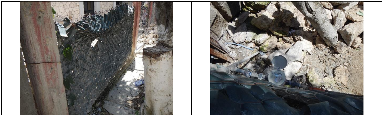
Figura 22. Medidor 160055111, Clase C. Predio con toma y detalle de medidor con número de serie. Con VAF. Colonia La Presa, comunidad de Jalpan de Serra. Lectura del medidor: 217.50 m 3 . Se encontró que el modelo de medidor no corresponde al registrado en el padrón, adicionalmente el medidor se encuentra dentro del domicilio cubierto por una malla metálica forrada que impide ubicarlo y ver con claridad las lecturas.
