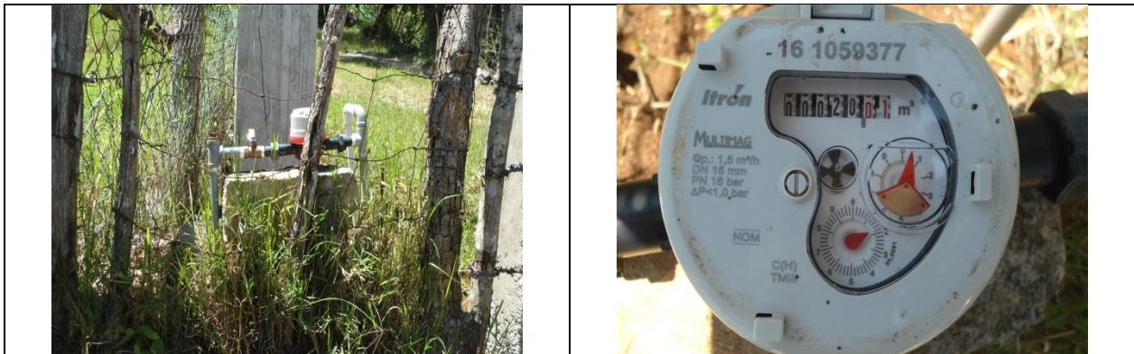
Figura 21. Medidor 161059377, clase C. Toma y detalle de medidor con número de serie. Sin VAF. Calle Colombia S/N, Barrio Cuba, localidad Otates. Lectura del medidor: 20.01 m 3 . El número de medidor corresponde con el número proporcionado por la CEA, sin embargo, se encontró que la marca, modelo y demás características (clase) del medidor no corresponden al registrado en el padrón de usuarios de la CEA.
