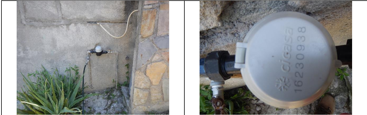
Figura 6. Medidor 16230938, clase B. Con VAF. Barrio San Miguel. Lectura del medidor: 148.93 m 3 . El modelo del medidor presenta diferencias con las características registradas por la CEA, en el padrón de usuarios.
