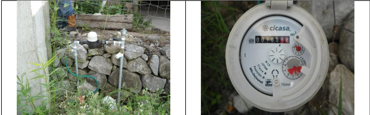
Figura 28. Medidor 16230987, clase B. Toma y detalle de carátula de medidor. Con VAF. Calle Girasoles S/N, localidad El Aguacate. Lectura del medidor: 165.87 m 3 . Se encontró que el modelo del medidor no corresponde al registrado en el padrón de usuarios de la CEA.
