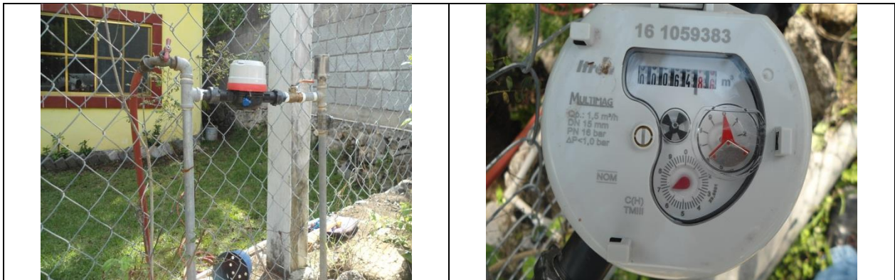
Figura 29. Medidor 161059383, clase C. Predio con toma y detalle de medidor con número de serie. Con VAF. Calle Girasoles S/N, localidad El Aguacate. Lectura del medidor: 64.85 m 3 . El número de medidor corresponde con el número proporcionado por la CEA, sin embargo, se encontró que la marca, modelo y demás características (clase) del medidor no corresponden al registrado en el padrón de usuarios de la CEA.
