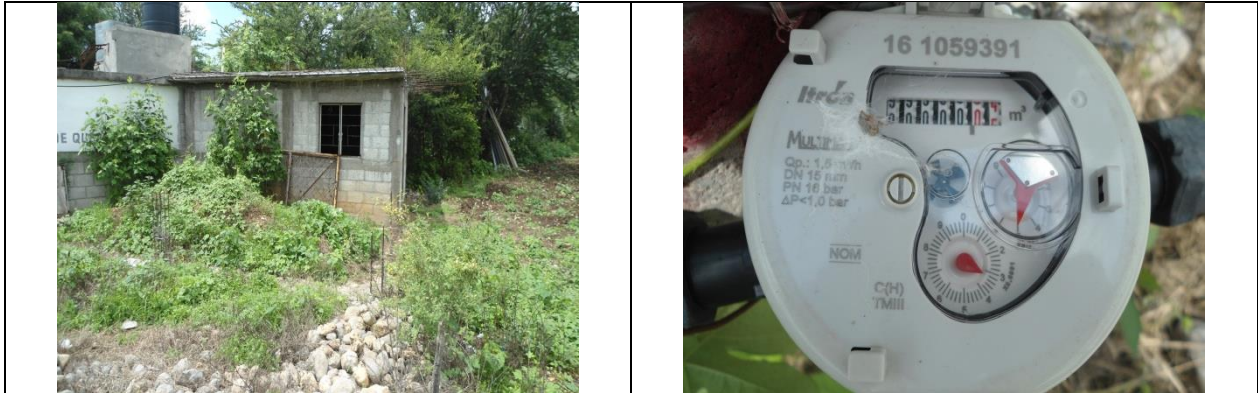
Figura 25. Medidor 161059391, clase C. Predio y detalle de medidor con número de serie. Con VAF. Calle El Rodeo S/N, localidad La Lagunita. Lectura del medidor: 0.04 m 3 . El número de medidor corresponde con el número proporcionado por la CEA, sin embargo, se encontró que la marca, modelo y demás características (clase) del medidor no corresponden al registrado en el padrón de usuarios de la CEA.
