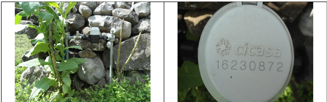
Figura 30. Medidor 16230872, clase B. Toma y detalle de medidor con número de serie. Con VAF. Calle San Francisco S/N, localidad El Malpais. Lectura del medidor: 0.13 m 3 . Se encontró que el modelo del medidor no corresponde al registrado en el padrón de usuarios de la CEA.
