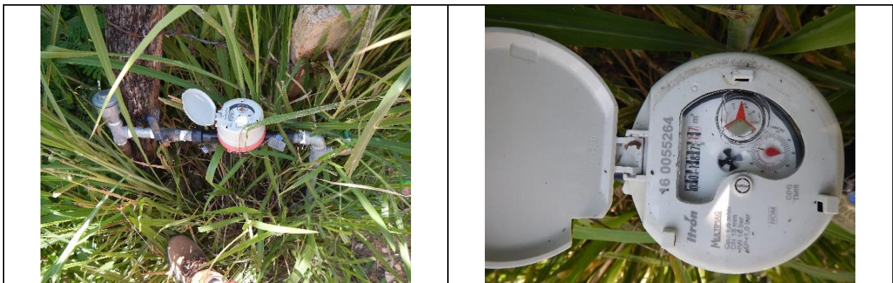
Figura 10. Medidor 160055264, clase C. Predio con toma y detalle de medidor con número de serie. Sin VAF. Localidad de Matzancintla. Lectura del medidor: 187.17 m 3 .
