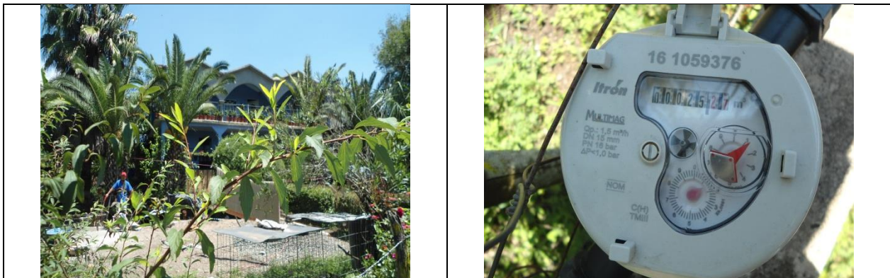
Figura 21. Medidor 161059377, clase C. Toma y detalle de medidor con número de serie. Sin VAF. Calle Colombia S/N, Barrio Cuba, localidad Otates. Lectura del medidor: 20.01 m 3 . El número de medidor corresponde con el número proporcionado por la CEA, sin embargo, se encontró que la marca, modelo y demás características (clase) del medidor no corresponden al registrado en el padrón de usuarios de la CEA.
