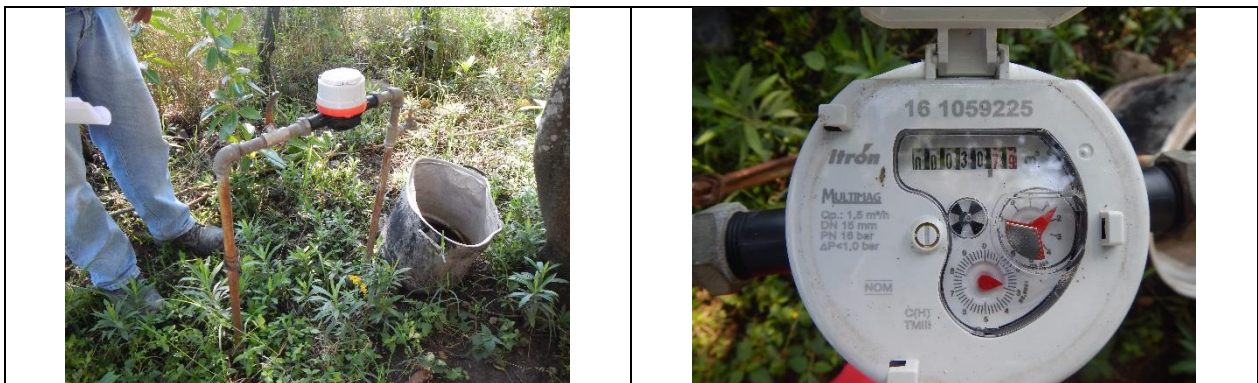
Figura 13. Medidor buscado 161059225, clase C. Predio con toma y detalle de medidor con número de serie. Sin VAF. Localidad Encino Solo. Lectura del medidor: 30.79 m 3 . El número de medidor corresponde con el número proporcionado por la CEA, sin embargo, la marca y modelo de medidor no corresponde al registrado en el padrón de usuarios de la CEA.
