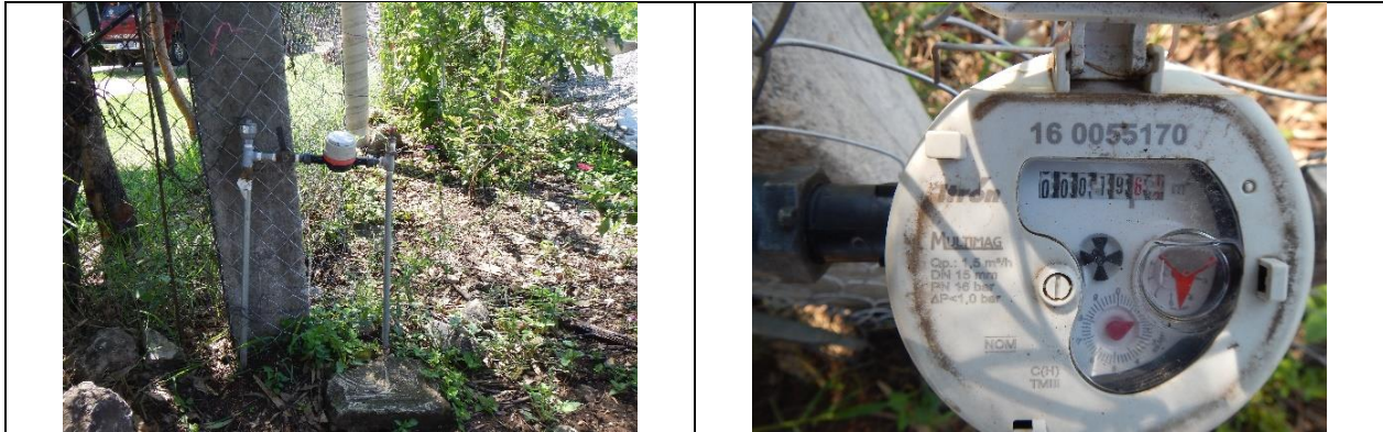
Figura 15. Medidor 160055170, clase C. Predio con toma y detalle de medidor con número de serie. Sin VAF. Localidad La Polvareda. Lectura del medidor: 19.61 m 3 . Se encontró que el modelo de medidor no corresponde al registrado en el padrón de usuarios de la CEA.
