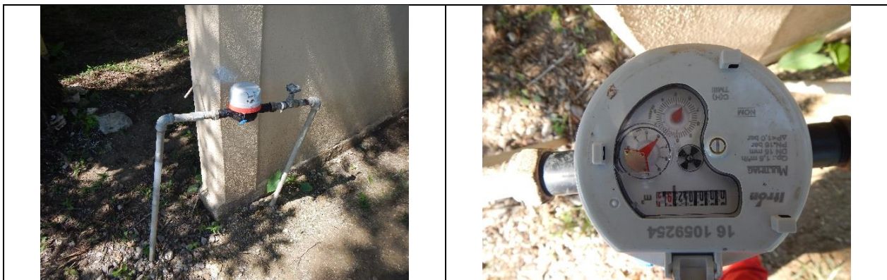
Figura 16. Medidor buscado 161059254, clase C. Predio con toma y detalle de medidor con número de serie. Sin VAF. Localidad La Reforma. Lectura del medidor: 2.92 m 3 . El número de medidor corresponde con el número proporcionado por la CEA, sin embargo, se encontró que la marca, modelo y demás características (clase) del medidor no corresponde al registrado en el padrón de usuarios de la CEA.
