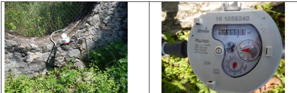
Figura 17. Medidor 161059240, clase C. Sin VAF. Calle Principal S/N, localidad Las Ánimas. Lectura del medidor: 0.5 m 3 . El número de medidor corresponde con el número proporcionado por la CEA, sin
