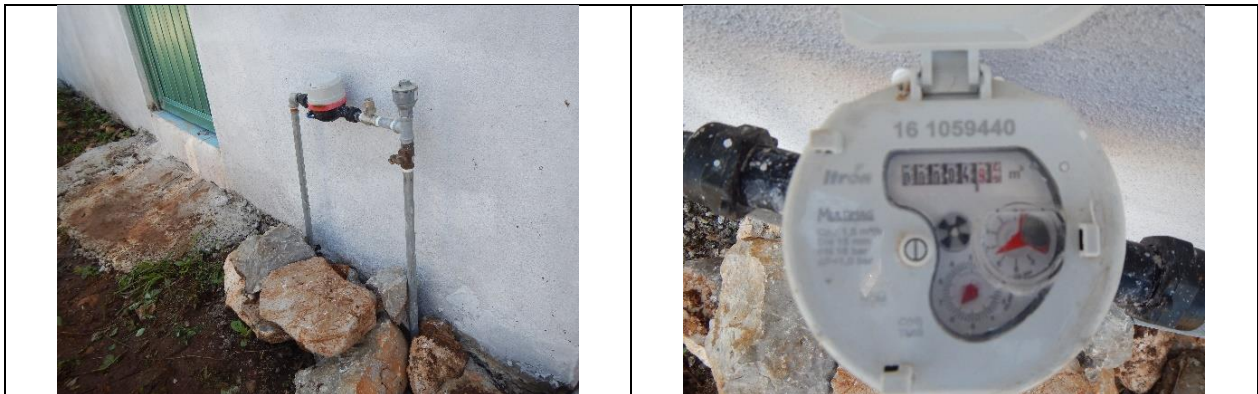
Figura 4. Medidor 161059440, clase C. Con VAF. Barrio Chacatlán. Lectura del medidor: 4.92 m 3 . El número de medidor corresponde con el número proporcionado por la CEA, sin embargo la marca, modelo y características (clase) del medidor no corresponden a las registradas en el padrón de usuarios.
