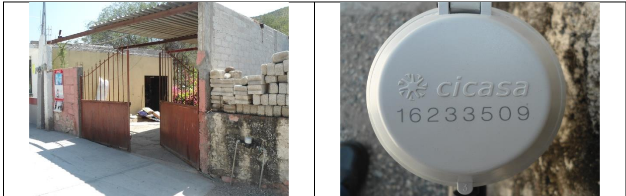
Figura 30. Medidor 16233509, clase B. Predio con toma y detalle de medidor con número de serie. Sin VAF. Comunidad La Colonia. Lectura del medidor: 32.47 m 3 .
