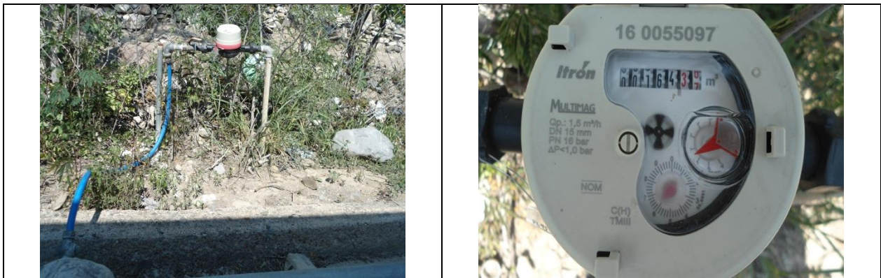
Figura 23. Medidor 160055097, clase C. Toma y detalle de medidor con número de serie. Sin VAF. Comunidad San Lorenzo. Lectura del medidor: 164.35 m 3 .
