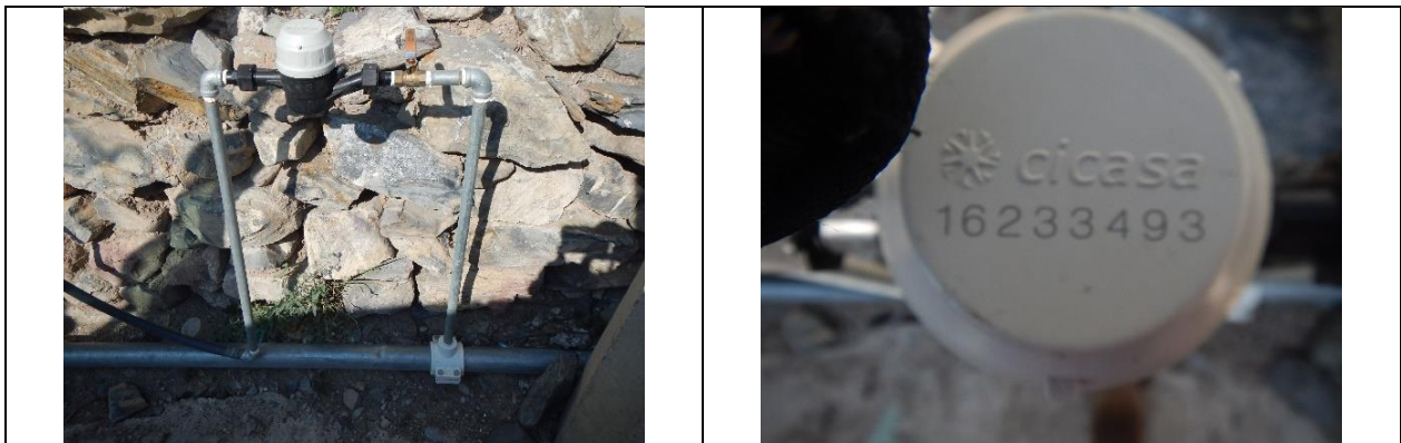
Figura 11. Medidor 16233493, clase B. Toma y detalle de medidor con número de serie. Sin VAF. Comunidad El Álamo. Lectura del medidor: 102.54 m 3 .
