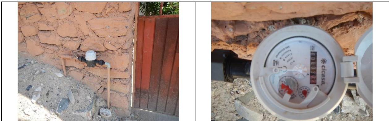
Figura 18. Medidor 16233546, clase B. Toma y detalle de carátula de medidor. Sin VAF. Localidad Peñamiller. Lectura del medidor: 3.02 m 3 .
