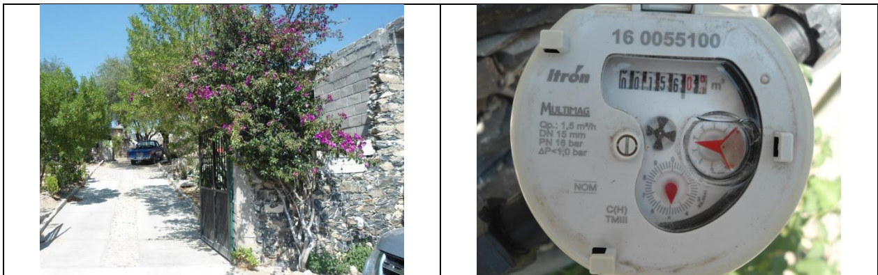
Figura 26. Medidor 160055100, clase C. Predio con toma y detalle de medidor con número de serie. Con VAF. Comunidad La Vega. Lectura del medidor: 156.08 m 3 .
