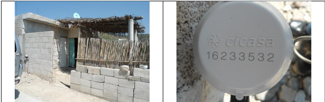
Figura 25. Medidor 16233532, clase B. Predio con toma y detalle de medidor con número de serie. Sin VAF. Comunidad La Vega. Lectura del medidor: 16.64 m 3 .
