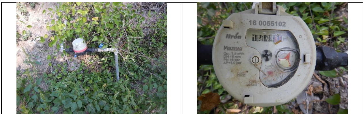
Figura 12. Medidor 160055102, clase C. Toma y detalle de medidor con número de serie. Con VAF. Comunidad El Álamo. Lectura del medidor: 179.6 m 3 .
