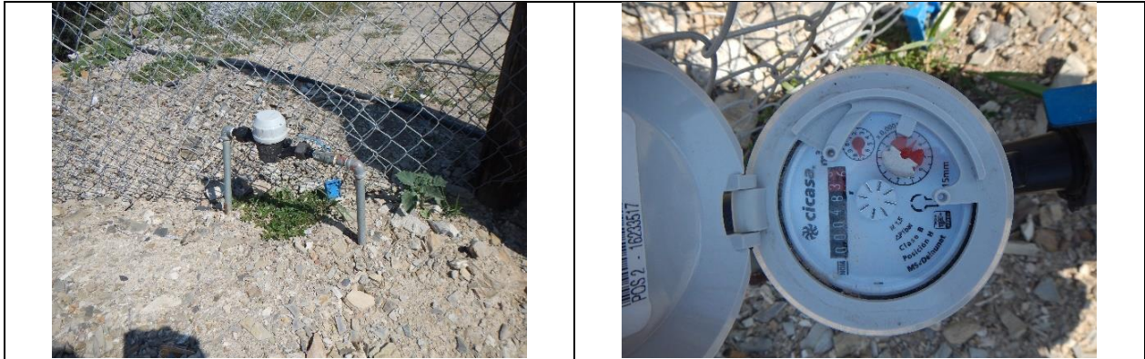
Figura 16. Medidor 16233517, clase B. Toma y detalle de carátula de medidor. Sin VAF. Localidad Peñamiller. Lectura del medidor: 48.32 m 3 .
