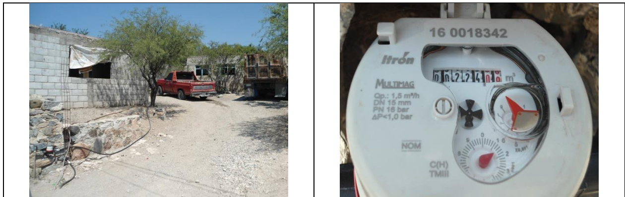
Figura 31. Medidor 160018342, clase C. Predio con toma y detalle de medidor con número de serie. Sin VAF. Comunidad La Estación. Lectura del medidor: 224.08 m 3 .
