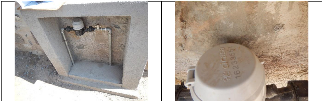
Figura 5. Medidor 16233551, clase B. Toma y detalle de medidor con número de serie. Con VAF. Localidad Peñamiller. Lectura del medidor: 14.42 m 3 .
