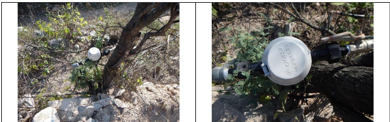
Figura 9. Medidor 16233523, clase B. Toma y detalle de medidor con número de serie. Sin VAF. Comunidad El Álamo. Lectura del medidor: 0.24 m 3 .
