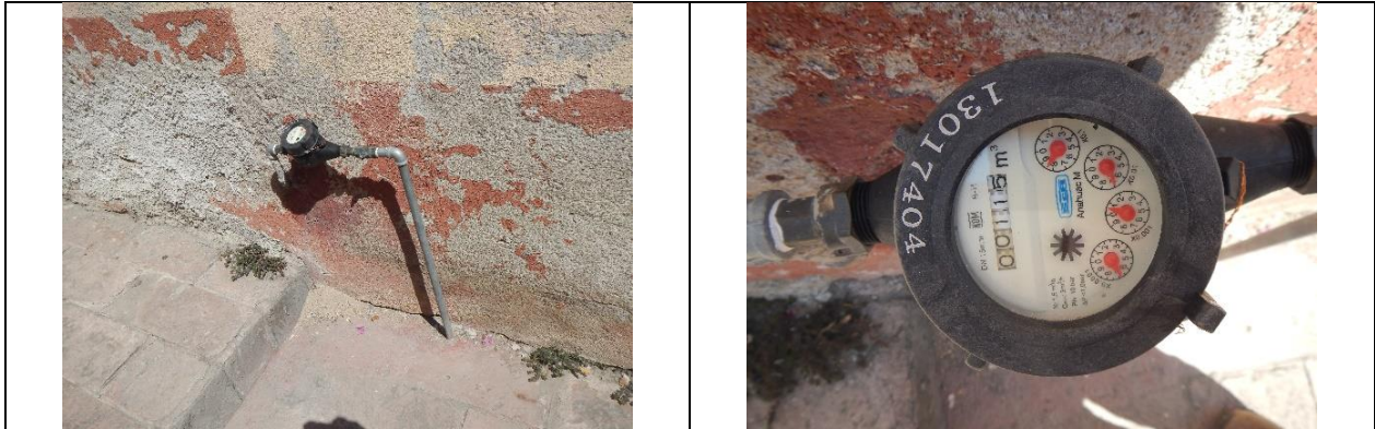
Figura 7. Medidor 13017404, clase B. Toma y detalle de medidor con número de serie. Sin VAF. Localidad Peñamiller. Lectura del medidor: 115 m 3 . Medidor aparentemente no nuevo, se verificará porque no corresponde a las marcas y números de serie adquiridos en el marco del programa (PMCOOA).
