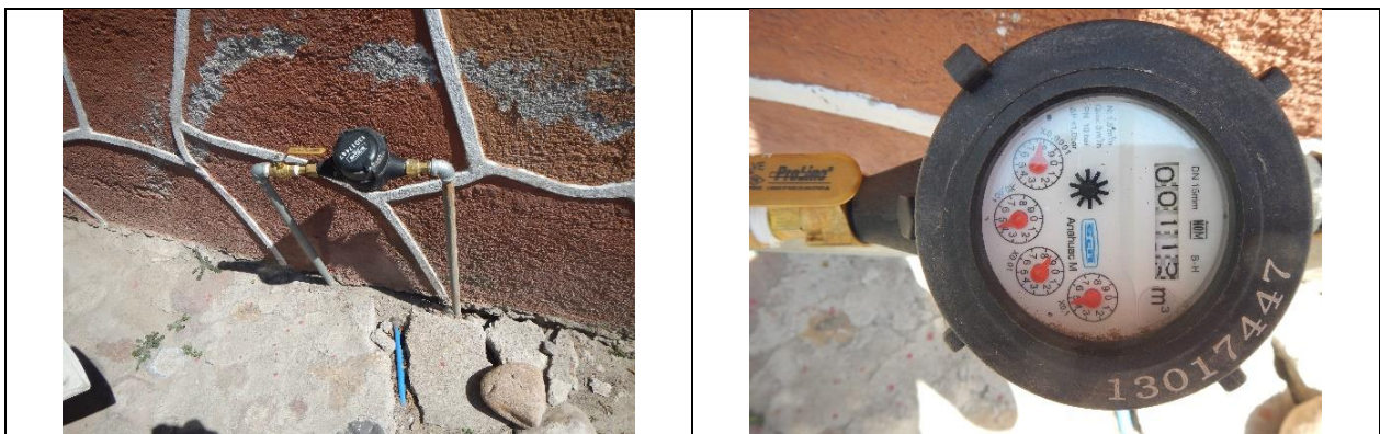
Figura 6. Medidor 13017447, clase B. Toma y detalle de medidor con número de serie. Sin VAF. Localidad Peñamiller. Lectura del medidor: 115 m 3 . Medidor aparentemente no nuevo, se verificará porque no corresponde a las marcas y números de serie adquiridos en el marco del programa (PMCOOA).
