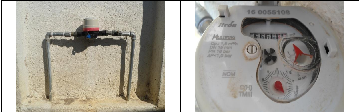
Figura 19. Medidor 160055108, clase C. Toma y detalle de medidor con número de serie. Sin VAF. Comunidad Peña Blanca. Lectura del medidor: 76.66 m 3 .
