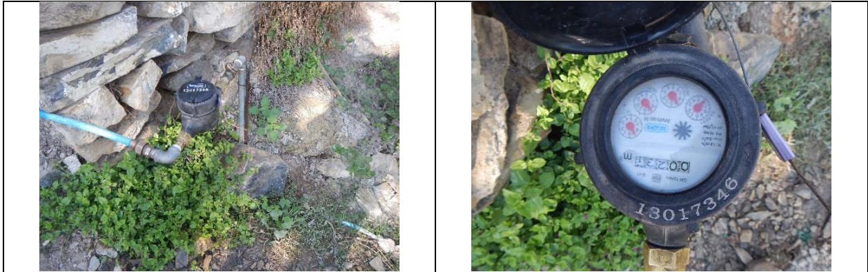
Figura 13. Medidor 13017346, clase B. Toma y detalle de medidor con número de serie. Sin VAF. Comunidad El Álamo. Lectura del medidor: 231 m 3 . Medidor aparentemente no nuevo, se verificará porque no corresponde a las marcas y números de serie adquiridos en el marco del programa (PMCOOA).
