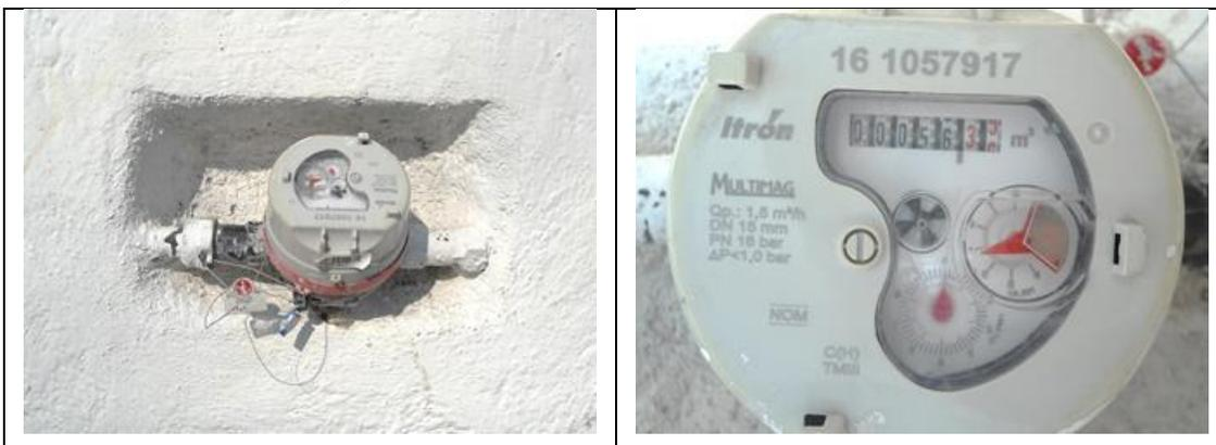
Figura 43. Medidor Itrón, Multimag 161057917, clase C, sin VAF. Detalles de medidor con número de serie. Colonia Centro, Santa Rosa Jáuregui, municipio de Querétaro. Lectura del medidor: 56.35 m<sup>3</sup>. Se encontró que debe corregirse la marca (es Itrón, no Itrón-Actaris) en el padrón de usuarios. El medidor no cuenta ya con tapa para la carátula. No se encontró a ninguna persona en el domicilio.
