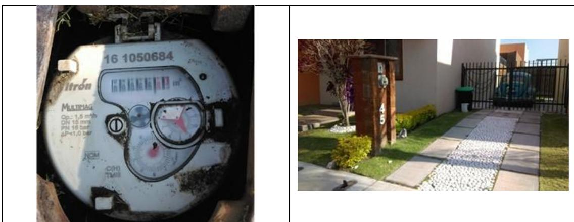
Figura 39. Medidor Itron, Multimag 161050684, clase C, sin VAF. Detalles de medidor con número de serie. Fracc. Puerta Real, municipio de Querétaro. Lectura del medidor: 66.834 m<sup>3</sup>.
