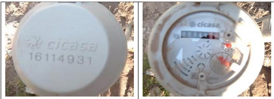
Figura 52. Medidor CICASA, MS Delaunet 16114931, clase B, con VAF1. Detalles de medidor con número de serie. Comunidad El Salitre, municipio de Querétaro. Lectura del medidor: 344.89 m<sup>3</sup>. No se encontró a ninguna persona en el domicilio.
