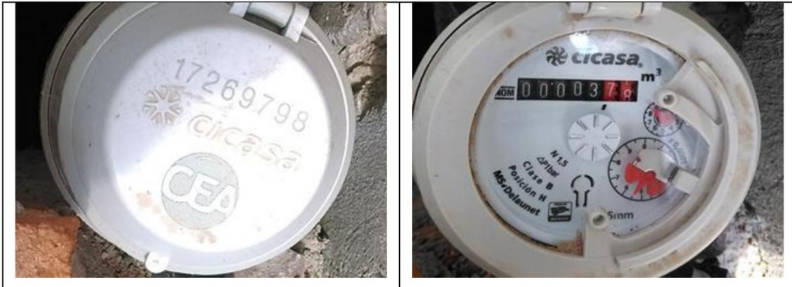
Figura 56. Medidor CICASA, MS Delaunet 17269798, clase C, sin VAF. Detalles de medidor con número de serie. Comunidad La Gotera, municipio de Querétaro. Lectura del medidor: 3.77 m<sup>3</sup>. La calle donde se ubica el predio es Francisco I. Madero, por lo que debe especificarse en el padrón de usuarios. No se encontró a ninguna persona en el domicilio.
