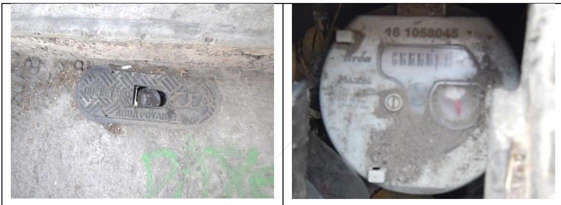
Figura 66. Medidor Itrón, Multimag 161058045, clase C, sin VAF. Registro de toma y detalle de medidor con número de serie. Localidad Jurica, municipio de Querétaro. Lectura del medidor: 0.00 m<sup>3</sup>. Se encontró que debe corregirse el modelo (es Multimag, no Itrón Multimag). El registro se encuentra azolvado y el medidor no ha registrado consumo, por lo que deberá revisarse su funcionamiento, ya que el usuario manifiesta tener suministro de agua.
