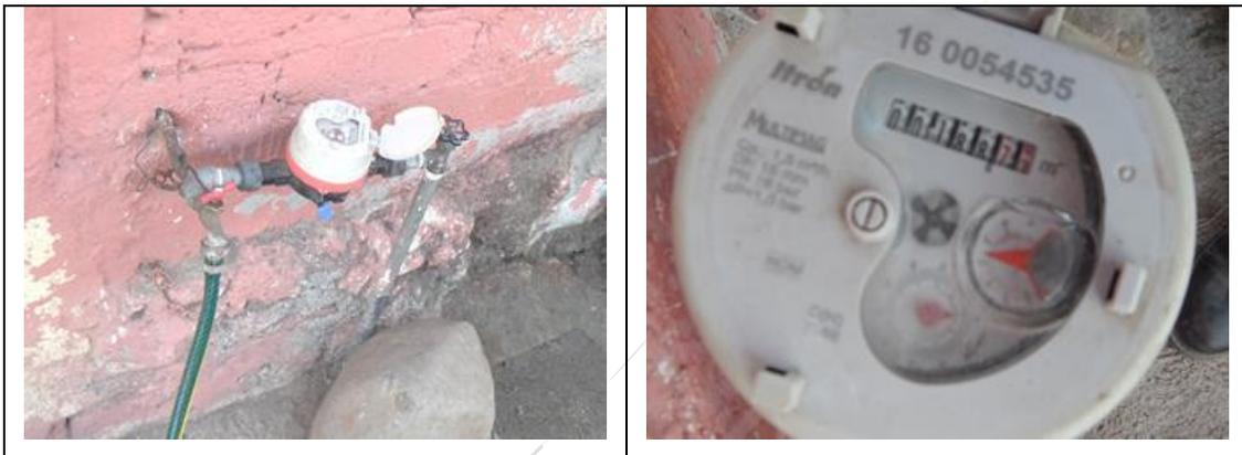
Figura 54. Medidor Itrón, Multimag 160054535, clase B, sin VAF. Cuadro de toma y detalle de medidor con número de serie. Comunidad El Salitre, municipio de Querétaro. Lectura del medidor: 88.76 m<sup>3</sup>. Se encontró que debe corregirse la marca (es Itrón, no Itrón-Actaris) en el padrón de usuarios. Atendió usuaría titular.
