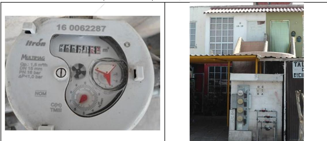
Figura 15. Medidor Itrón, Multimag 160062287, clase C, **con VAF2**. Detalles de medidor con número de serie. Colonia Geoplazas, municipio de Querétaro. Lectura del medidor: 71.65 m<sup>3</sup>. No se encontró al usuario.
