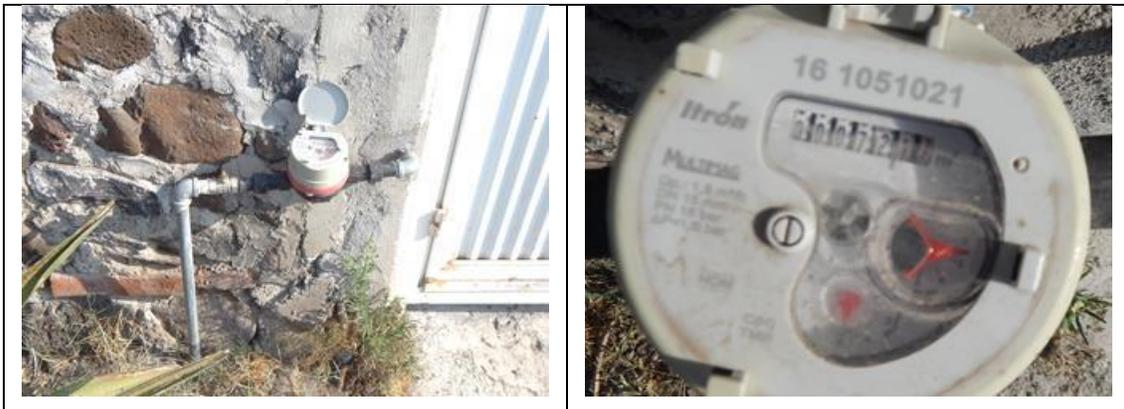
Figura 67. Medidor Itrón, Multimag 161051021, clase C, sin VAF. Cuadro de toma y detalle de medidor con número de serie. Localidad Jurica, municipio de Querétaro. Lectura del medidor: 72.17 m<sup>3</sup>. Atendió usuaria titular.
