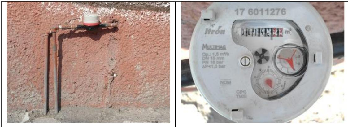
Figura 44. Medidor Itrón, Multimag 176011276, clase C, sin VAF. Cuadro de toma y detalle de medidor con número de serie. Colonia Centro, Santa Rosa Jáuregui, municipio de Querétaro. Lectura del medidor: 144.99 m<sup>3</sup>. Se encontró que debe corregirse la marca (es Itrón, no Itrón-Actaris) en el padrón de usuarios. Atendió nueva propietaria del predio.
