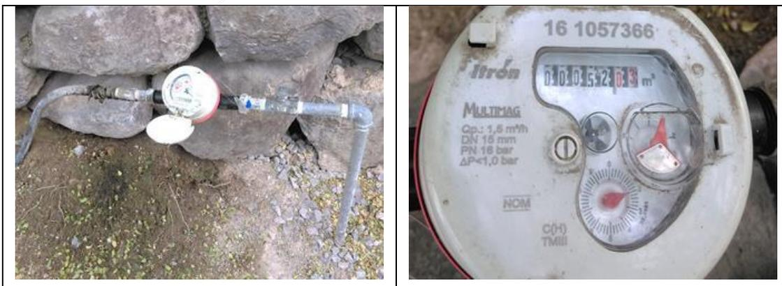
Figura 61. Medidor Itrón, Multimag 161057366, clase C, sin VAF. Cuadro de toma y detalle de medidor con número de serie. Comunidad Pie de Gallo, municipio de Querétaro. Lectura del medidor: 52.03 m<sup>3</sup>. Se encontró que debe corregirse la marca (es Itrón, no Itrón-Actaris) en el padrón de usuarios. El medidor se ubica dentro del predio. No se encontró a ninguna persona en el domicilio.
