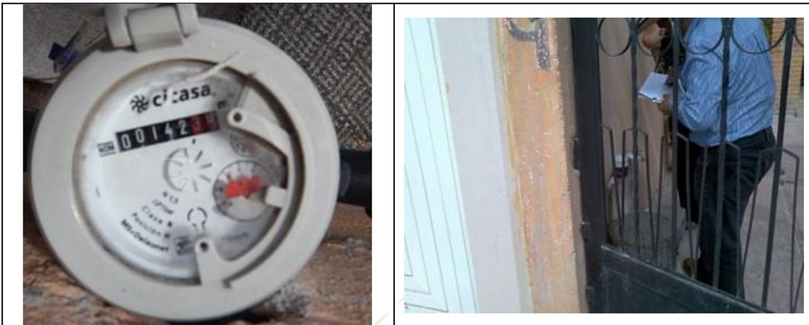
Figura 8. Medidor CICASA, MS Delaunet 16363506, clase B, sin VAF. Detalles de medidor con número de serie. Colonia Colinas de Cimatario, municipio de Querétaro. Lectura del medidor: 142.305 m<sup>3</sup>. El medidor está instalado dentro del domicilio.
