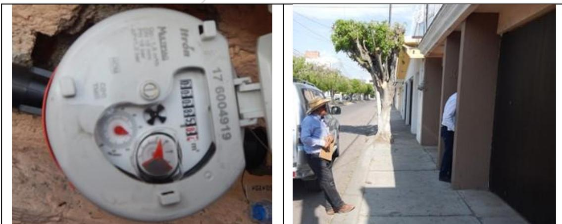
Figura 9. Medidor Itrón, Multimag 176004919, clase C, sin VAF. Detalles de medidor con número de serie. Colonia Colinas de Cimatario, municipio de Querétaro. Lectura del medidor: 85.836 m<sup>3</sup>. El medidor está instalado dentro del domicilio.
