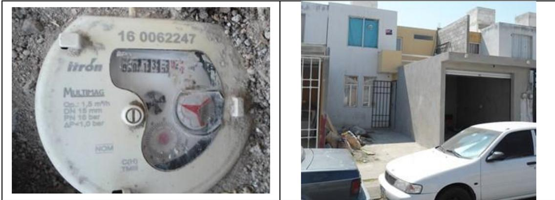
Figura 40. Medidor Itrón, Multimag 160062247, clase C, con VAF2. Detalles de medidor con número de serie. Fracc. San Miguel Carrillo, municipio de Querétaro. Lectura del medidor: 135.08 m<sup>3</sup>. El medidor está instalado en caja de piso y no tiene su tapa y esta azolvada. No se encontró al usuario.
