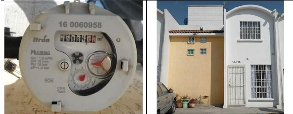
Figura 16. Medidor Itron, Multimag 160060958, clase C, con VAF2. Detalles de medidor con número de serie. Colonia Las Azucenas, municipio de Querétaro. Lectura del medidor: 84.63 m<sup>3</sup>. El medidor no tiene tapa. El usuario no se encontró.
