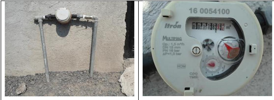
Figura 41. Medidor Itrón, Multimag 160054100, clase C, sin VAF. Cuadro de toma y detalle de medidor con número de serie. Colonia Arboladas Montenegro, Santa Rosa Jáuregui, municipio de Querétaro. Lectura del medidor: 118.95 m<sup>3</sup>. Se encontró que debe corregirse la marca (es Itrón, no Itrón-Actaris) en el padrón de usuarios. No se encontró a ninguna persona en el domicilio.
