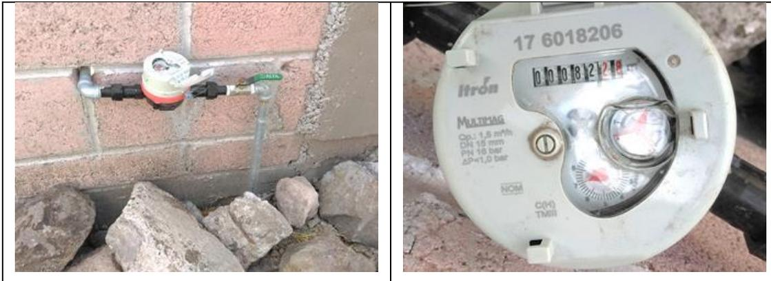
Figura 62. Medidor Itrón, Multimag 176018206, clase C, sin VAF. Cuadro de toma y detalle de medidor con número de serie. Comunidad Pie de Gallo, municipio de Querétaro. Lectura del medidor: 82.28 m<sup>3</sup>. Se encontró que debe corregirse la marca (es Itrón, no Itrón-Actaris) en el padrón de usuarios. Atendió familiar del usuario titular.
