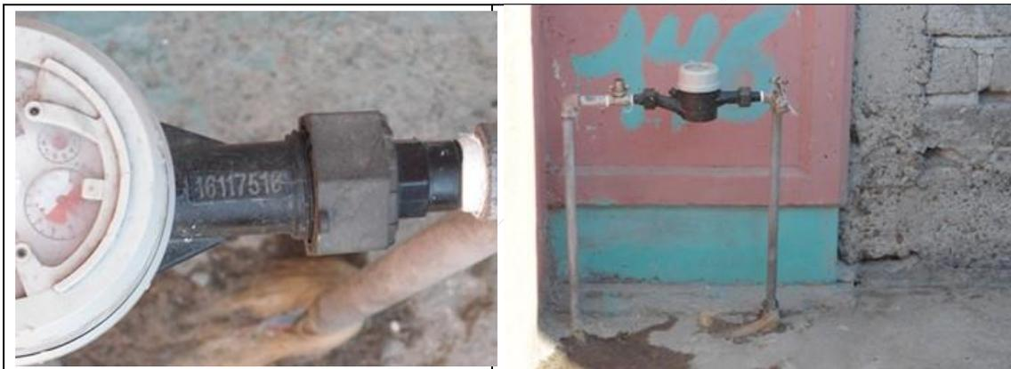
Figura 17. Medidor CICASA, MS Delaunet 16117516, clase B, con VAF1. Detalles de medidor con número de serie. Colonia Las Azucenas, municipio de Querétaro. Lectura del medidor: 121.8 m<sup>3</sup>. El medidor no tiene tapa, el número de serie está en los conectores. El usuario no se encontró.
