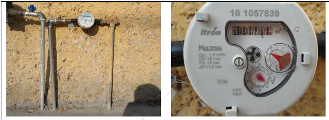
Figura 45. Medidor Itrón, Multimag 161057839, clase C, sin VAF. Cuadro de toma y detalle de medidor con número de serie. Colonia Centro, Santa Rosa Jáuregui, municipio de Querétaro. Lectura del medidor: 371.26 m<sup>3</sup>. Se encontró que debe corregirse la marca (es Itrón, no Itrón-Actaris) en el padrón de usuarios. El medidor no cuenta ya con tapa para la carátula. Atendió usuaria titular.
