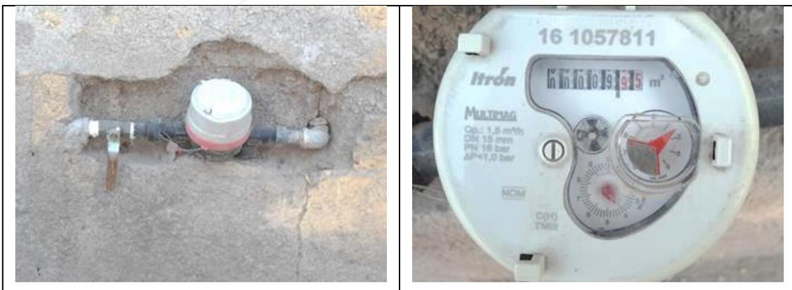
Figura 49. Medidor Itrón, Multimag 161057811, clase C, sin VAF. Cuadro de toma y detalle de medidor con número de serie. Colonia Las Rosas, Santa Rosa Jáuregui, municipio de Querétaro. Lectura del medidor: 9.95 m<sup>3</sup>. Se encontró que debe corregirse la marca (es Itrón, no Itrón-Actaris) en el padrón de usuarios. No se encontró a ninguna persona en el domicilio.
