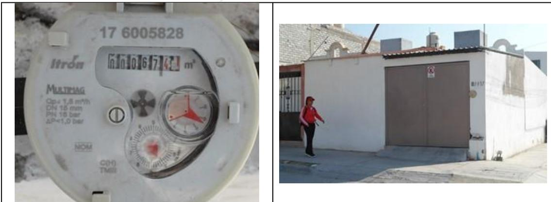
Figura 12. Medidor Itron, Multimag 176005828, clase C, sin VAF. Detalles de medidor con número de serie. Colonia Colinas del Poniente, municipio de Querétaro. Lectura del medidor: 67.41 m<sup>3</sup>.
