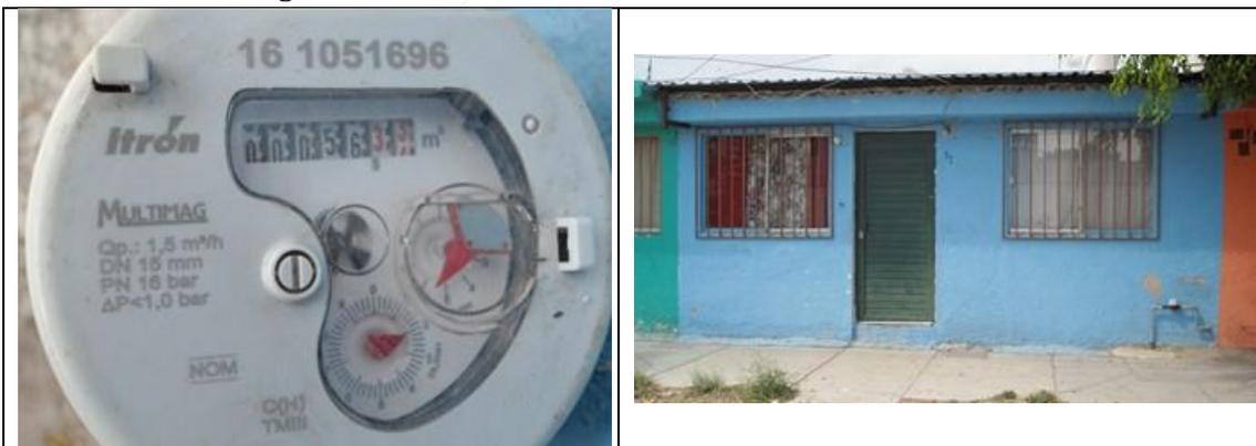
Figura 3. Medidor Itrón, Multimag 161051696, clase C, sin VAF. Detalles de medidor con número de serie. Colonia Carrillo Puerto, municipio de Querétaro. Lectura del medidor: 56.32 m<sup>3</sup>.
