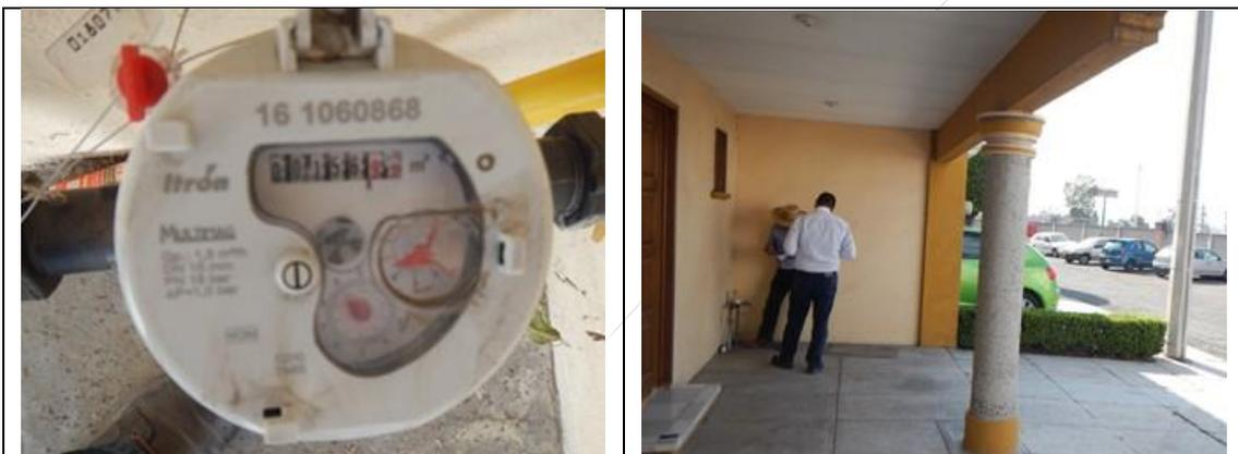
Figura 29. Medidor Itrón, Multimag 161060868, clase C, sin VAF. Detalles de medidor con número de serie. Colonia Quintas Balastrada, municipio de Querétaro. Lectura del medidor: 156.917 m<sup>3</sup>.
