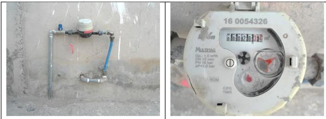
Figura 64. Medidor Itrón, Multimag 160054326, clase C, con VAF1. Cuadro de toma y detalle de medidor con número de serie. Comunidad Tlacote el Bajo, municipio de Querétaro. Lectura del medidor: 20.32 m<sup>3</sup>. Se encontró que debe corregirse la marca (es Itrón, no Itrón-Actaris) en el padrón de usuarios. El medidor está roto. No se encontró a ninguna persona en el domicilio.
