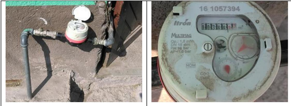
Figura 50. Medidor Itrón, Multimag 161057394, clase C, sin VAF. Cuadro de toma y detalle de medidor con número de serie. Comunidad Buenavista, municipio de Querétaro. Lectura del medidor: 366.85 m<sup>3</sup>. Se encontró que debe corregirse la marca (es Itrón, no Itrón-Actaris) en el padrón de usuarios. Atendió familiar del usuario titular.
