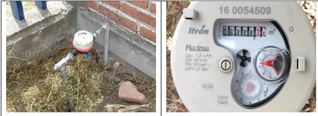
Figura 59. Medidor Itrón, Multimag 160054509, clase C, sin VAF. Cuadro de toma y detalle de medidor con número de serie. Comunidad La Versolilla, municipio de Querétaro. Lectura del medidor: 6,888.34 m<sup>3</sup>. Se encontró que debe corregirse la marca (es Itrón, no Itrón-Actaris) en el padrón de usuarios. El medidor se ubica dentro del predio y no cuenta ya con tapa para la carátula. No se encontró a ninguna persona en el domicilio.
