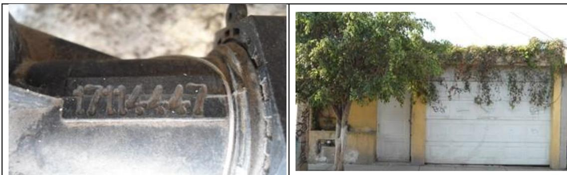
Figura 18. Medidor CICASA, MS Delaunet 17114447, clase B, sin VAF. Detalles de medidor con número de serie. Colonia Las Azucenas, municipio de Querétaro. Lectura del medidor: 36.90 m<sup>3</sup>. El medidor no tiene grabado el número de serie en la tapa y la etiqueta que debe ir en la misma
