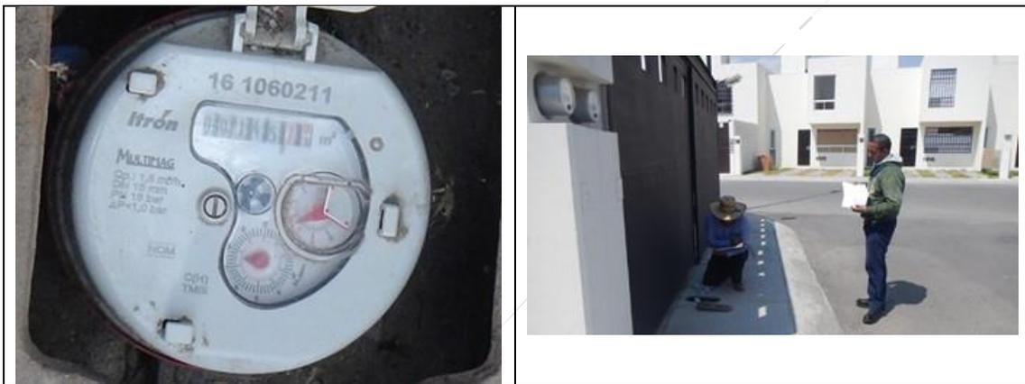
Figura 38. Medidor Itron, Multimag 161060211 clase C, sin VAF. Detalles de medidor con número de serie. Fracc. Misión La Joya, municipio de Querétaro. Lectura del medidor: 1.45.767 m<sup>3</sup>. El medidor está instalado sobre la banqueta. La carátula presenta algunas ralladuras.
