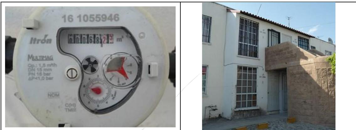
Figura 14. Medidor Itrón, Multimag 161055946, clase C, **con VAF1**. Detalles de medidor con número de serie. Colonia Geoplazas, municipio de Querétaro. Lectura del medidor: 68.25 m<sup>3</sup>.
