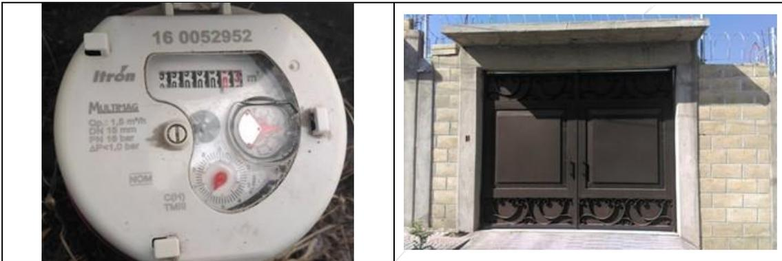
Figura 2. Medidor Itrón, Multimag 160052952, clase C, sin VAF. Detalles de medidor con número de serie. Colonia Campestre Italiana, municipio de Querétaro. Lectura del medidor: 0.032 m<sup>3</sup>. El medidor está instalado sobre la banqueta y no tiene la tapa metálica por lo cual fácilmente le entra agua. La obra está aún en construcción.
