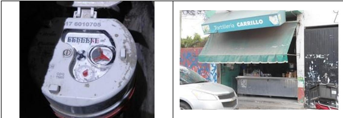
Figura 4. Medidor Itrón, Multimag 176010705, clase C, **con VAF1**. Detalles de medidor con número de serie. Colonia Carrillo Puerto, municipio de Querétaro. Lectura del medidor: 335.43 m<sup>3</sup>. El tipo de usuario es comercial.
