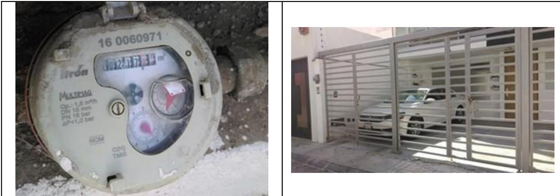
Figura 25. Medidor Itrón, Multimag 160060971, clase C, **con VAF1**. Detalles de medidor con número de serie. Colonia Milenio III, municipio de Querétaro. Lectura del medidor: 217.875 m<sup>3</sup>. El medidor está instalado en el interior del predio, el usuario no se encontraba.
