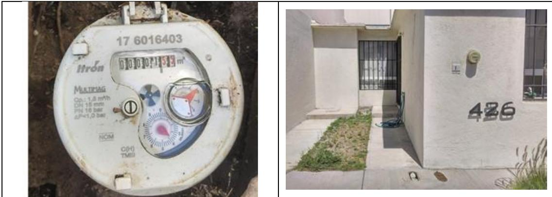
Figura 37. Medidor Itron, Multimag 176016403, clase C, sin VAF. Detalles de medidor con número de serie. Fracc. Misión de Bucareli, municipio de Querétaro. Lectura del medidor: 1.551 m<sup>3</sup>. El medidor está instalado sobre la banqueta. El usuario no estaba en el domicilio.
