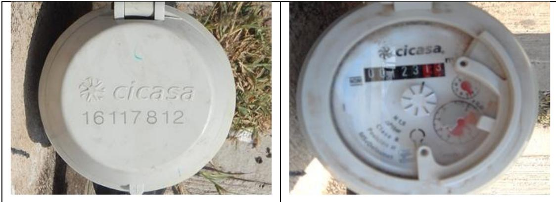
Figura 53. Medidor CICASA, MS Delaunet 16117812, clase B, sin VAF. Detalles de medidor con número de serie. Comunidad El Salitre, municipio de Querétaro. Lectura del medidor: 123.13 m<sup>3</sup>. No se encontró a ninguna persona en el domicilio.
