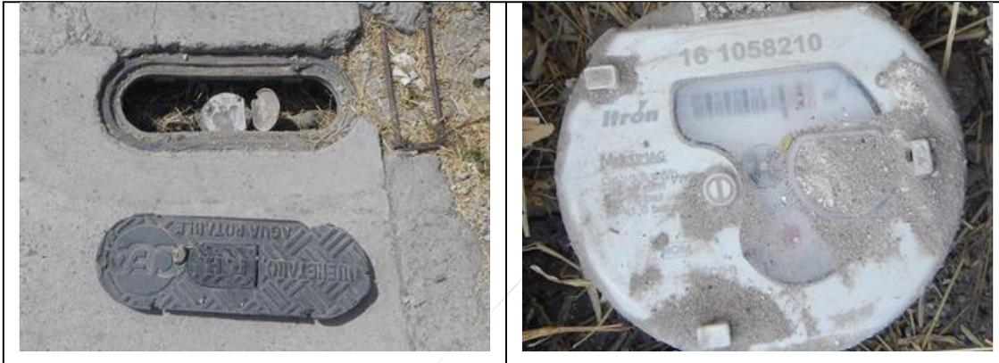
Figura 69. Medidor Itrón, Multimag 161058210, clase C, sin VAF. Registro de toma y detalle de medidor con número de serie. Localidad San José El Alto, municipio de Querétaro. Lectura del medidor: 2.57 m<sup>3</sup>. Se encontró que debe corregirse el modelo (es Multimag, no Itrón Multimag), en el padrón de usuarios. El registro se encuentra azolvado. No se encontró a ninguna persona en el domicilio.
