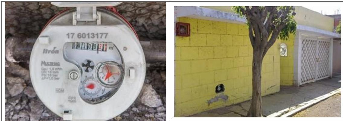
Figura 32. Medidor Itron, Multimag 176013177, clase C, sin VAF. Detalles de medidor con número de serie. Colonia San Pedrito Peñuelas, municipio de Querétaro. Lectura del medidor: 108.366 m<sup>3</sup>. El usuario manifiesta que el recibo no le ha llegado en los 2 últimos meses.
