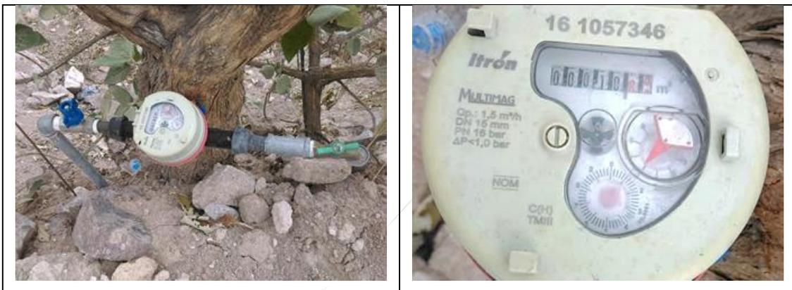
Figura 57. Medidor Itrón, Multimag 161057346, clase C, sin VAF. Cuadro de toma y detalle de medidor con número de serie. Comunidad La Gotera, municipio de Querétaro. Lectura del medidor: 10.88 m<sup>3</sup>. Se encontró que debe corregirse la marca (es Itrón, no Itrón-Actaris) en el padrón de usuarios. El medidor no cuenta ya con tapa para la carátula. No se encontró a ninguna persona en el domicilio.
