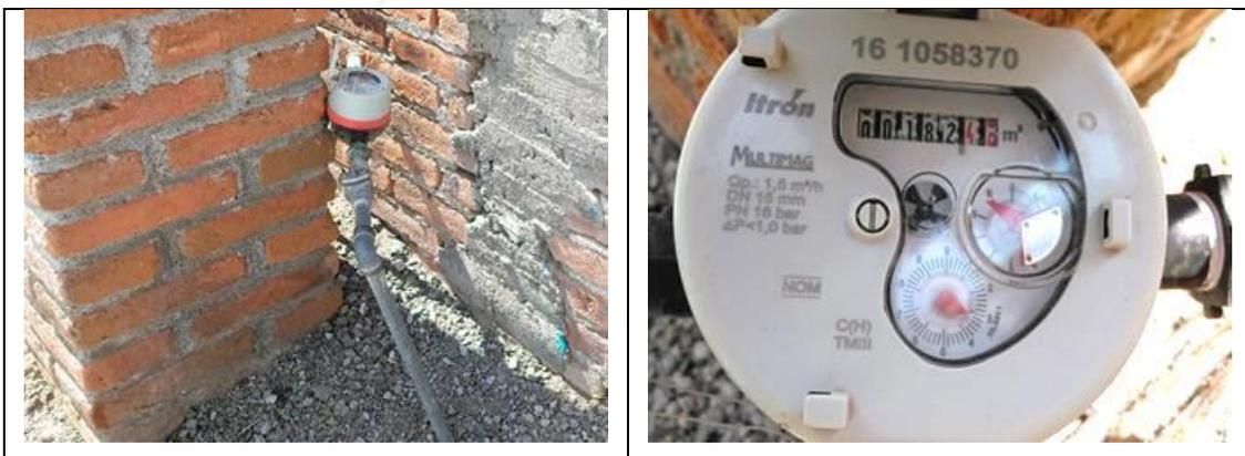
Figura 55. Medidor Itrón, Multimag 161058370, clase C, sin VAF. Cuadro de toma y detalle de medidor con número de serie. Comunidad La Cañada, municipio de Querétaro. Lectura del medidor: 182.48 m<sup>3</sup>. Se encontró que debe corregirse la marca (es Itrón, no Itrón-Actaris) en el padrón de usuarios. No se encontró a ninguna persona en el domicilio.
