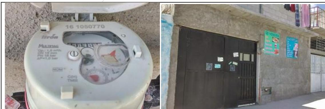
Figura 6. Medidor Itrón, Multimag 161050770, clase C, **con VAF1**. Detalles de medidor con número de serie. Colonia Colinas de San Pablo, municipio de Querétaro. Lectura del medidor: 141.311 m<sup>3</sup>. El usuario no estaba en el domicilio
