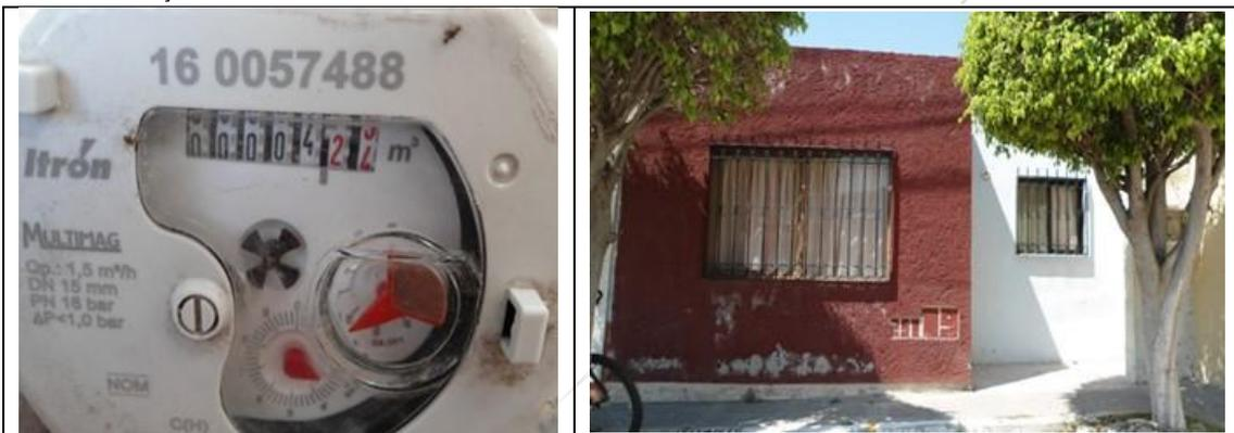
Figura 23. Medidor Itrón, Multimag 160057488, clase C, sin VAF. Detalles de medidor con número de serie. Colonia Lomas de San Pedrito, municipio de Querétaro. Lectura del medidor: 4.23 m<sup>3</sup>. El usuario no se encontraba.
