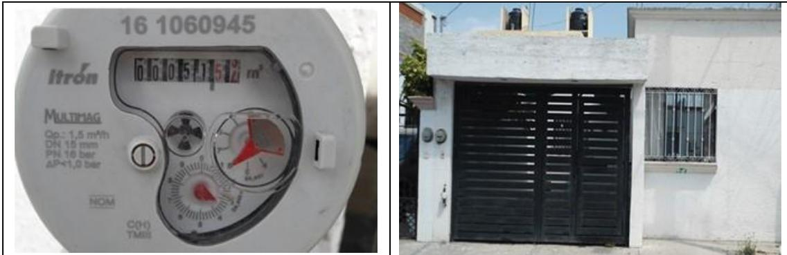
Figura 19. Medidor Itrón, Multimag 161060945, clase C, sin VAF. Detalles de medidor con número de serie. Colonia Las Teresas, municipio de Querétaro. Lectura del medidor: 51.53 m<sup>3</sup>. El medidor está instalado de manera vertical.
