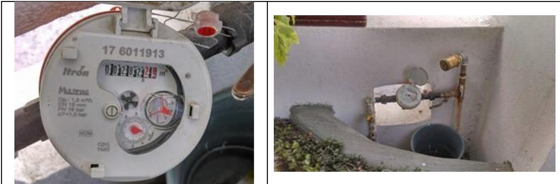
Figura 34. Medidor Itrón, Multimag 176011913 clase C, sin VAF. Detalles de medidor con número de serie. Colonia San Pedrito Peñuelas, municipio de Querétaro. Lectura del medidor: 282.263 m<sup>3</sup>. El medidor está en el interior del predio y el usuario no permitió tomar una foto de la fachada de la casa.
