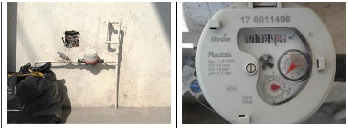
Figura 42. Medidor Itrón, Multimag 176011456, clase C, sin VAF. Cuadro de toma y detalle de medidor con número de serie. Colonia Benito Juárez, Santa Rosa Jáuregui, municipio de Querétaro. Lectura del medidor: 54.51 m<sup>3</sup>. Se encontró que debe corregirse la marca (es Itrón, no Itrón-Actaris) en el padrón de usuarios. No se encontró a ninguna persona en el domicilio.
