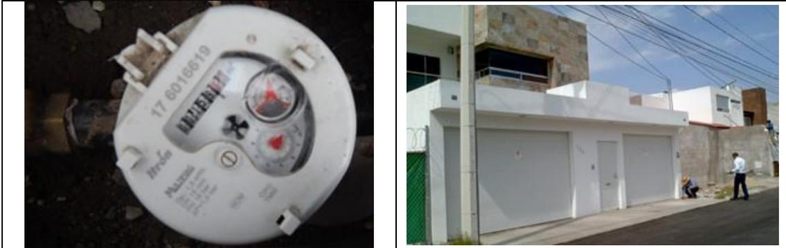
Figura 7. Medidor Itrón, Multimag 176016619, clase C, sin VAF. Detalles de medidor con número de serie. Colonia Colinas de Cimatario, municipio de Querétaro. Lectura del medidor: 159.601 m<sup>3</sup>. El medidor está instalado sobre la banqueta y tiene desprendida su tapa.
