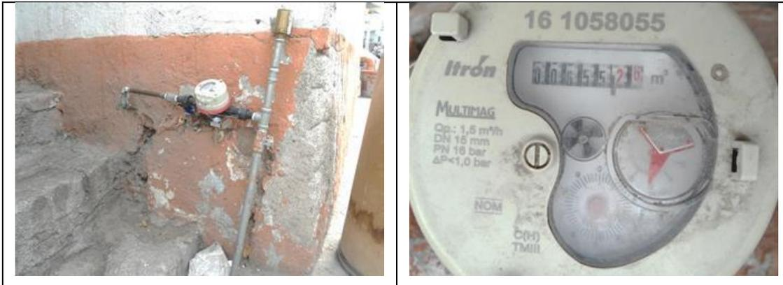
Figura 68. Medidor Itrón, Multimag 161058055, clase C. Cuadro de toma y detalle de medidor con número de serie. Localidad Juriquilla, municipio de Querétaro. Lectura del medidor: 655.24 m<sup>3</sup>. Se encontró que debe corregirse el modelo (es Multimag, no Itrón Multimag). El medidor no cuenta ya con tapa para la carátula. Debe registrarse el número de predio (es 6) en el padrón de usuarios. Atendió familiar del usuario titular.
