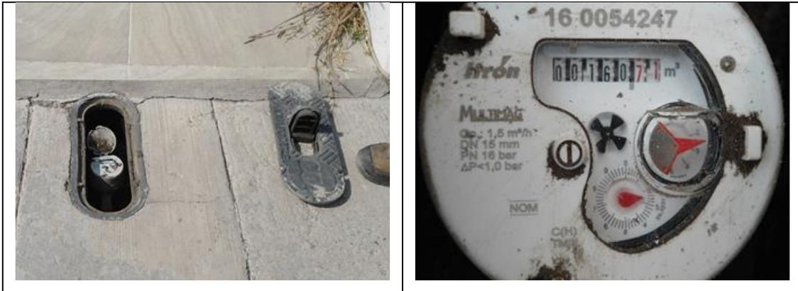
Figura 65. Medidor Itrón, Multimag 160054247, clase C, con VAF2. Registro de toma y detalle de medidor con número de serie. Fraccionamiento residencial Caletto, municipio de Querétaro. Lectura del medidor: 160.71 m<sup>3</sup>. Se encontró que debe corregirse la marca (es Itrón, no Itrón-Actaris) en el padrón de usuarios. No se encontró a ninguna persona en el domicilio.
