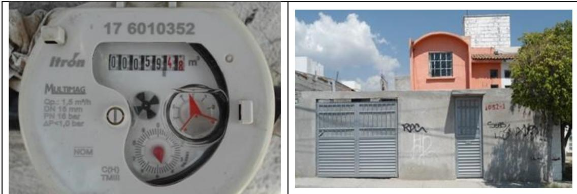
Figura 31. Medidor Itron, Multimag 176010352, clase C, **con VAF1**. Detalles de medidor con número de serie. Colonia San Pedrito Los Arcos, municipio de Querétaro. Lectura del medidor: 59.47 m<sup>3</sup>. El usuario no se encontró en el domicilio.
