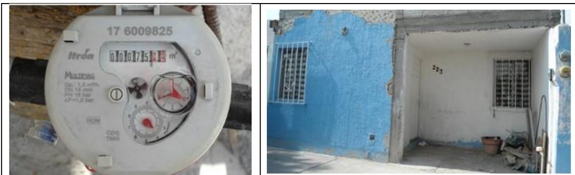
Figura 30. Medidor Itrón, Multimag 176009825 clase C, **con VAF1**. Detalles de medidor con número de serie. Colonia Rocío II, municipio de Querétaro. Lectura del medidor: 75.06 m<sup>3</sup>.
