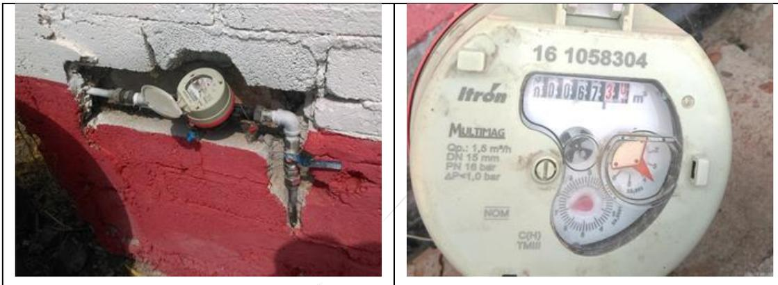
Figura 60. Medidor Itrón, Multimag 161058304, clase C, sin VAF. Cuadro de toma y detalle de medidor con número de serie. Comunidad Loma del Chino, municipio de Querétaro. Lectura del medidor: 67.30 m<sup>3</sup>. Se encontró que debe corregirse la marca (es Itrón, no Itrón-Actaris) en el padrón de usuarios. No se encontró a ninguna persona en el domicilio.
