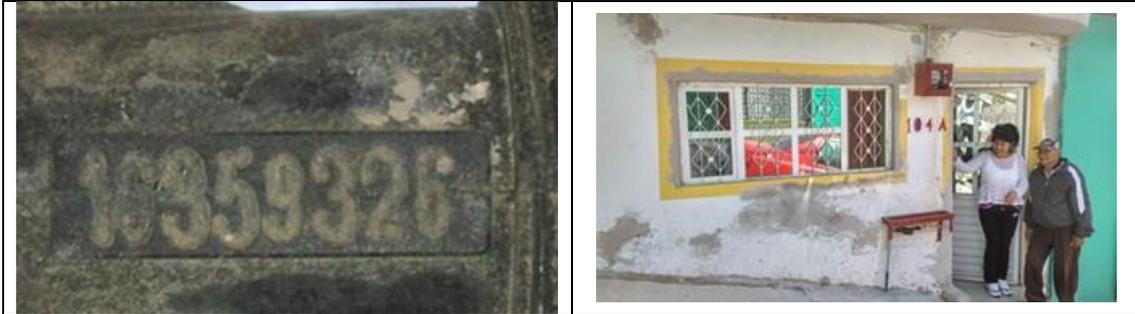
Figura 1. Medidor CICASA, MS Delaunet 16359326 clase B, sin VAF. Detalles de medidor con número de serie. Colonia Bolaños, municipio de Querétaro. Lectura del medidor: 338.430 m<sup>3</sup>. El medidor no tiene grabado el número de serie en la tapa y la etiqueta que debe ir en la misma no está, el número de serie está en los conectores. El usuario manifiesta que cuando no hay agua las agujas del medidor giran.
