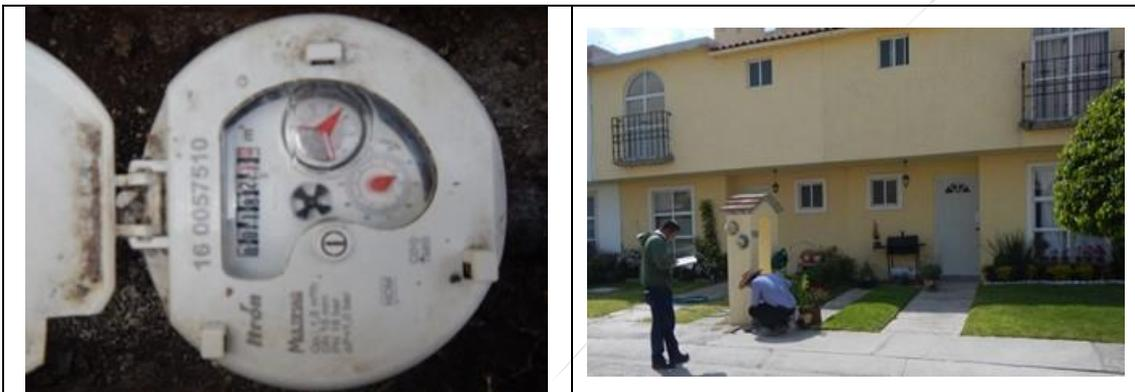
Figura 35. Medidor Itrón, Multimag 160057510 clase C, sin VAF. Detalles de medidor con número de serie. Colonia Valle Real Residencial, municipio de Querétaro. Lectura del medidor: 182.164 m<sup>3</sup>. El medidor está instalado sobre la banqueta.
