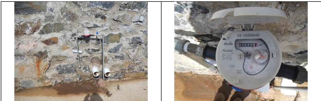
Figura 12. Medidor 161059640, clase C. Toma y detalle de medidor con número de serie. Con VAF. Comunidad de San Antonio, en el municipio de San Joaquín. Lectura del medidor: 0.06 m<sup>3</sup>.
