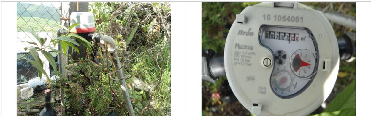
Figura 25. Medidor 161054051, clase C. Toma y detalle de medidor con número de serie. Sin VAF. Comunidad Apartadero. Lectura del medidor: 201.38 m<sup>3</sup>.
