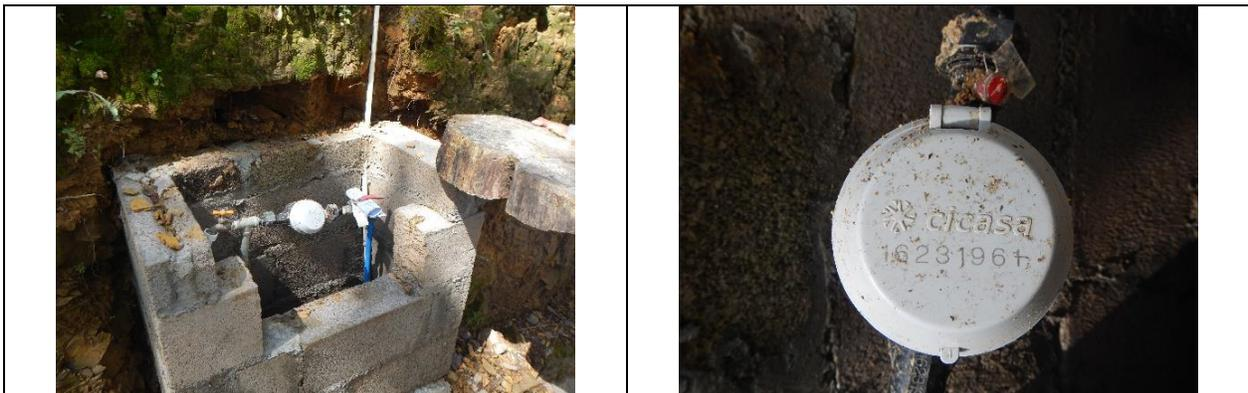
Figura 9. Medidor 16231961, clase B. Toma y detalle de medidor con número de serie. Sin VAF. Comunidad Agua de Venado. Lectura del medidor: 13.19 m<sup>3</sup>.
