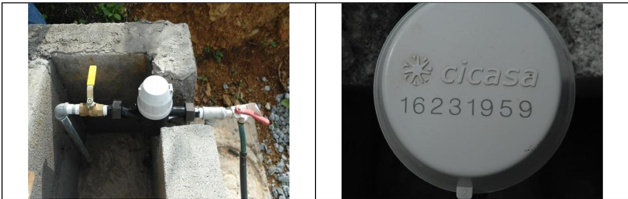
Figura 27. Medidor 16231959, clase B. Toma y detalle de medidor con número de serie. Sin VAF. Comunidad San José Quita Sueño. Lectura del medidor: 14.03 m<sup>3</sup>.
