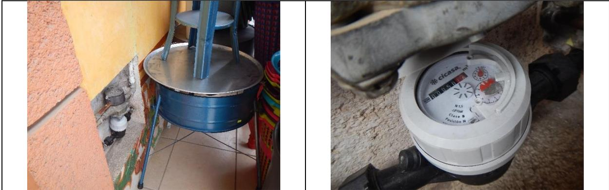
Figura 17. Medidor 16231923, clase B. Toma y detalle de carátula de medidor. Sin VAF. Localidad San Joaquín. Lectura del medidor: 50.16 m<sup>3</sup>.
