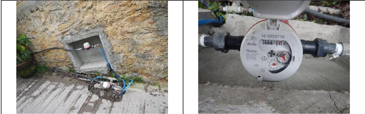
Figura 5. Medidor 160025716, clase C. Toma y detalle de medidor con número de serie. Sin VAF. Localidad San Joaquín. Lectura del medidor: 61.91 m<sup>3</sup>.
