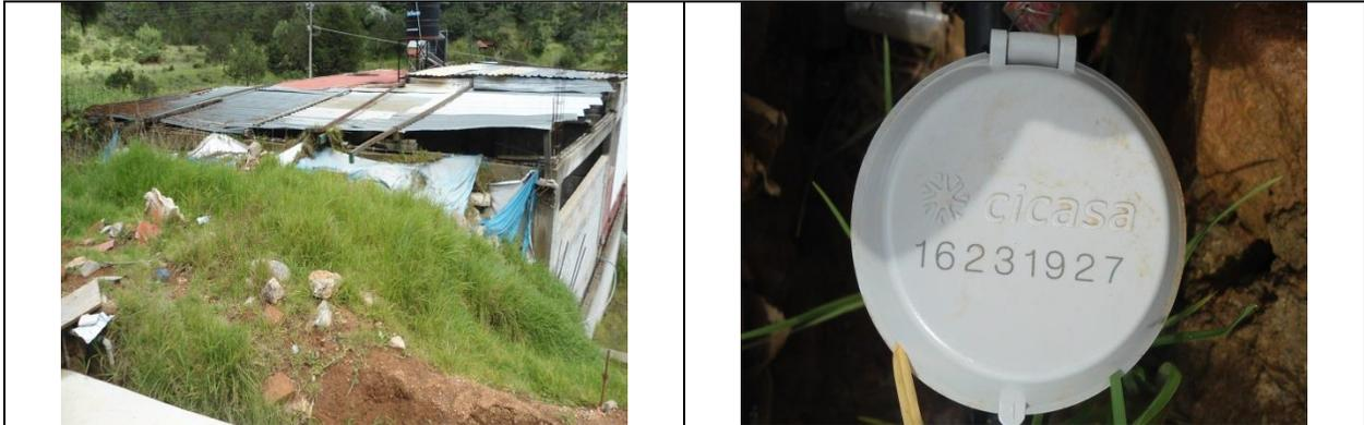
Figura 20. Medidor 16231927, clase B. Predio con toma y detalle de medidor con número de serie. Sin VAF. Comunidad Los Herrera. Lectura del medidor: 33.76 m<sup>3</sup>.
