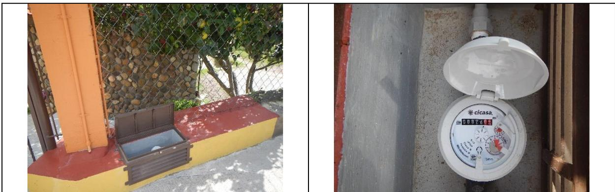
Figura 16. Medidor 16231932, clase B. Predio con toma y detalle de carátula de medidor. Con VAF. Localidad San Joaquín. Lectura del medidor: 26.02 m<sup>3</sup>.
