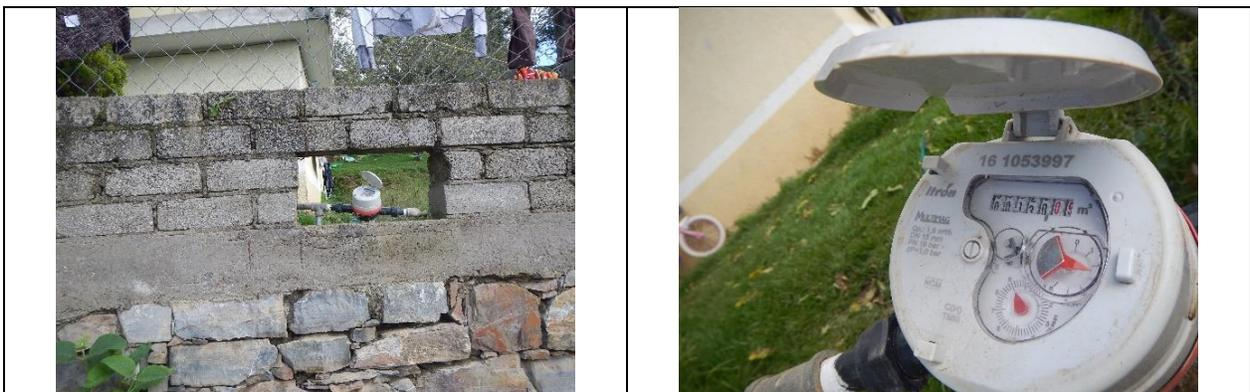
Figura 13. Medidor 161053997, clase C. Predio con toma y detalle de medidor con número de serie. Sin VAF. Comunidad La Loma. Lectura del medidor: 130.09 m<sup>3</sup>.
