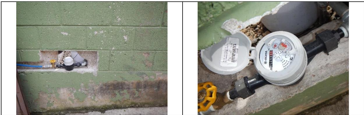
Figura 18. Medidor 16231958, clase B. Toma y detalle de carátula de medidor. Sin VAF. Localidad San Joaquín. Lectura del medidor: 46.26 m<sup>3</sup>.
