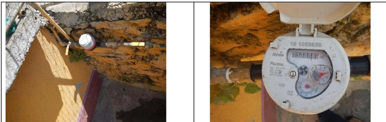
Figura 10. Medidor 161059658, clase C. Toma y detalle de medidor con número de serie. Sin VAF. Comunidad San Cristóbal. Lectura del medidor: 339.44 m<sup>3</sup>.
