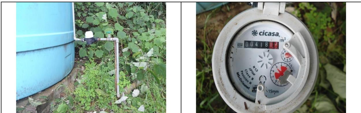
Figura 22. Medidor 16231969, clase B. Toma y detalle de carátula de medidor. Sin VAF. Comunidad Santa Ana. Lectura del medidor: 418.13 m<sup>3</sup>.
