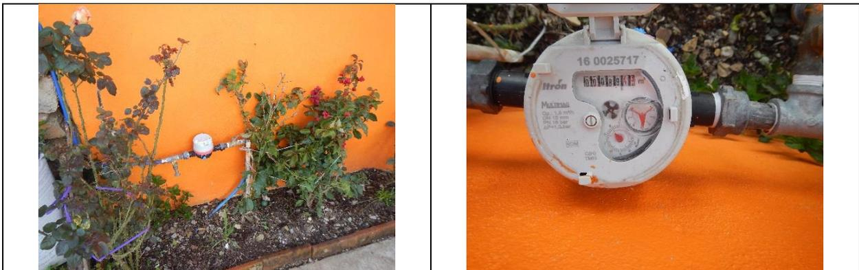
Figura 15. Medidor 160025717, clase C. Toma y detalle de medidor con número de serie. Sin VAF. Localidad San Joaquín. Lectura del medidor: 89.43 m<sup>3</sup>.
