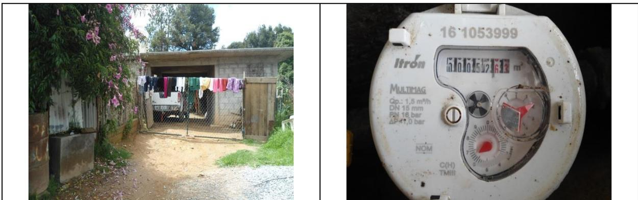
Figura 19. Medidor 161053999, clase C. Predio con toma y detalle de medidor con número de serie. Sin VAF. Comunidad Mesa del Niño, municipio de Cadereyta. Lectura del medidor: 52.63 m<sup>3</sup>. Este medidor está ubicado en una comunidad de Cadereyta, pero por la lejanía la administra San Joaquín.
