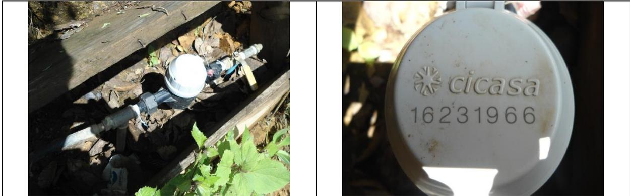
Figura 23. Medidor 16231966, clase B. Toma y detalle de medidor con número de serie. Sin VAF. Comunidad Canoas. Lectura del medidor: 35.20 m<sup>3</sup>.
