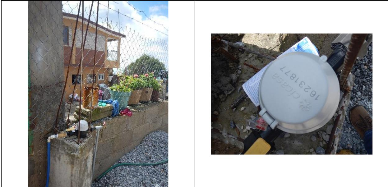
Figura 8. Medidor 16231877, clase B. Predio con toma y detalle de medidor con número de serie. Sin VAF. Comunidad Agua de Venado. Lectura del medidor: 3.78 m<sup>3</sup>.
