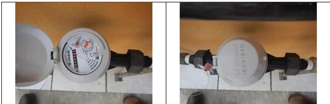
Figura 4. Medidor 16231940, clase B. Detalle de medidor con número de serie. Sin VAF. Localidad San Joaquín. Lectura del medidor: 9.20 m<sup>3</sup>.
