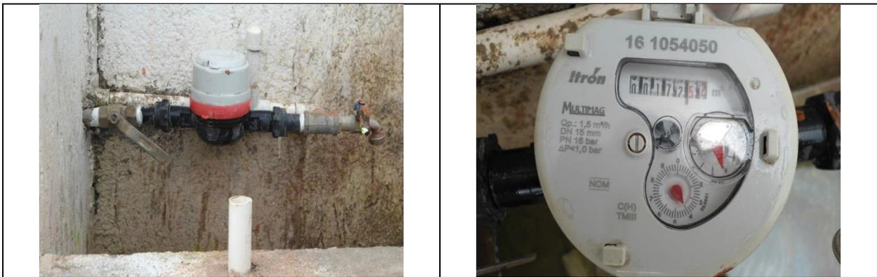
Figura 24. Medidor 161054050, clase C. Toma y detalle de medidor con número de serie. Sin VAF. Comunidad Nuevo San Joaquín. Lectura del medidor: 172.50 m<sup>3</sup>.
