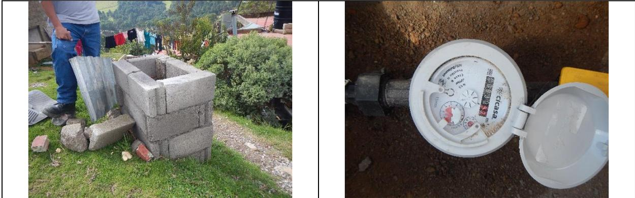
Figura 14. Medidor 16231957, clase B. Predio con toma y detalle de carátula de medidor. Sin VAF. Comunidad La Loma. Lectura del medidor: 30.42 m<sup>3</sup>.
