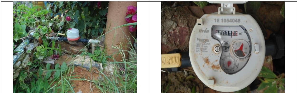
Figura 21. Medidor 161054048, clase C. Predio con toma y detalle de medidor con número de serie. Sin VAF. Comunidad Los Herrera. Lectura del medidor: 48.55 m<sup>3</sup>.
