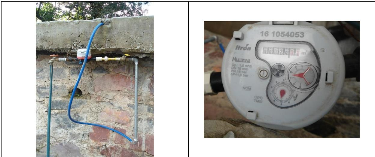
Figura 28. Medidor 161054053, clase C. Toma y detalle de medidor con número de serie. Sin VAF. Comunidad La Guadalupana. Lectura del medidor: 29.00 m<sup>3</sup>.
