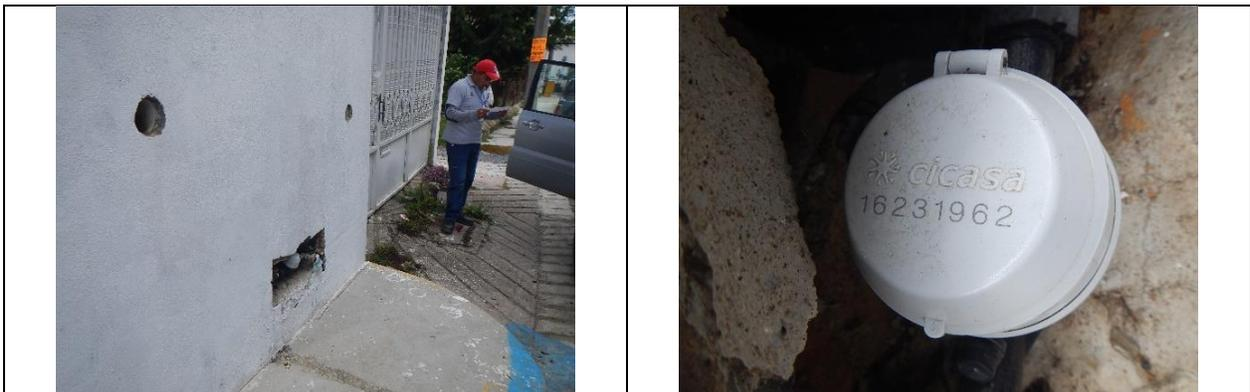
Figura 7. Medidor 16231962, clase B. Predio con toma y detalle de medidor con número de serie. Sin VAF. Localidad San Joaquín. Lectura del medidor: 0.05 m<sup>3</sup>.
