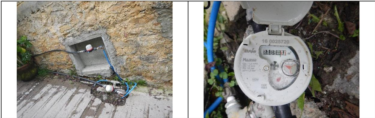
Figura 6. Medidor 160025720, clase C. Toma y detalle de medidor con número de serie. Sin VAF. Localidad San Joaquín, ubicado en el mismo lugar que el medidor 160025716. Lectura del medidor: 33.61 m<sup>3</sup>.
