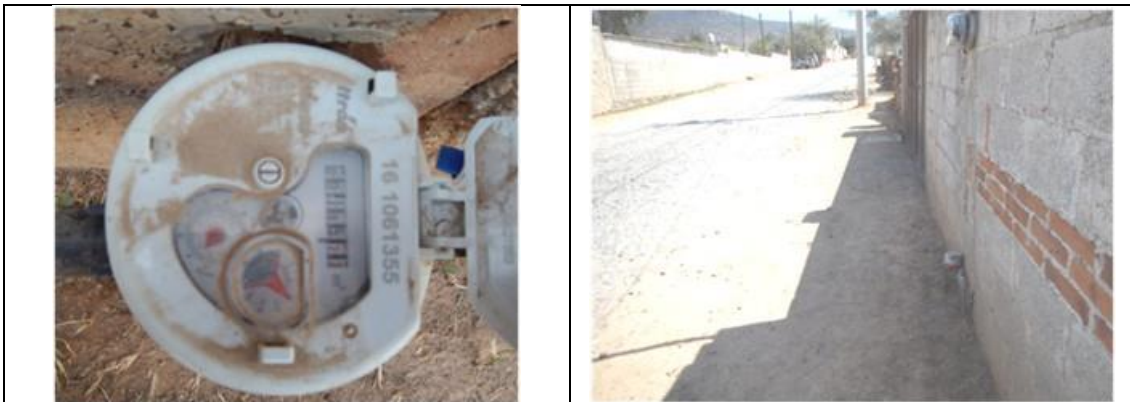
Figura 23. Medidor Itrón, Multimag 161061355, clase C, con VAF. Detalles de medidor con número de serie. Comunidad La Fuente, municipio de Tequisquiapan. Lectura del medidor: 85.77 m 3 . La calle actualmente tiene el nombre de Lázaro Cárdenas, cuando se realizó el contrato tenía el nombre de Del Panteón, por lo que es necesario actualizar la información en el padrón de usuarios. Existe una pequeña fuga.
