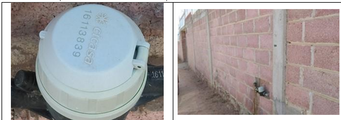
Figura 8. Medidor CICASA, MS Delaunet 16113839, clase B, sin VAF. Detalles de medidor con número de serie. Colonia Cerrito San José, municipio de Tequisquiapan. Lectura del medidor: 211.728 m 3 . Tiene válvula de expulsión de aire.
