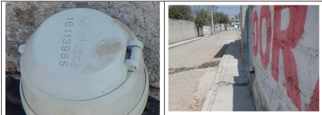
Figura 19. Medidor CICASA, MS Delaunet 16113985, clase B, sin VAF. Detalles de medidor con número de serie. Comunidad La Fuente, municipio de Tequisquiapan. Lectura del medidor: 117.07 m 3 .
