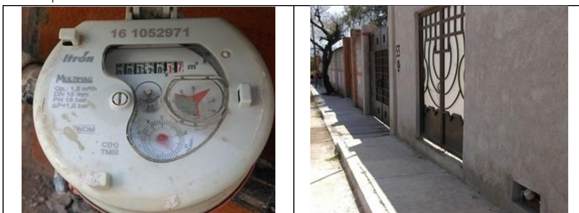
Figura 9. Medidor Itrón, Multimag 161052971, clase C, con VAF. Detalles de medidor con número de serie. Colonia Hacienda Grande, municipio de Tequisquiapan. Lectura del medidor: 320.171 m 3 . La Calle ya tiene nombre "Mármol No 53", por lo debe realizar la actualización del padrón de usuarios.
