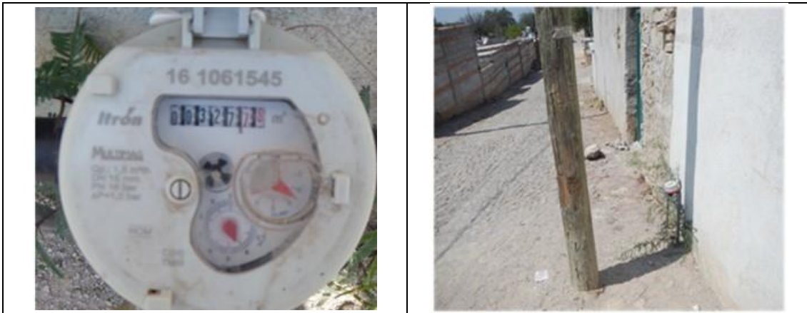
Figura 27. Medidor Itrón, Multimag 161061545, clase C, con VAF . Detalles de medidor con número de serie. Comunidad La Fuente, municipio de Tequisquiapan. Lectura del medidor: 327.78 m 3 .
