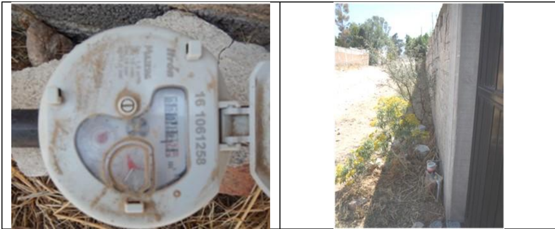
Figura 22. Medidor Itrón, Multimag 161061258, clase C, con VAF. Detalles de medidor con número de serie. Comunidad La Fuente, municipio de Tequisquiapan. Lectura del medidor: 18.27 m 3 . La calle actualmente tiene nombre (Miguel Alemán), cuando se realizó el contrato no tenía, por lo que es necesario actualizar la información en el padrón de usuarios.
