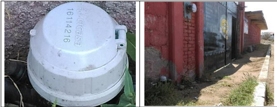
Figura 4. Medidor CICASA, MS Delaunet 16114216, clase B, sin VAF. Detalles de medidor con número de serie. Colonia Ampliación Adolfo López Mateos, municipio de Tequisquiapan. Lectura del medidor: 2.385 m 3 . Tiene válvula de expulsión de aire.
