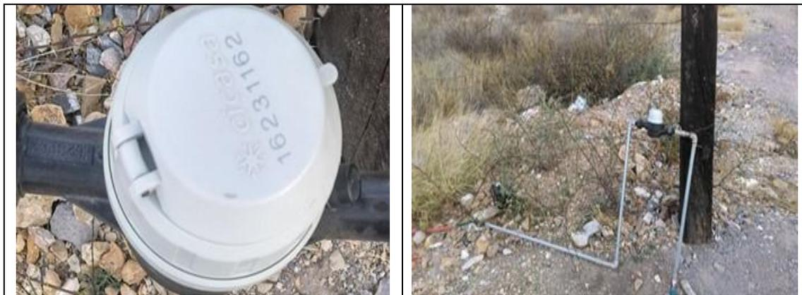
Figura 8. Medidor CICASA, MS Delaunet 16231162, clase B, sin VAF. El cual reemplazó al medidor 16104913. Comunidad el Molino, municipio de Tolimán. Lectura del medidor: 98.053 m<sup>3</sup>.
