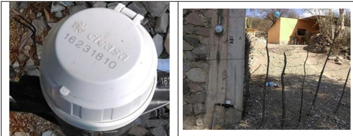
Figura 11. Medidor CICASA, MS Delaunet 16231810, clase B, **con VAF2**. Detalles de medidor con número de serie. Comunidad Horno de Cal, municipio de Tolimán. Lectura del medidor: 120.163 m<sup>3</sup>. Tiene goteo (fuga) en el cuadro y tiene cinta de aislar pegada.
