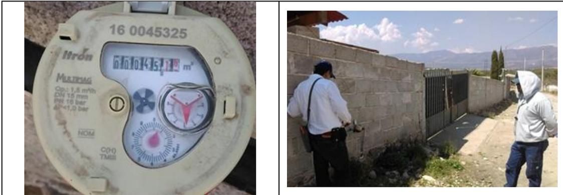
Figura 25. Medidor Itrón, Multimag 160045325, clase C, con VAF1. Detalles de medidor con número de serie. Comunidad San Pablo, municipio de Tolimán. Lectura del medidor: 45.165 m<sup>3</sup>.
