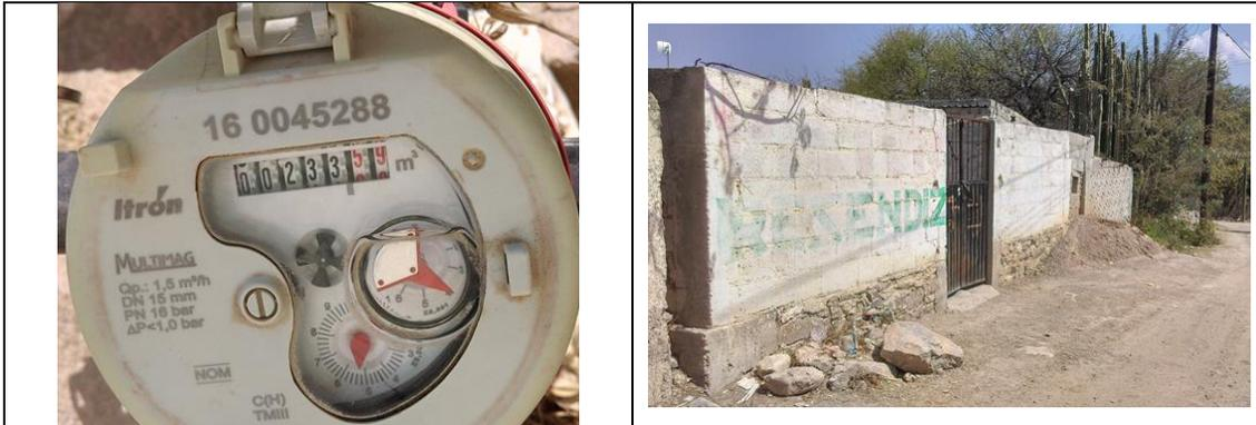
Figura 20. Medidor Itron, Multimag 160045288, clase C, sin VAF. Detalles de medidor con número de serie. Comunidad San Pablo, municipio de Tolimán. Lectura del medidor: 233.593 m<sup>3</sup>.
