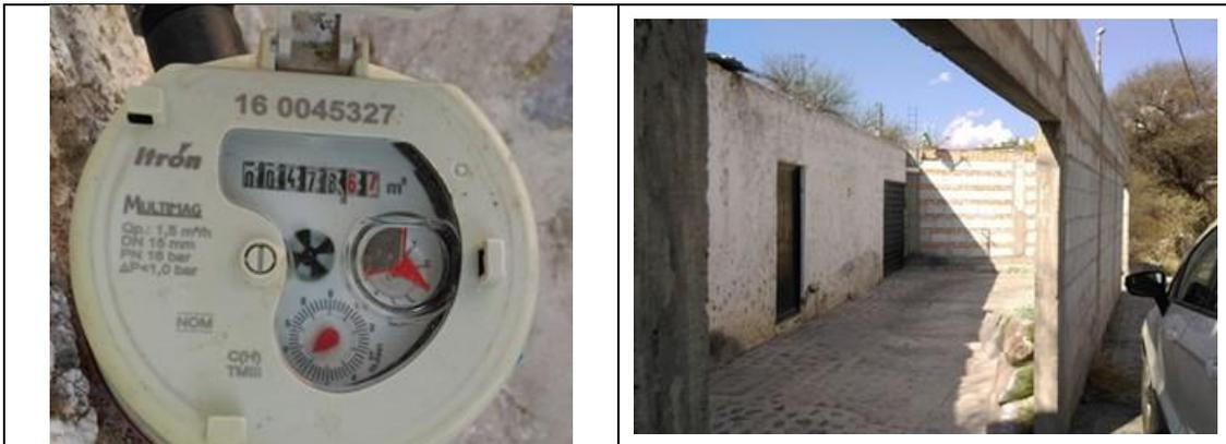
Figura 15. Medidor Itrón, Multimag 160045327, clase C, sin VAF. Detalles de medidor con número de serie. Comunidad La Loma, municipio de Tolimán. Lectura del medidor: 478.670 m<sup>3</sup>. **El medidor está instalado en el interior del predio.**
