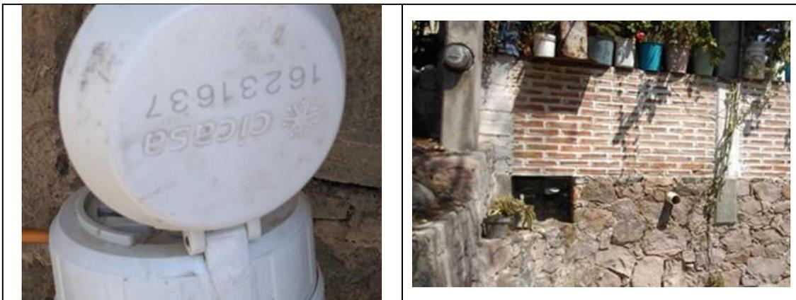
Figura 14. Medidor CICASA, MS Delaunet 16231637, clase B, sin VAF. Detalles de medidor con número de serie. Comunidad Horno de Cal, municipio de Tolimán. Lectura del medidor: 117.010 m<sup>3</sup>.
