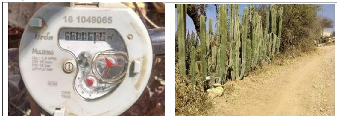
Figura 18. Medidor Itron, Multimag 161049065, clase C, **con VAF2**. Detalles de medidor con número de serie. Comunidad Rancho Nuevo, municipio de Tolimán. Lectura del medidor: 336.019 m<sup>3</sup>. El usuario manifestó que existe fuga, al momento de la inspección no se observó fuga.
