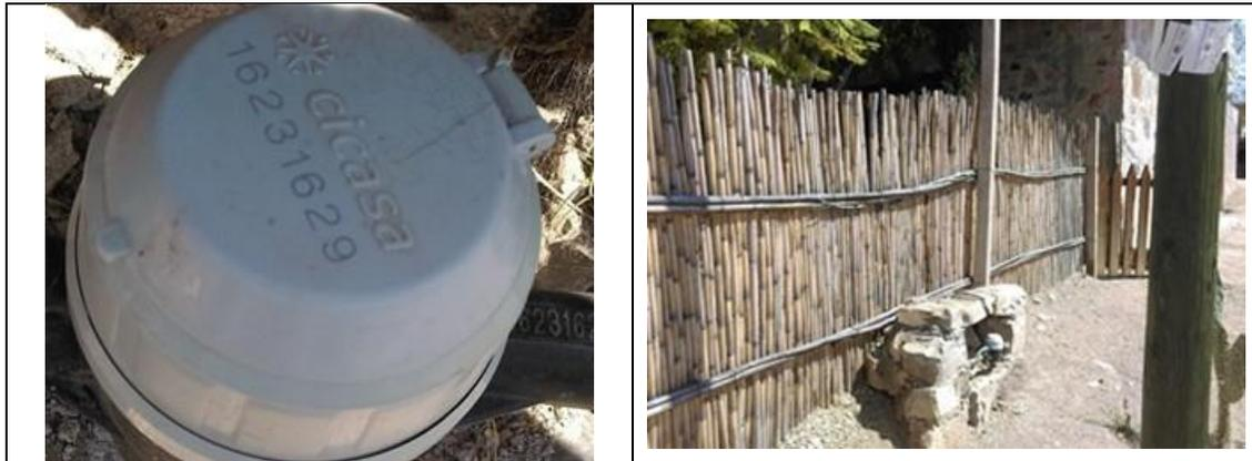
Figura 9. Medidor CICASA, MS Delaunet 16231629, clase B, sin VAF. Detalles de medidor con número de serie. Comunidad Horno de Cal, municipio de Tolimán. Lectura del medidor: 150.941 m<sup>3</sup>.
