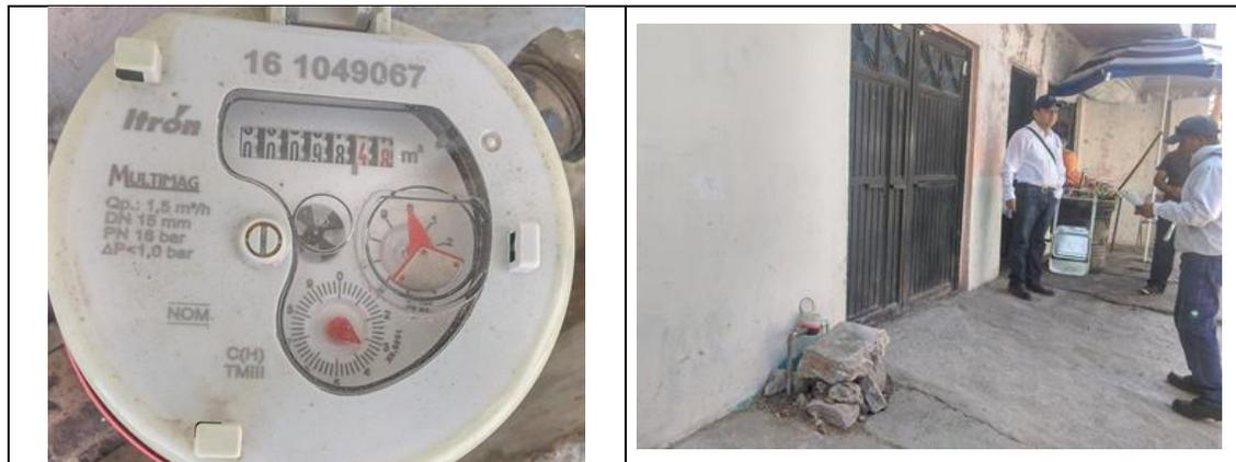
Figura 21. Medidor Itron, Multimag 161049067, clase C, sin VAF. Detalles de medidor con número de serie. Comunidad San Pablo, municipio de Tolimán. Lectura del medidor: 98.479 m<sup>3</sup>.
