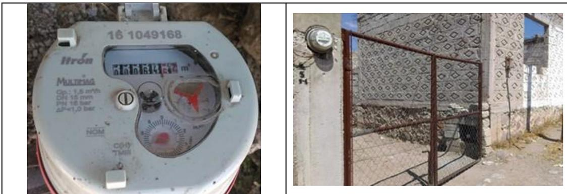
Figura 24. Medidor Itron, Multimag 161049168, clase C, sin VAF. Detalles de medidor con número de serie. Comunidad San Pablo, municipio de Tolimán. Lectura del medidor: 64.625 m<sup>3</sup>. **El medidor está instalado en el interior del predio.**
