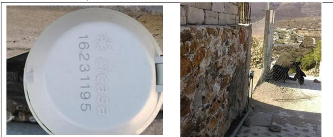
Figura 3. Medidor CICASA, MS Delaunet 16231195, clase B, sin VAF. Detalles de medidor con número de serie. Comunidad Casas Viejas, municipio de Tolimán. Lectura del medidor: 12.436.790 m<sup>3</sup>.
