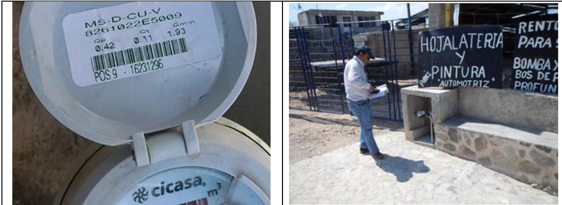
Figura 28. Medidor CICASA, MS Delaunet 16231296, clase B, con VAF2. Detalles de medidor con número de serie. Comunidad San Pablo, municipio de Tolimán. Lectura del medidor: 221.699 m<sup>3</sup>.
