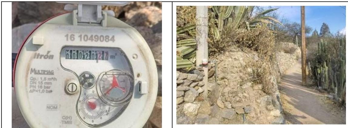
Figura 16. Medidor Itron, Multimag 161049084, clase C, **con VAF1**. Detalles de medidor con número de serie. Comunidad Los González, municipio de Tolimán. Lectura del medidor: 20.270 m<sup>3</sup>.
