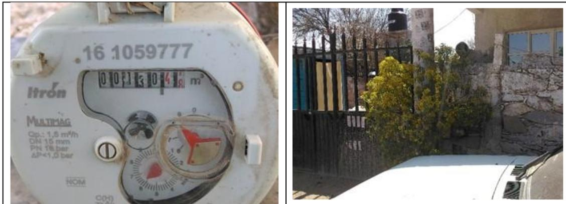
Figura 26. Medidor Itrón, Multimag 16114132, clase C, con VAF2. Detalles de medidor con número de serie. Comunidad San Pablo, municipio de Tolimán. Lectura del medidor: 130.479 m<sup>3</sup>.
