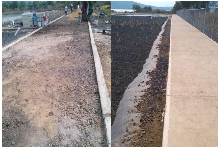
Figura 19. Instalación de andadores.
