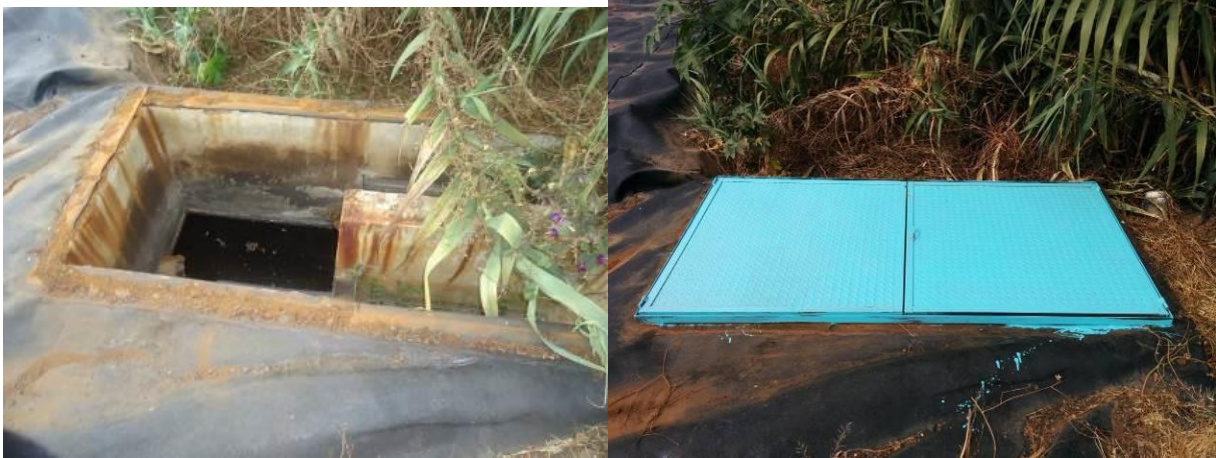
Figura 13. Retiro de rejillas en mal estado.
