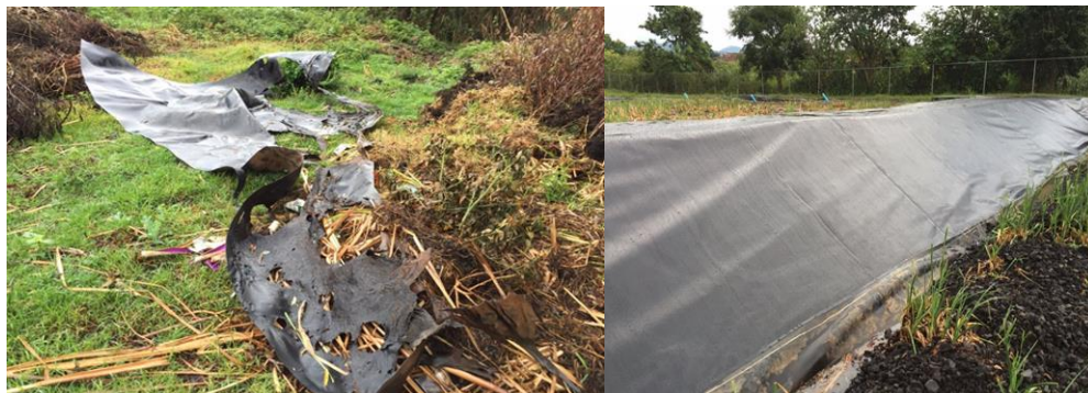
Figura 40. Reparación de geomembrana.
