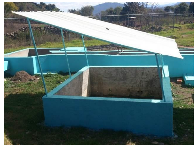
Figura 12. Trabajos de herrería en los techos del lecho de secado.
