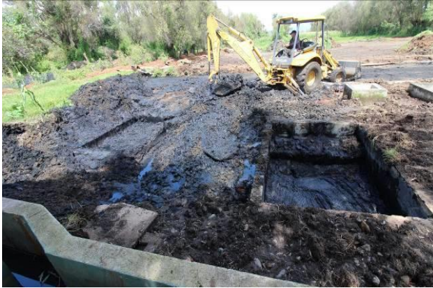
a) Retiro de lodos del lecho de secado.
