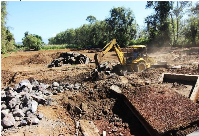
c) Retiro de geomembrana de la celda A.
