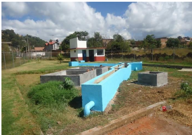
Figura 11. Acondicionamiento de pretil del lecho de secado de lodos y de registro de distribución.
