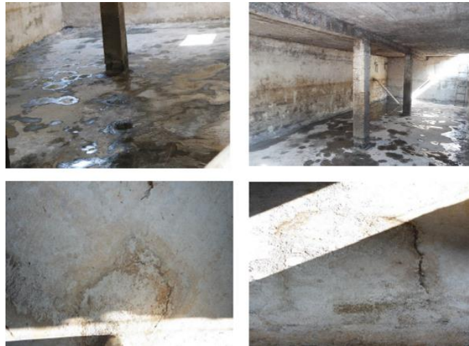
Figura 43. Limpieza del tanque sedimentador.
