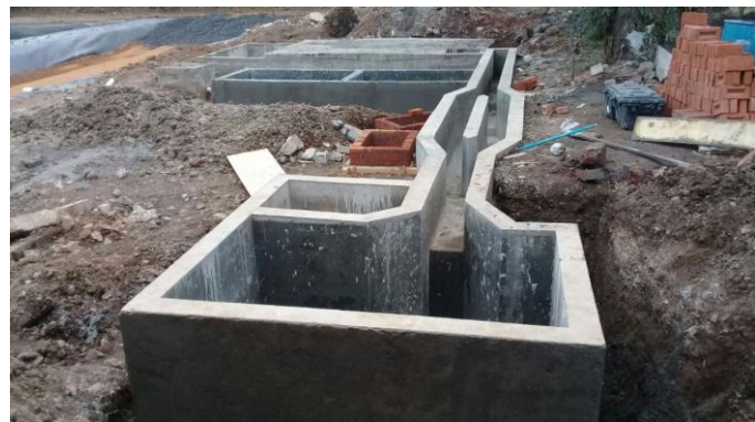
Figura 23. Replanteo de la caja de amortiguamiento.
