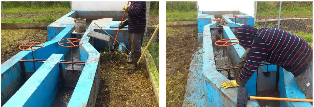
Figura 16. Limpieza y mantenimiento a los elementos del pretratamiento.
