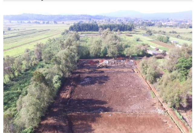
d) Retiro de material y geomembrana.
