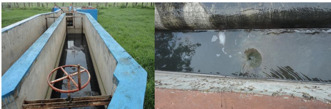
Figura 36. Limpieza del vertedor y canales sedimentadores.
