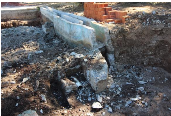
Figura 23. Replanteo de la caja de amortiguamiento.
