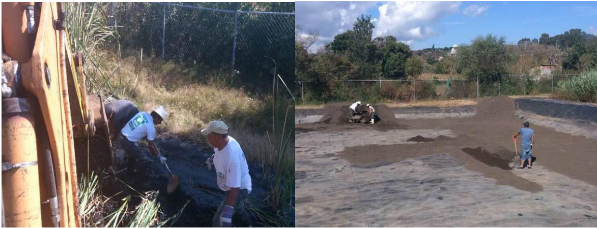
Figura 10. Sustitución de material pétreo.
