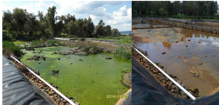
Figura 42. Limpieza de las lagunas de pulimiento.
