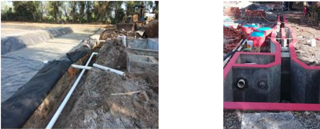
Figura 27. Sustitución de elementos de acero del pretratamiento y tubería del sistema.
