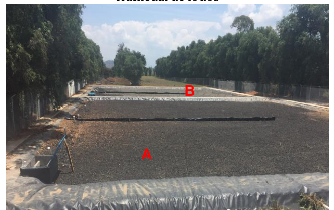
Celdas de tratamiento
