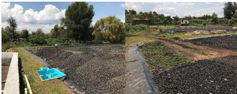
Figura 20. Rehabilitación del humedal de Cucuchucho.
