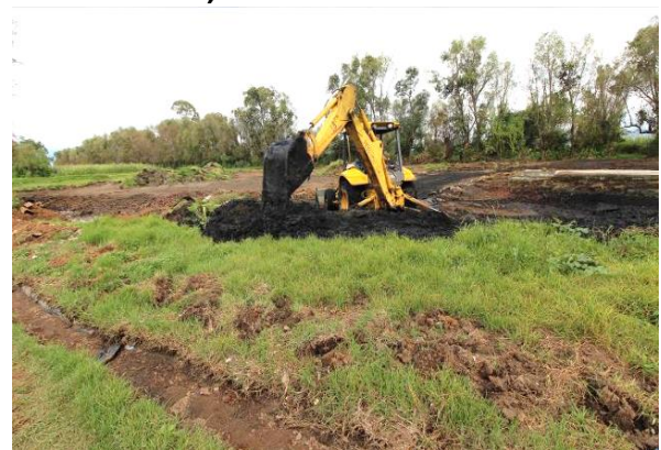
d) Celdas de tratamiento
