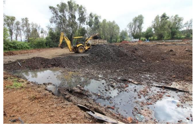
b) Extracción de material de la celda B.
