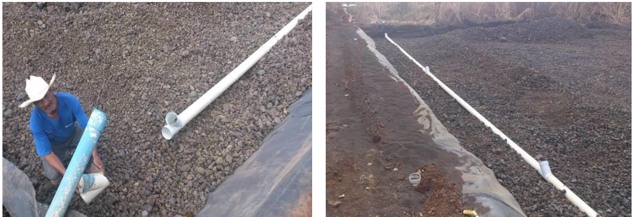
Figura 14. Sustitución de tubería dañada y renivelación de la tubería nueva.
