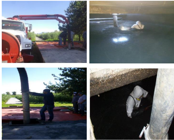
Figura 45. Limpieza del tanque sedimentador.
