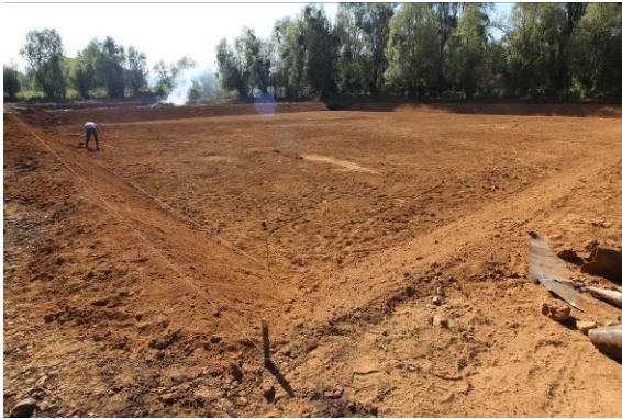
Figura 24. Nivelación de las celdas del humedal.
