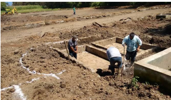
e) Limpieza del lecho de lodos
