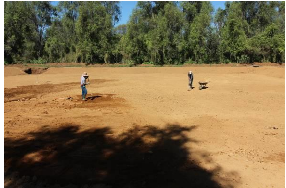
Figura 24. Nivelación de las celdas del humedal.
