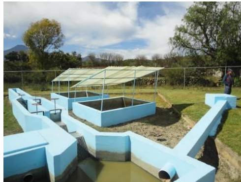
Figura 38. Mantenimiento en el pretratamiento del humedal D1.
