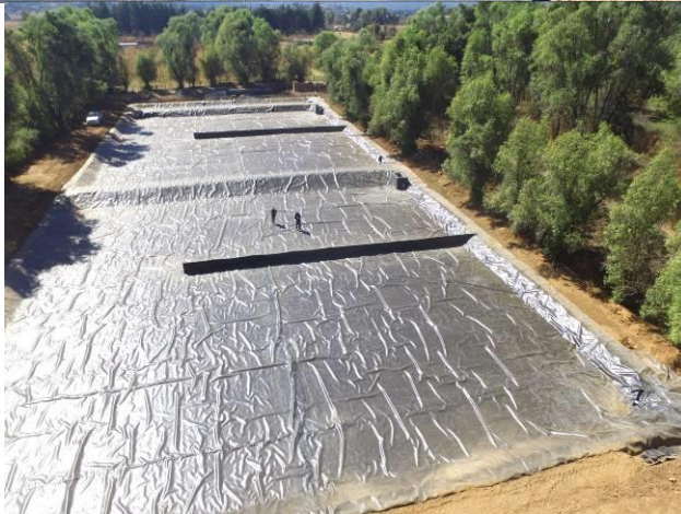
Figura 25. Instalación de geomembrana.
