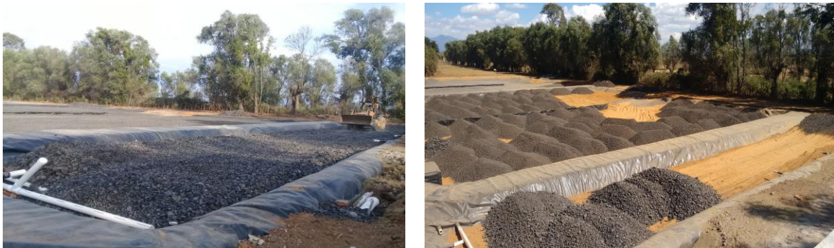
Figura 26. Sustitución de material pétreo.
