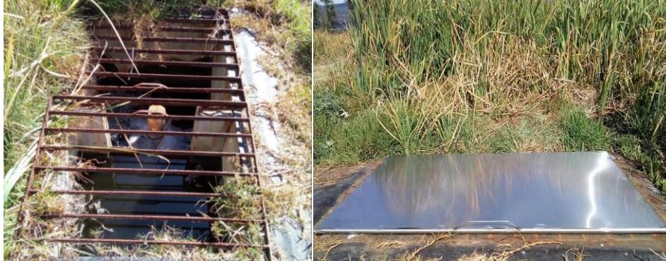
Figura 37. Sustitución de tapas.
