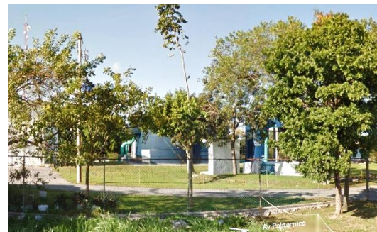
Ilustración 4.45 PTAR Caribe 2000, vista desde Av. Politécnico
