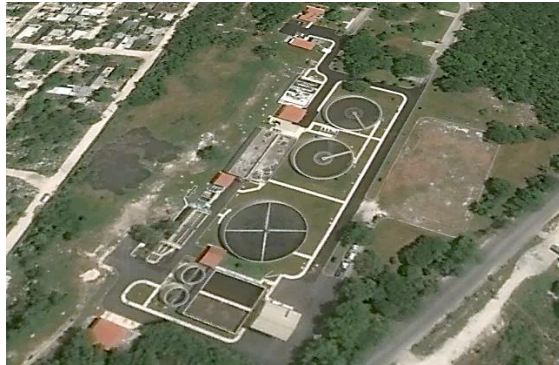
Ilustración 4.42 PTAR Norte, vista aérea.
