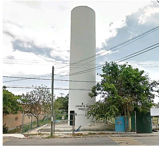
Ilustración 4.22 Cisterna y tanque FOVISSSTE
