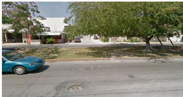
Ilustración 4.39 Pozo de visita de colector a donde llega el emisor
