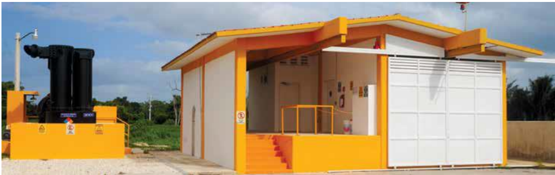
Ilustración 4.15 Caseta de cloración cerrada con equipo neutralizador de gas cloro Scrubber. PTAR Norte. Fuente: Calidad AP cloración, casetas abiertas y cerradas, Aguakan.
