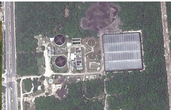
Ilustración 4.41 PTAR Norponiente, vista aérea
