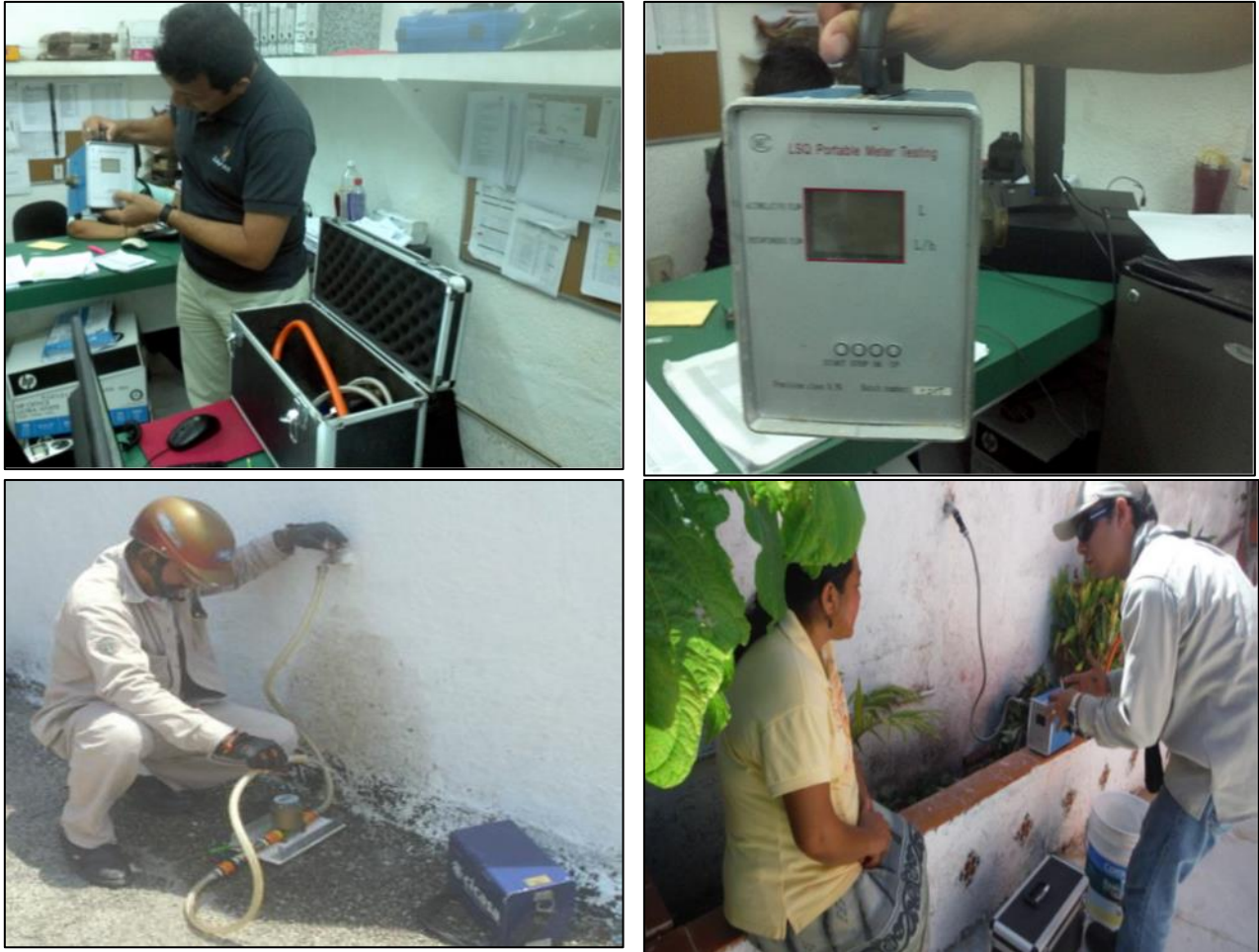
Ilustración 4.69 Verificación del micromedidor utilizando un medidor patrón equipo portátil
