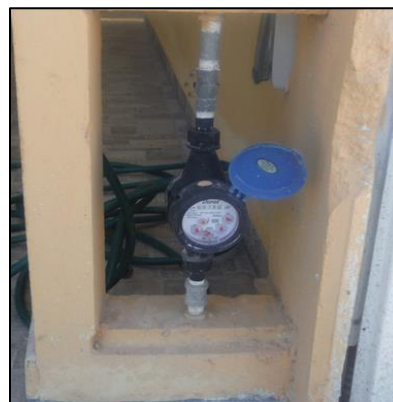
Ilustración 4.68 Instalación de medidores nuevos
