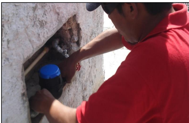
Ilustración 4.68 Instalación de medidores nuevos
