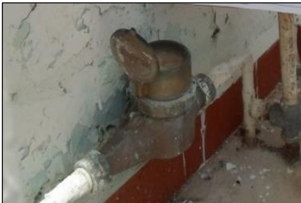
Ilustración 4.67 Situación actual de la micromedición instalada
