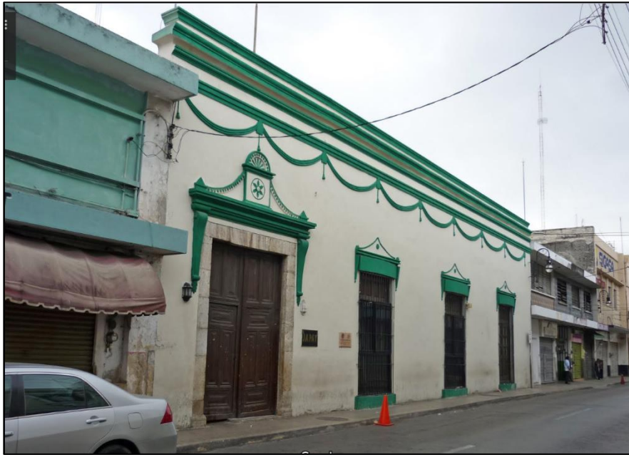
Ilustración 4.94 Oficinas central de la JAPAY
