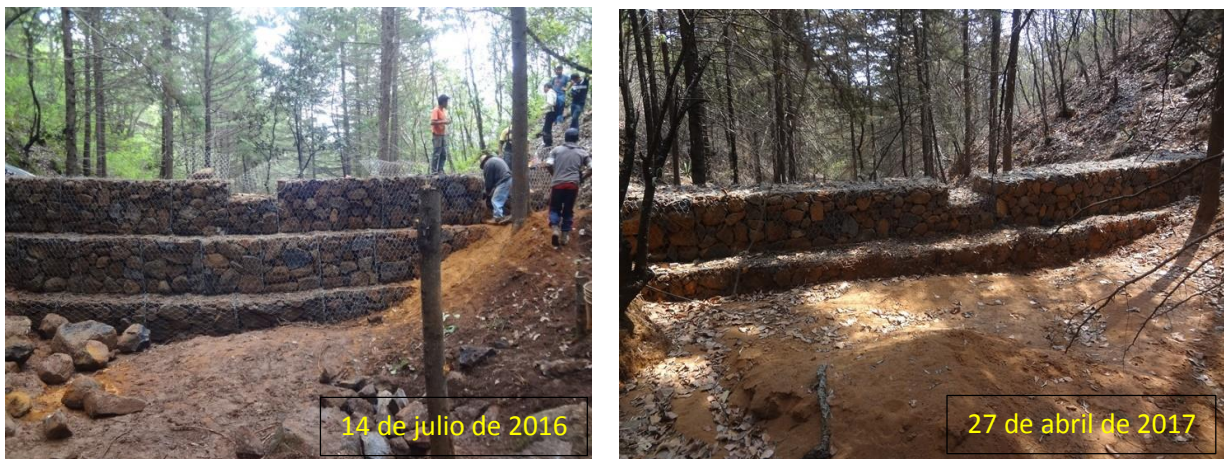
Figura 86. Presa de gaviones 02 donde se observa la retención de sedimentos después de 9 meses de construida.
