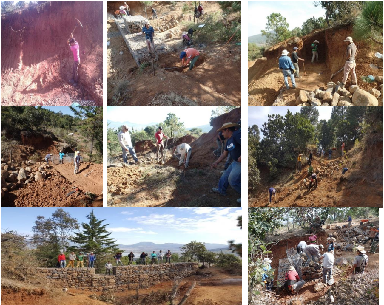
Figura 62. Participación la construcción de presas de gavión.
