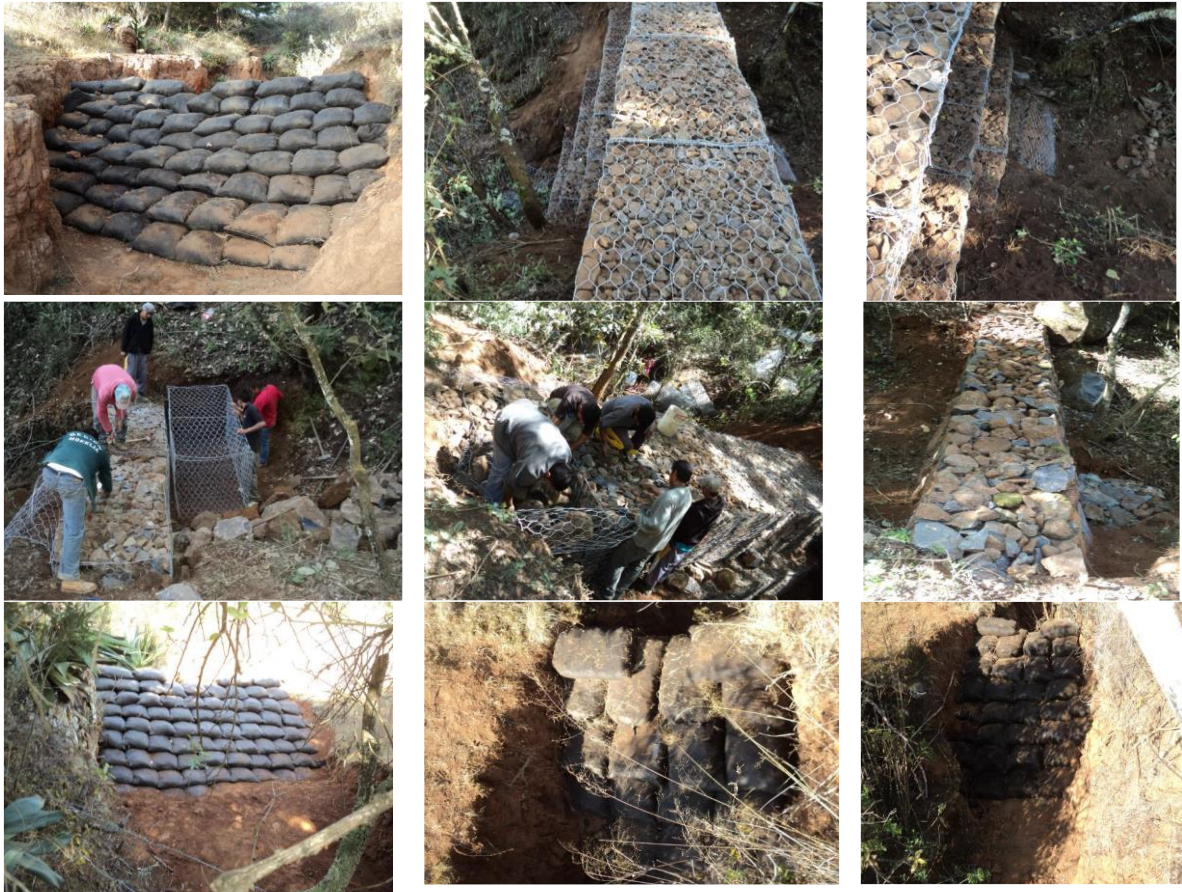
Figura 52. Obras de conservación 2014.
