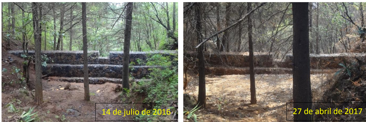
Figura 85. Presa de gaviones 01 donde se observa la retención de sedimentos después de 9 meses de construida.
