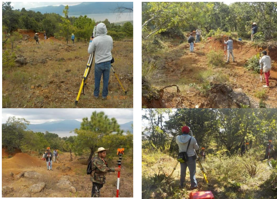
Figura 56. Levantamiento topográfico del área donde se construyeron las presas en la microcuenca del Cerro Tariaqueri.
