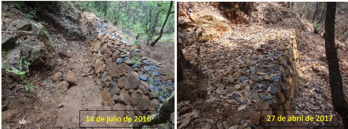
Figura 87. Presa de piedra acomodada 01 donde se observa la retención de sedimentos después de 9 meses de construida.
