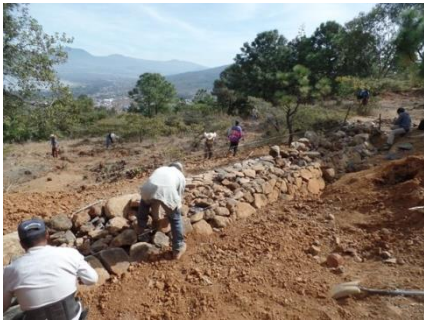
Figura 61. Participación la construcción de piedra acomodada.
