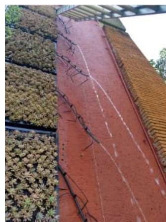
Figura 4.104 Instalación de medios auxiliares para el sistema de riego
