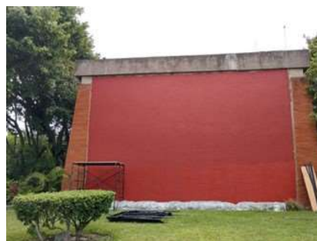
Figura 4.78 Proceso y aplicación de la doble capa de impermeabilizante
