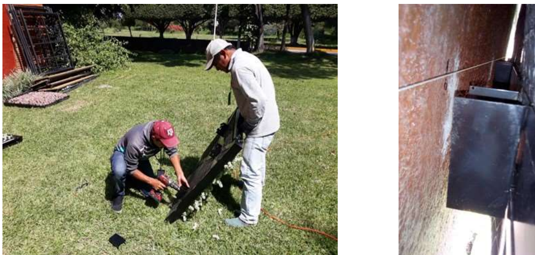
Figura 4.99 Colocación de grapas de nivel
