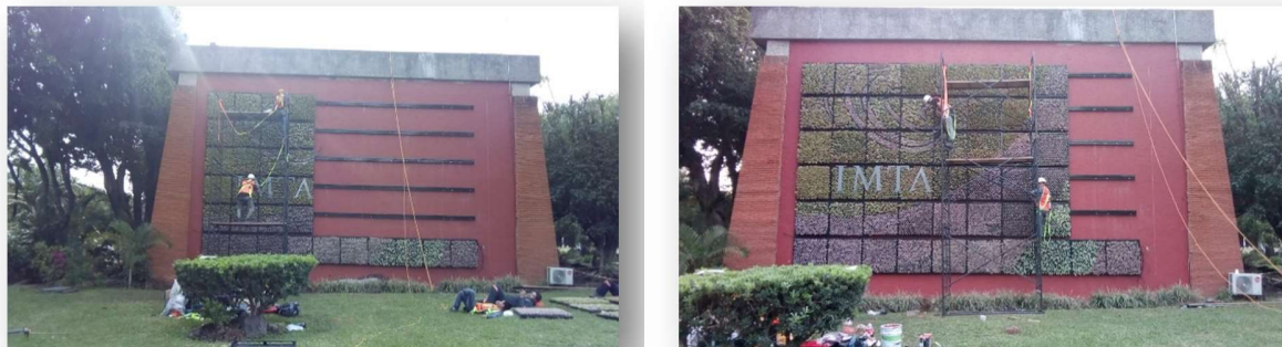
Figura 4.101 Avance en la instalación de módulos
