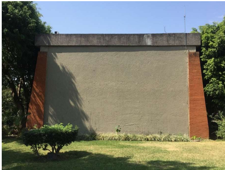
Figura 4.70 Pared frontal del edificio de Riego y Drenaje
