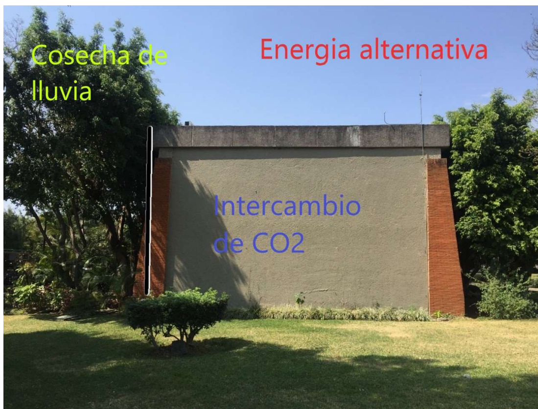
Figura 4.61 Fachada original para instrumentar
