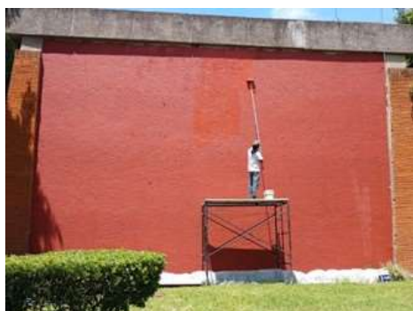
Figura 4.78 Proceso y aplicación de la doble capa de impermeabilizante
