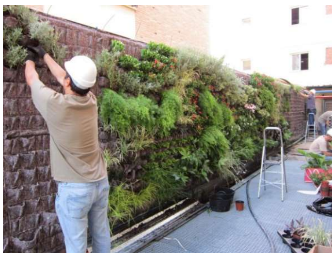
Figura 4.10 Muro verde en exterior
