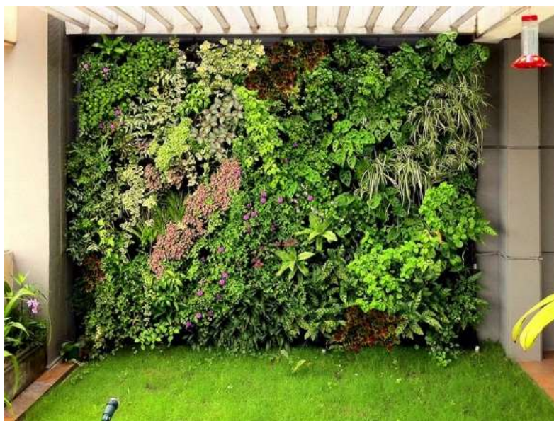
Figura 4.8 Muro verde interior
