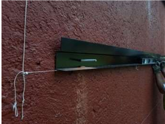
Figura 4.81 Tiras de cargas a nivel sostenidas con varilla roscada
