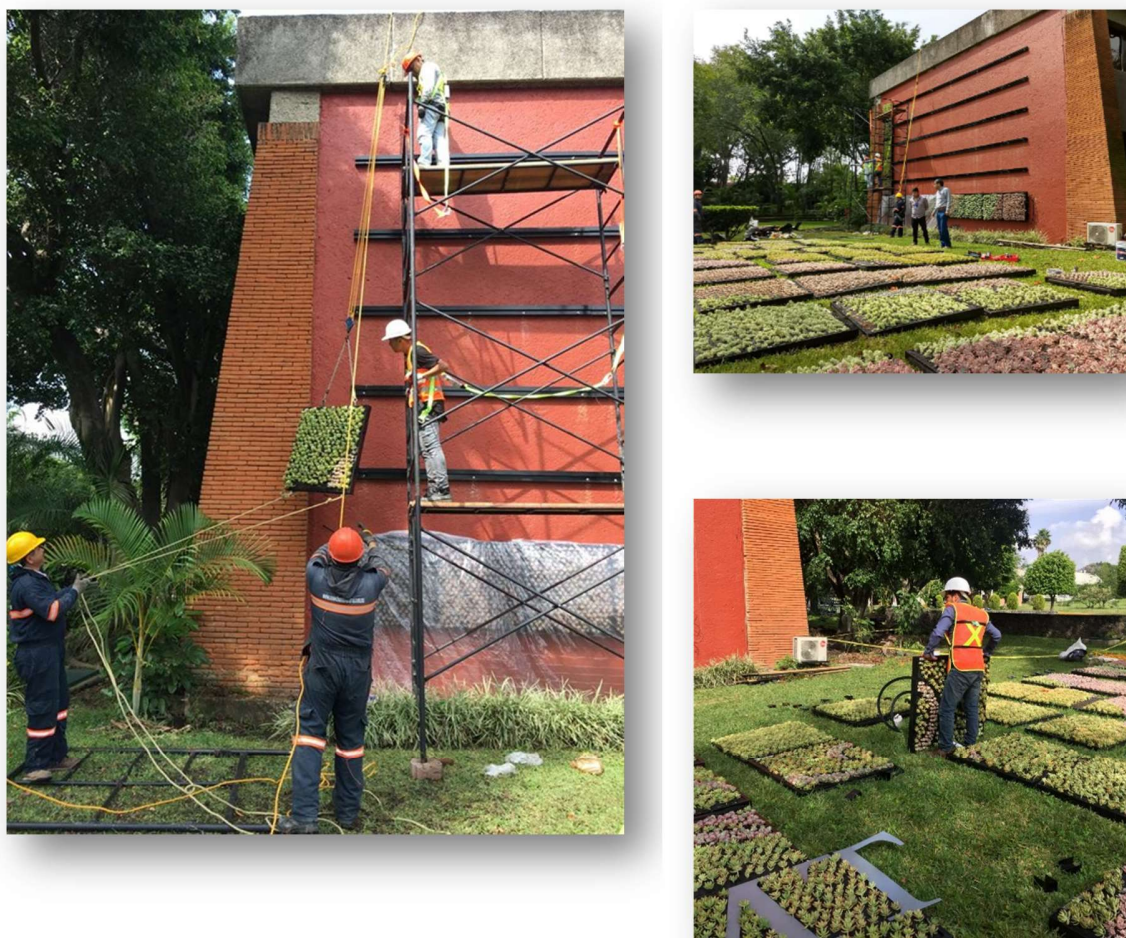
Figura 4.100 Maniobras de instalación
