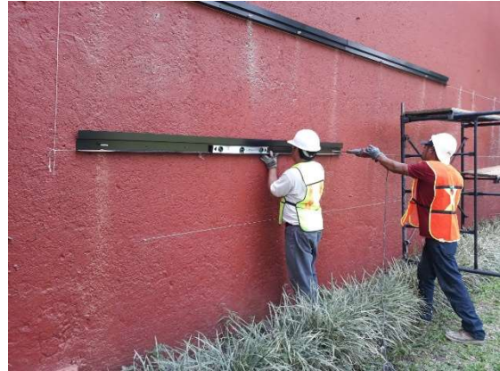
Figura 4.81 Tiras de cargas a nivel sostenidas con varilla roscada
