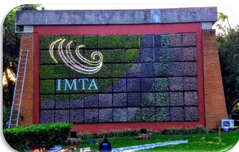
Figura 4.102 Instalación terminada del muro verde
