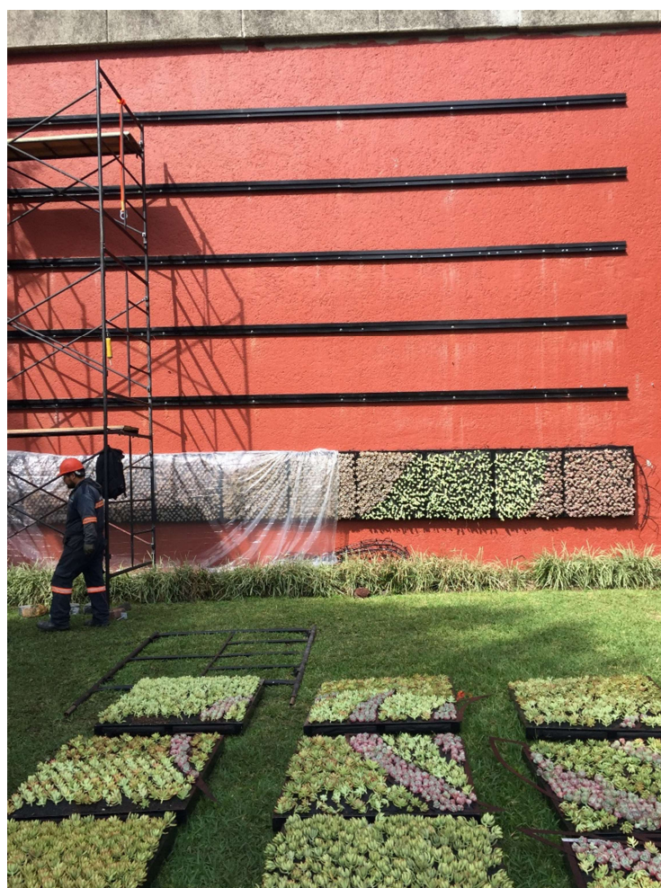
Figura 4.30 Estructuras para acondicionar el muro verde
