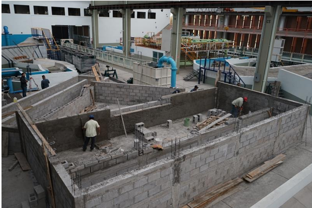
Figura 2-13. Aplanado en muros exteriores con acabado fino
