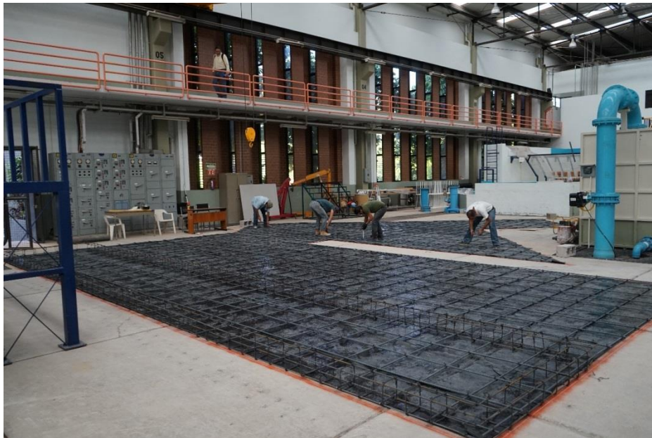
Figura 2-7. Armado para el firme de concreto
