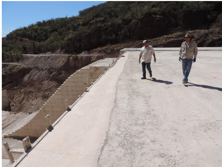
Figura 4-81. Vista general de la chapa de concreto f'c=150 kg/cm 2 .
