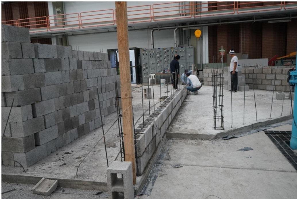
Figura 2-11. Levantamiento de muros
