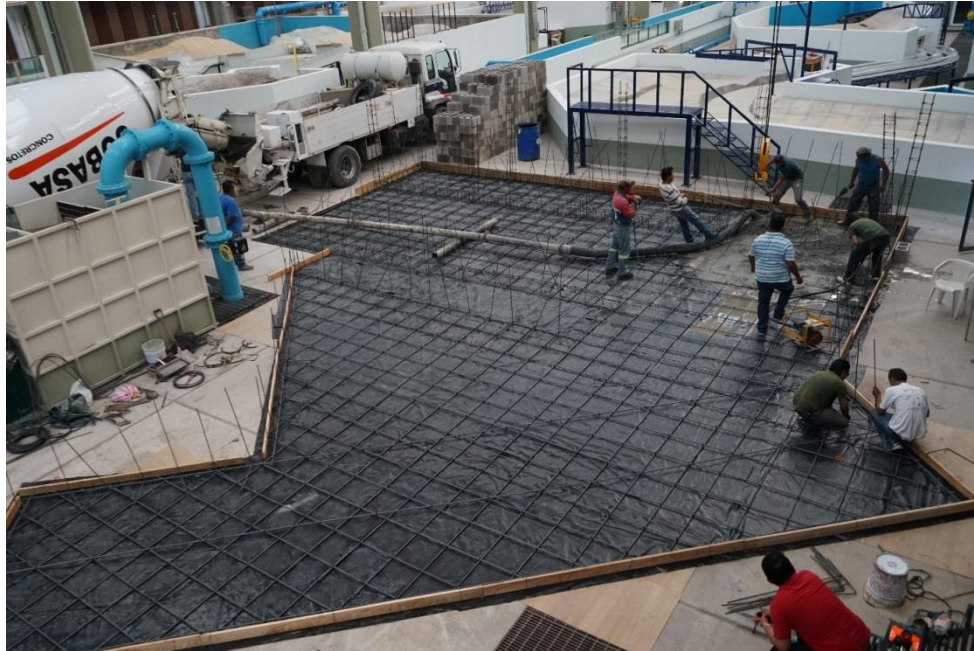
Figura 2-8. Colocación de cimbra
