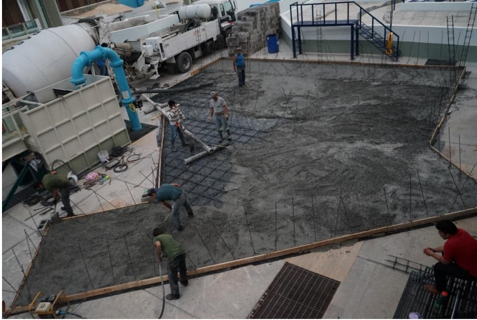
Figura 2-9. Colado de concreto para conformar el firme
