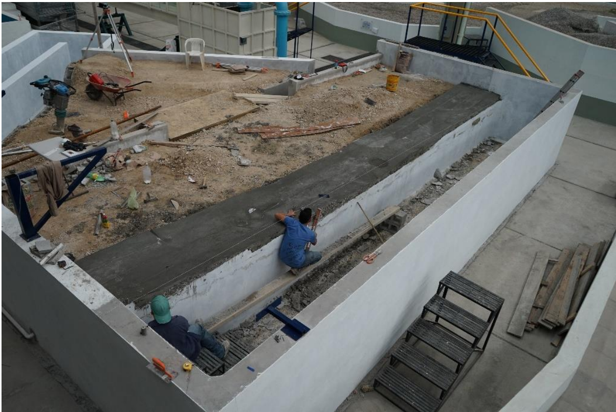
Figura 2-15. Nivelación a plomo y colocación de tarrajas
