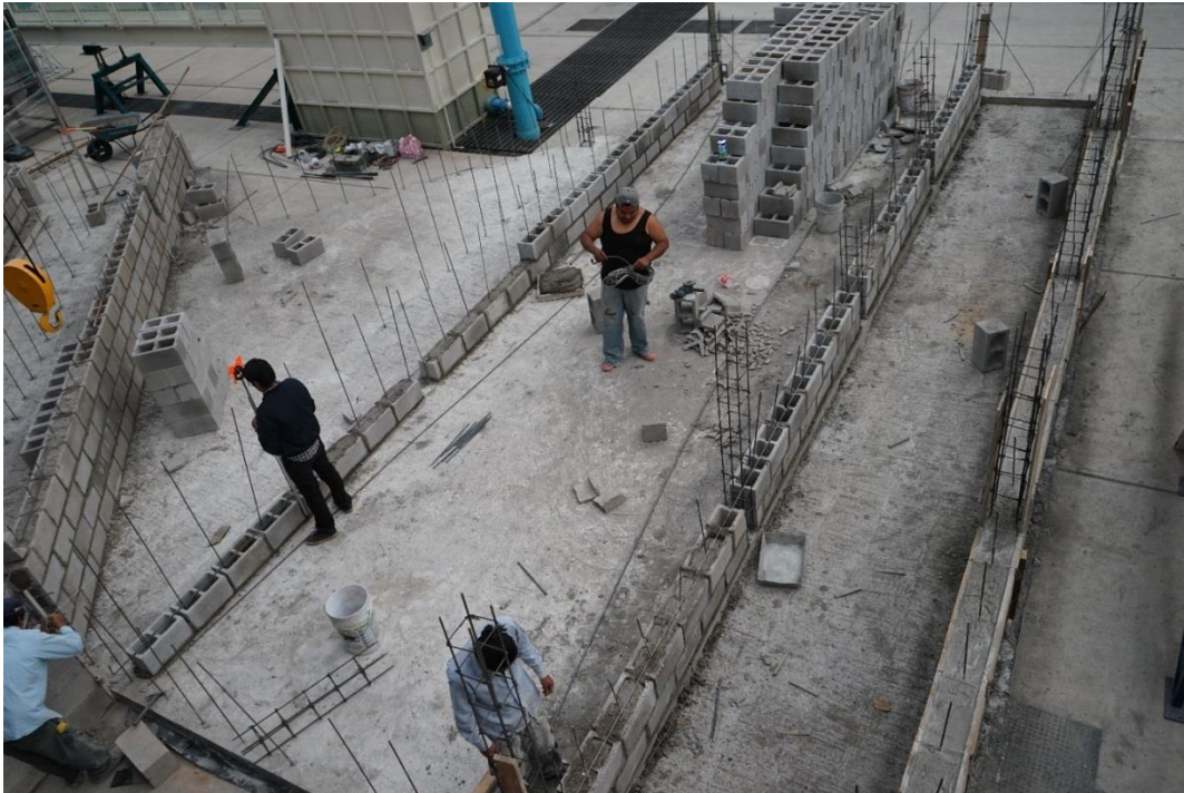
Figura 2-12. Llenado de la cavidad con concreto f'c = 19.61 \text{ MPA} ( 200 \text{ kg/cm}^2 )
