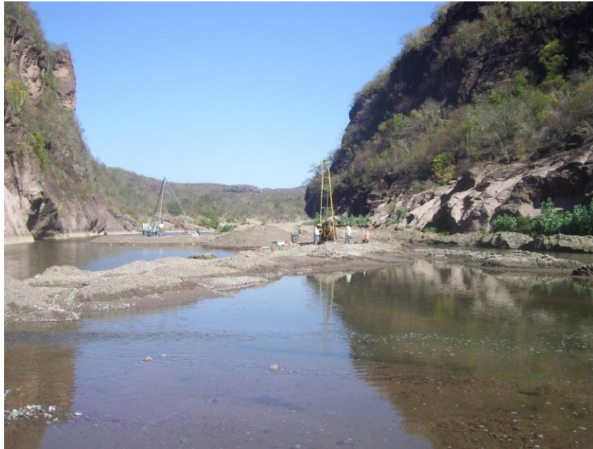
Figura 4-1. Trabajos de Perforación Geotécnica en el Proyecto de Presa Reguladora “Pilares”. Fuente: Proyecto Ejecutivo de la Presa Reguladora Pilares, sobre el Río Mayo, Mpio. Álamos, Estado de Sonora. Capítulo IV. Geología.
