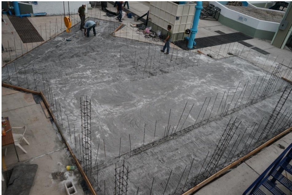
Figura 2-10. Losa de concreto hidráulico terminada
