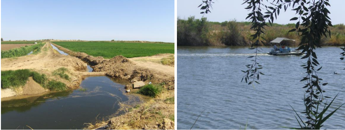
Figuras 4 y 5. Agua tratada reusada en riego agrícola y en rehabilitación del Río Hardy
