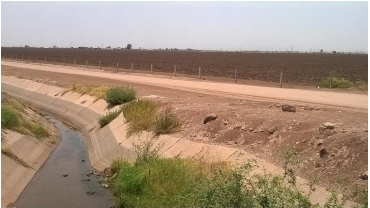
Figura 2.1 Vista de los drenes sin caudal (junio 2017)
