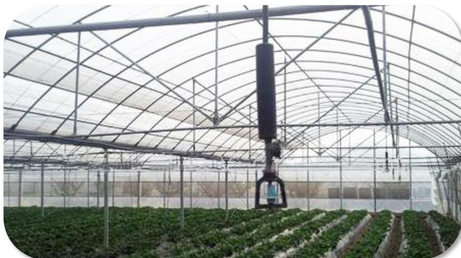
Figura 6. Sistema de riego por microaspersión.
