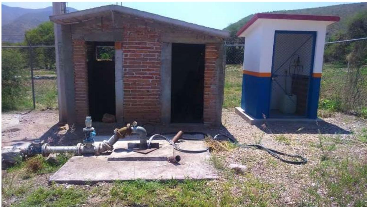
**Figura 1-8. Caseta de cloración (derecha) y caseta de operación con arrancador (izquierda)**
