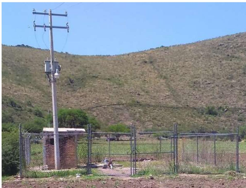
**Figura 1-7. Transformador de 45 KVA del pozo de Milpillas**
