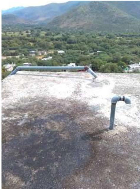
**Figura 7-21. Cadenamiento 1+297.00 llegada de la tubería al tanque de almacenamiento**
