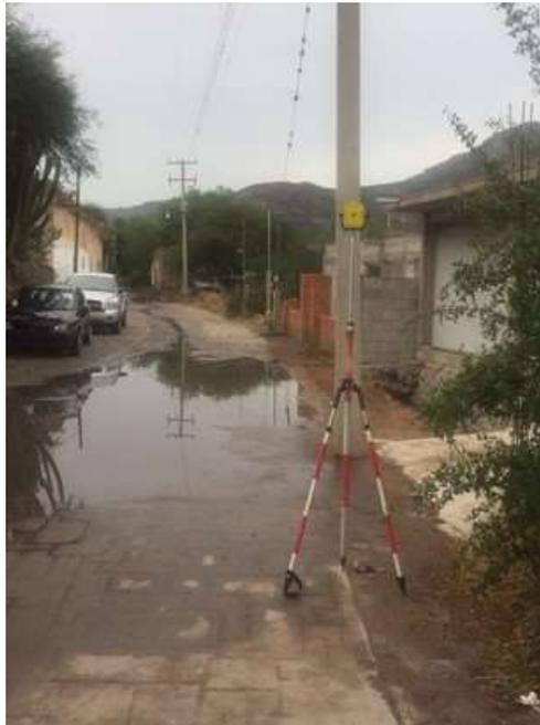
**Figura 7-17. Cadenamiento 0+780.00, punto que se utilizó como liga entre el levantamiento con GPS y estación total.**
