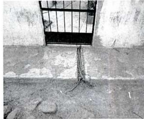
Las imágenes muestran la estructura y materiales de los ramales de las tomas domiciliarias existentes, no se tienen estructuras que garanticen un uso racional del agua, motivo por el cual existe desperdicio y uso desmedido por los usuarios.
