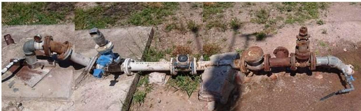
**Figura 1-4. Tren de descarga del pozo de Milpillas**
