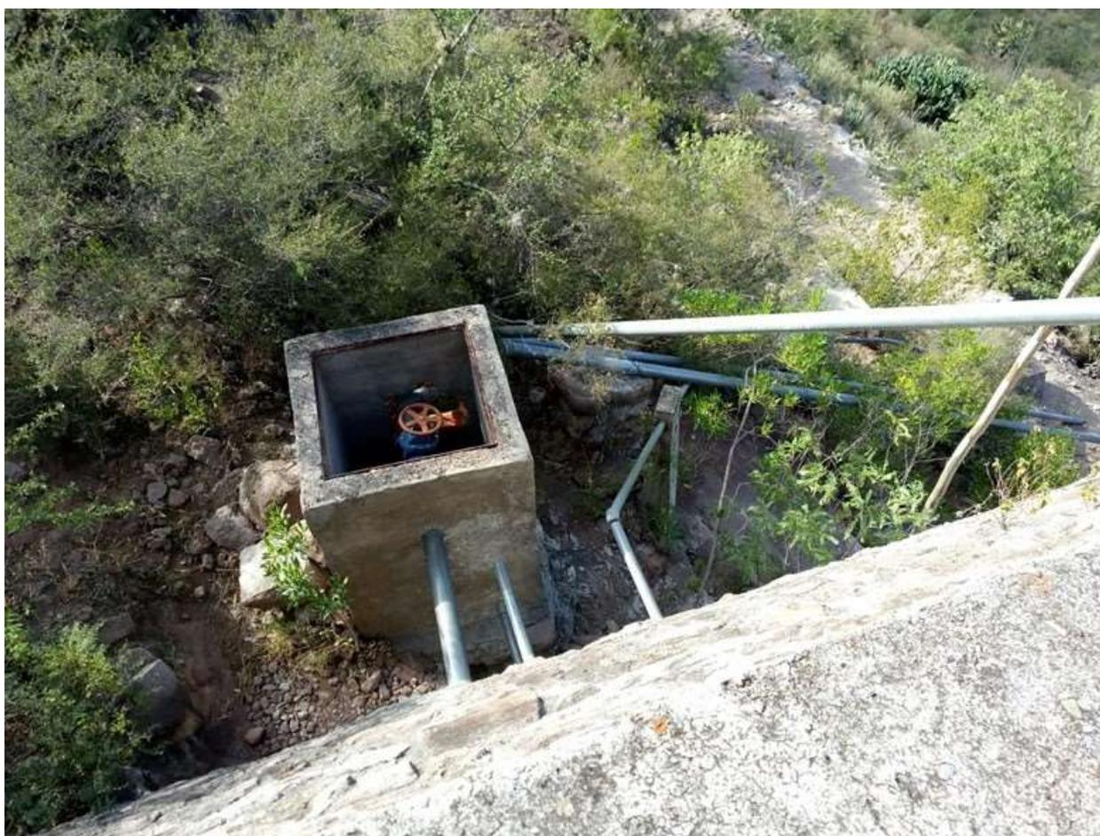
**Figura 1-5. Tubería de llegada de 3" (superior) y tubería de descarga de 4" (inferior) con válvula**
