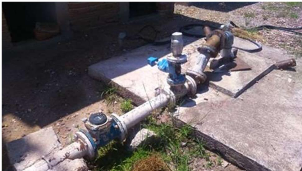
**Figura 7-6. Banco de Nivel 1 (1720.30 msnm), sobre la válvula de expulsión de aire, en el tren de descarga del pozo**
