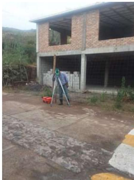
**Figura 7-16. Cadenamiento 0+880.00, punto en el que se continuó con la estación total, ligando después los puntos con el GPS**
