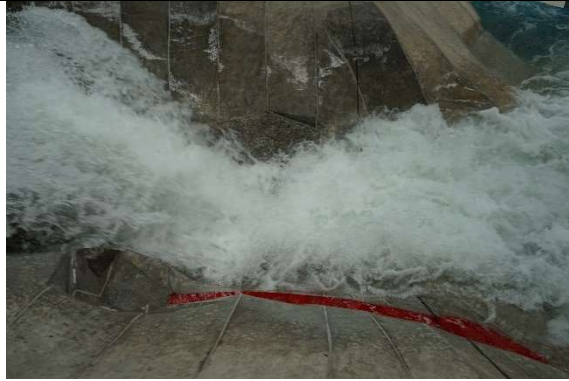
Fotografía 129. Los chorros caen antes de la ataguía, sin embargo, se aprecia un fuerte empuje sobre esta.
