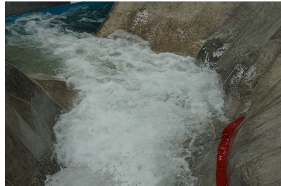
Fotografía. 101. Vista aérea del funcionamiento del vertedor, con ataguía y escotadura, para un Q= 6010 m 3 /s.
