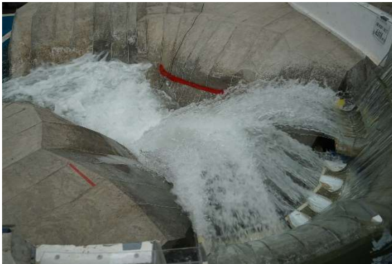
Fotografía. 100. Vista aérea del funcionamiento del vertedor, con ataguía y escotadura, para un Q= 6010 m 3 /s.
