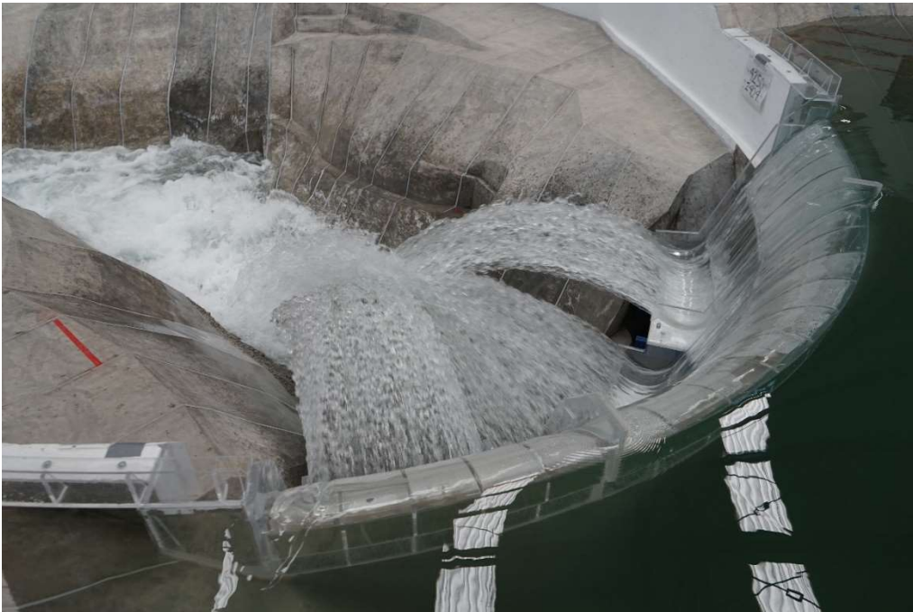
Fotografía 18. La aproximación del flujo del vaso se aprecia en forma uniforme, sin vorticidad apreciable ni velocidades excesivas. Se observan perturbaciones superficiales pequeñas debidas a la contracción del flujo por la geometría circular del eje de la cresta. Q=4,250\text{m}^3/\text{s} . No se observa intrusión de aire en el flujo del vertedor.
