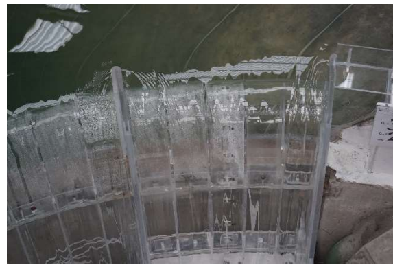
Fotografía 15. Se incrementan las contracciones del flujo en el muro de aproximación de la margen izquierda. Q=3,730\text{m}^3/\text{s} .
