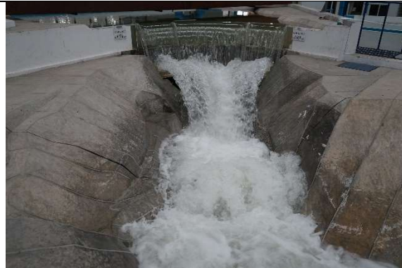
Fotografía. 92. Comportamiento hidráulico del flujo para un gasto de diseño 6010 m 3 /s
