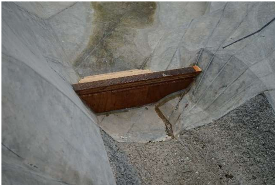
Fotografía. 86. Ataguía sin talud aguas arriba. Vista aguas arriba
