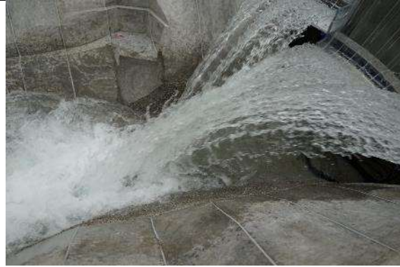
Fotografía. 34 Ingreso de los chorros al cuenco amortiguador. Q=1,985\text{m}^3/\text{s}
