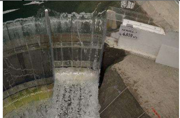
Fotografía. 59. Funcionamiento hidráulico de la pila lateral P3 y central P4, margen izquierda para un gasto asociado a un período de retorno de 1000 años
