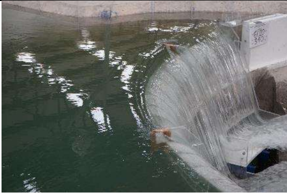
Fotografía. 52. Funcionamiento hidráulico de las pilas centrales P1 y P2 para el gasto de diseño asociado a un período de retorno de 1000 años
