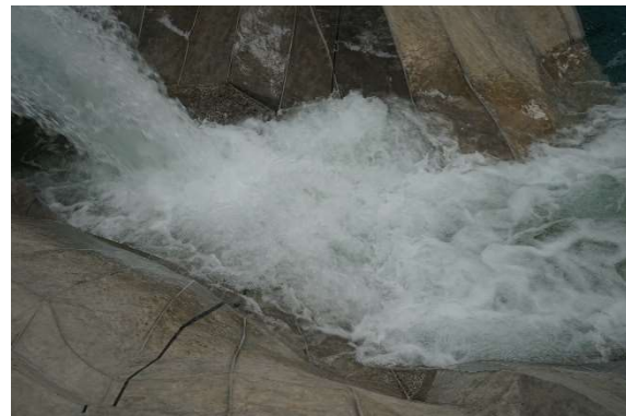
Fotografía. 85. Vista aguas abajo donde se observa el choque del chorro con la ataguía y el alcance del agua
