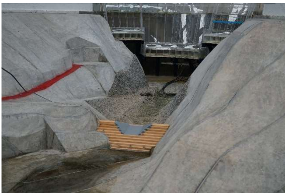
Fotografía. 98. Vista de frente de la ataguía, con escotadura de 45 cm de
