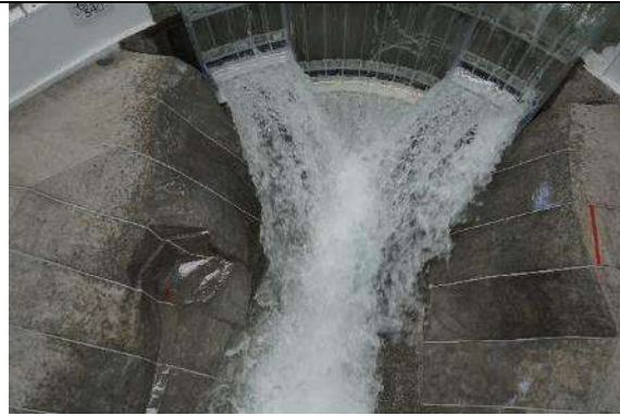
Fotografía. 29. Proyección de los chorros a la salida de los deflectores. Se observa el choque y disipación de energía en forma natural. Q=6,010\text{m}^3/\text{s}
