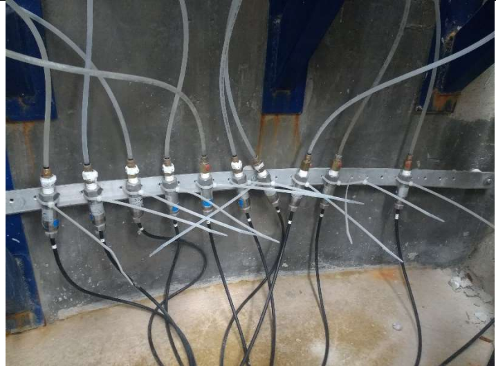
Fotografía. 8. Arreglo de las celdas de presión.
