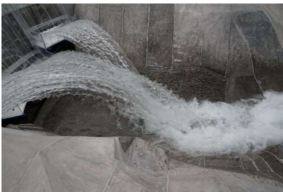
Fotografía 11. Proyección de los chorros a la salida de los deflectores. Se observa el choque y disipación de energía en forma natural. Q=1,985\text{m}^3/\text{s}
