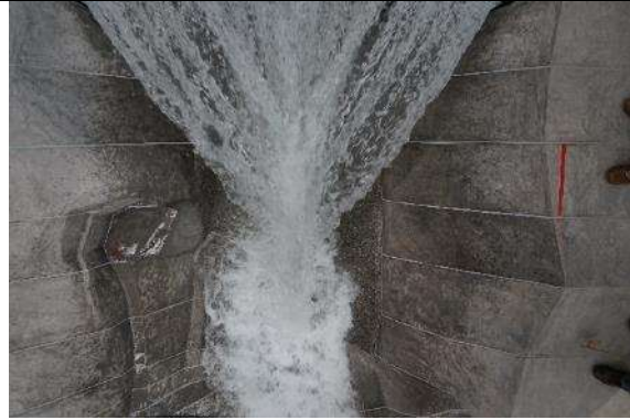
Fotografía. 24. Proyección de los chorros a la salida de los deflectores. Se observa el choque y disipación de energía en forma natural. Q=3,730\text{m}^3/\text{s}
