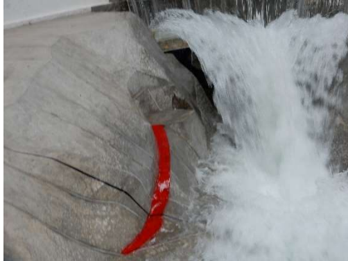
Fotografía. 104. Vista del funcionamiento de la ataguía con ataguía y escotadura, para un Q= 6010 \text{ m}^3/\text{s} .
