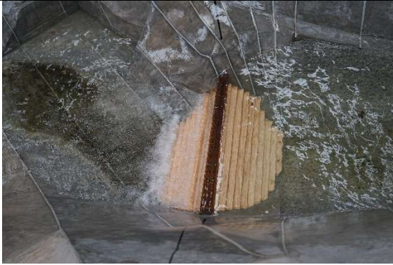
Fotografía. 82. Colocación de la ataguía sobreelevada a la cota 241.50msnm
