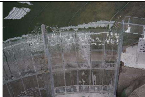
Fotografía. 23. Se incrementan las contracciones del flujo en el muro de aproximación de la margen izquierda. Q=3,730\text{m}^3/\text{s}
