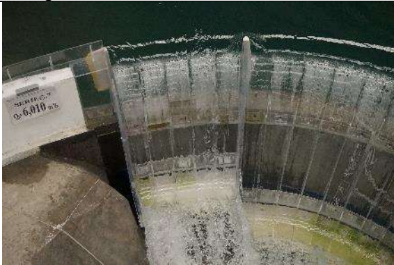
Fotografía. 58. Funcionamiento hidráulico de la pila lateral P3 y central P4, margen derecha para un gasto asociado a un período de retorno de 1000 años
