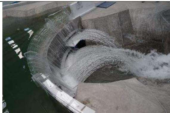
Fotografía. 15. La aproximación del flujo del vaso se aprecia en forma uniforme, sin vorticidad apreciable ni velocidades excesivas. Q=1,985\text{m}^3/\text{s}
