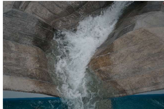
Fotografía 17. Comportamiento del flujo al final del cauce representado en el modelo. Q=3,730\text{m}^3/\text{s} . La perturbación alcanza la sección final del cauce en el modelo.
