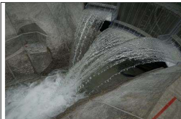
Fotografía. 32. Ingreso de los chorros al cuenco amortiguador. Q=1,215\text{m}^3/\text{s}
