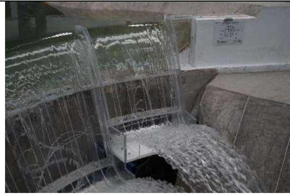
Fotografía. 18. Contracciones más pronunciadas del flujo en el muro de aproximación de la margen izquierda. Q=1,985\text{m}^3/\text{s}
