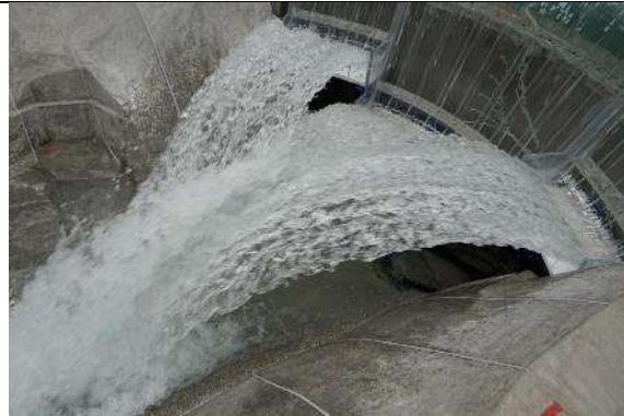
Fotografía. 36. Ingreso de los chorros al cuenco amortiguador. Q=3,730\text{m}^3/\text{s}
