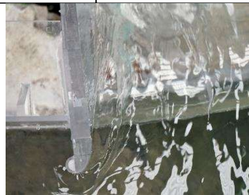
Fotografía. 43. Funcionamiento hidráulico de la pila margen izquierda para un gasto asociado a un período de retorno de 1000 años
