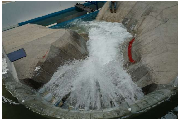
Fotografía. 108. Vista aérea del comportamiento de la caída del chorro en el colchón, para un Q= 6010 \text{ m}^3/\text{s} .
