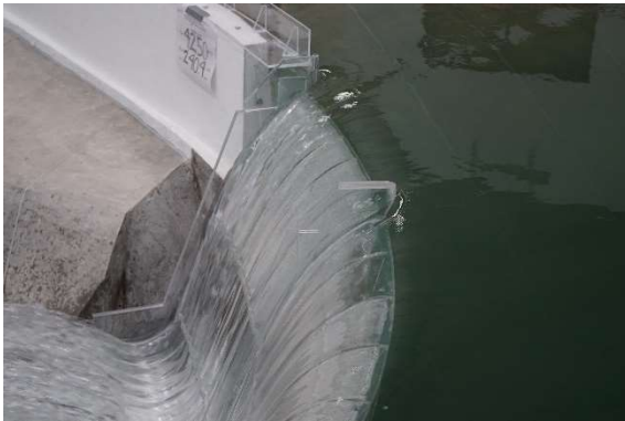
Fotografía 19. Se incrementan las contracciones del flujo en el muro de aproximación de la margen derecha. Q=4,250\text{m}^3/\text{s}
