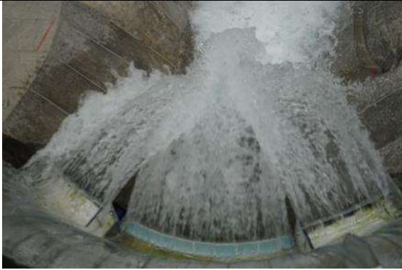
Fotografía. 62. Funcionamiento hidráulico del chorro de despegue para un gasto asociado a un período de retorno de 1000 años
