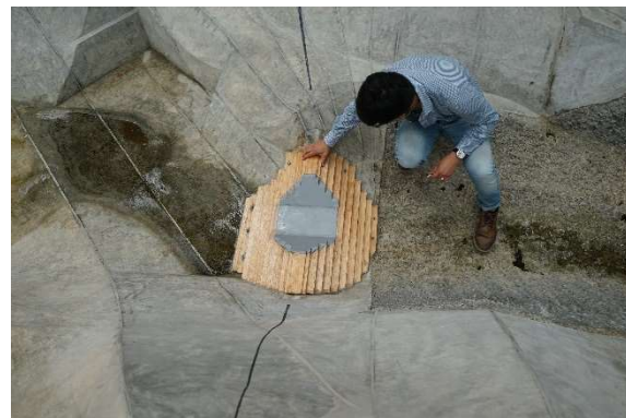
Fotografía. 99. Vista aérea de ataguía con escotadura.
