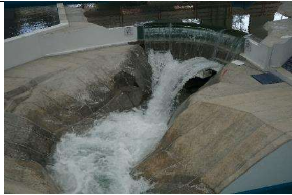
Fotografía. 38. Ingreso de los chorros al cuenco amortiguador. Q=6,010\text{m}^3/\text{s}
