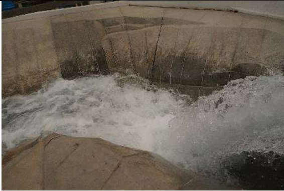
Fotografía. 64. Funcionamiento hidráulico de la caída al cauce del chorro de despegue para un gasto asociado a un período de retorno de 1000 años.
