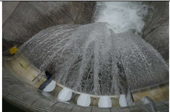
Fotografía. 91. Funcionamiento para un gasto de 1215 m 3 /s.
