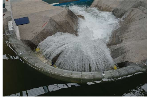
Fotografía. 83. Vista aérea del vertedor, con el gasto de diseño. Se aprecia el alcance del agua al camino de acceso de la ventana V1.
