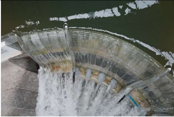
Fotografía. 124. Acceso del flujo al cimacio, pilas centrales y margen derecha. Se observa separación de flujo aceptable.
