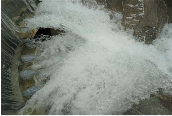
Fotografía 128. Se aprecia el choque de los tres chorros en el aire y la disipación de energía asociada.
