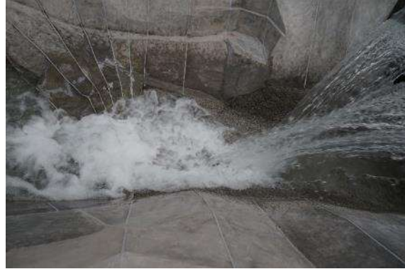
Fotografía. 13. Proyección de los chorros a la salida de los deflectores. Se observa el choque y disipación de energía en forma natural. Q=1,215\text{m}^3/\text{s}
