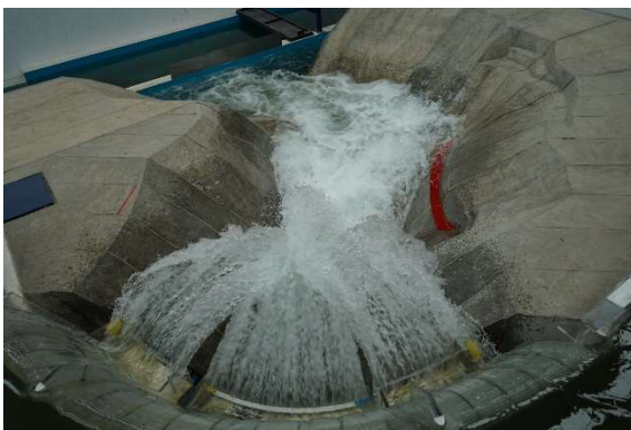
Fotografía. 105. Funcionamiento del vertedor, con ataguía y escotadura de 25.5 m, para un Q= 6010 \text{ m}^3/\text{s} , sin dados en la cubeta del vertedor central.
