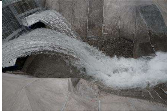
Fotografía. 19. Proyección de los chorros a la salida de los deflectores. Se observa el choque y disipación de energía en forma natural. Q=1,985\text{m}^3/\text{s}
