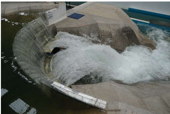
Fotografía. 84. Gasto de diseño. El chorro alcanza a chocar con la ataguía exacerbando el alcance del camino
