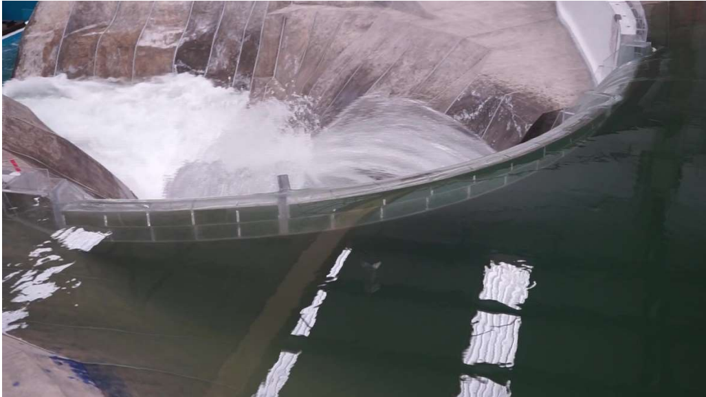
Fotografía 23. La aproximación del flujo del vaso se aprecia en forma uniforme, sin vorticidad apreciable ni velocidades excesivas. Se observan perturbaciones superficiales pequeñas debidas a la contracción del flujo por la geometría circular del eje de la cresta. Q=6,010\text{m}^3/\text{s} . No se observa intrusión de aire en el flujo del vertedor.
