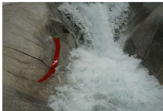
Fotografía. 109. Comportamiento de la caída del chorro en el colchón, para un Q= 6010 \text{ m}^3/\text{s} .
