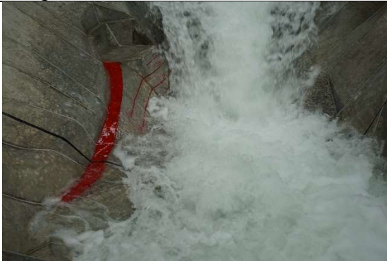
Fotografía. 130. Vista desde aguas abajo del chorro sobre la ataguía.
