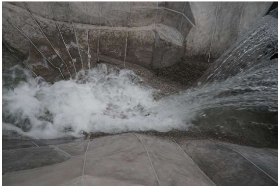
Fotografía 5. Proyección de los chorros a la salida de los deflectores. Se observa el choque y disipación de energía en forma natural. Q=1,215\text{m}^3/\text{s}
