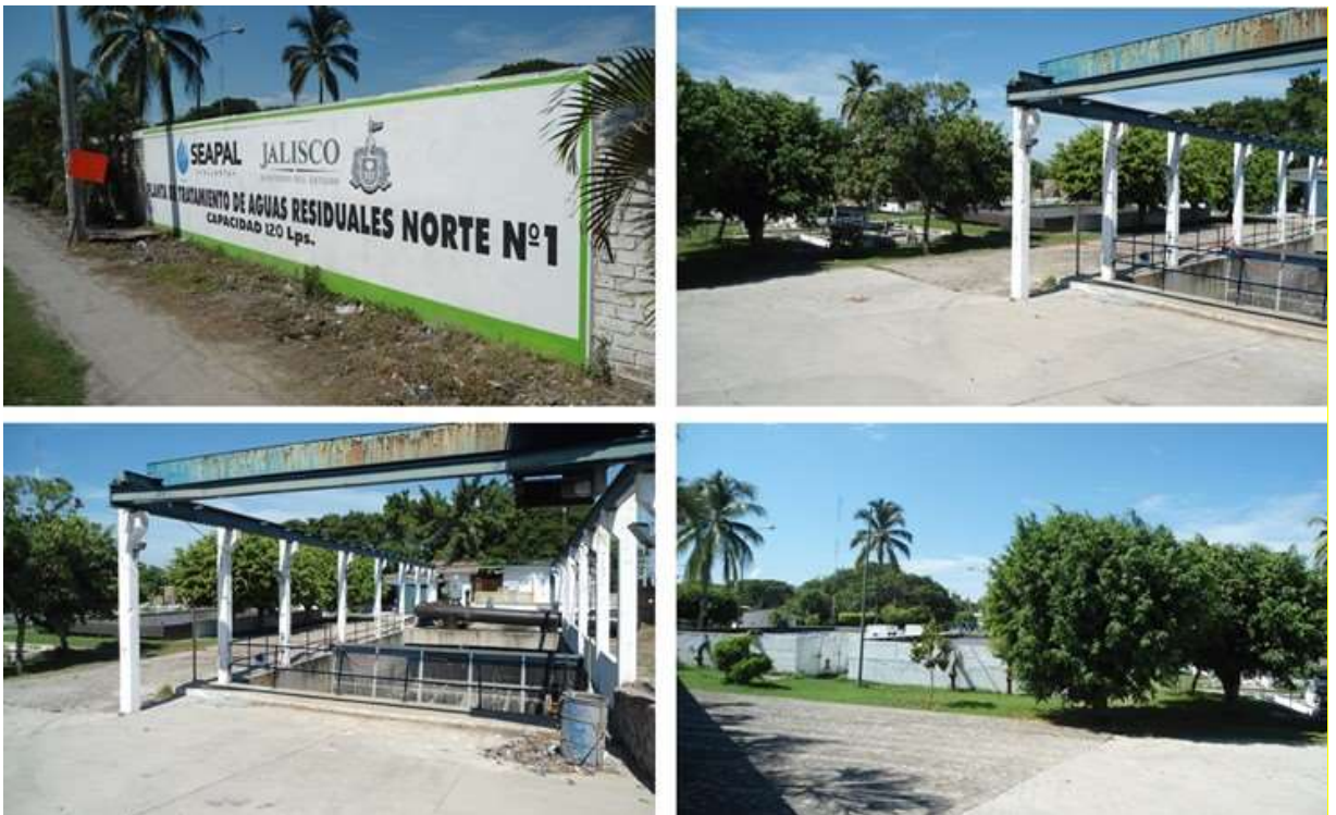
Ilustración 5. Planta de Tratamiento de Aguas Residuales (PTAR) Norte No. 1.
