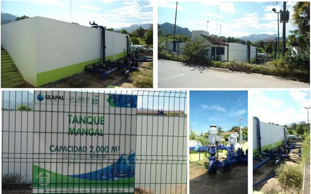
Ilustración 4. Infraestructura del tanque Mangal con capacidad de 2,000 m 3 .
