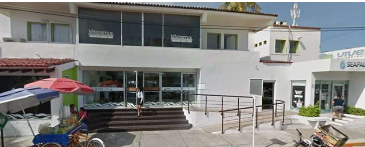
Ilustración 1. Oficinas Centrales del SEAPAL (vista exterior).
