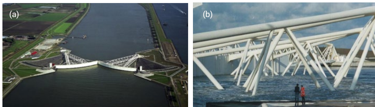
Figura 12.7. Sistema de diques en Países Bajos. a) Dique Maeslant, con sus puertas cerradas, b) Estructura del dique Maeslant. Fuente: holland.com
